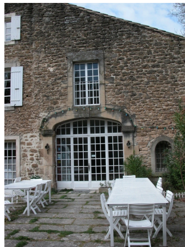
Détail de la façade est du deuxième logis. Phot. Geneviève Jourdan IVR82_20092600006NUCA
