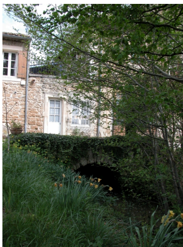
Vue sud de la chambre de la roue et du bief.
