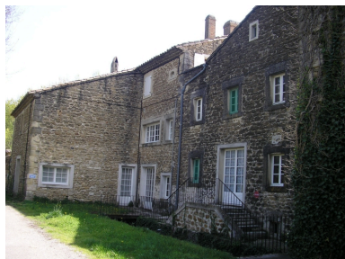
Vue générale nord. Phot. S. Joly IVR82_20092600004NUCA
