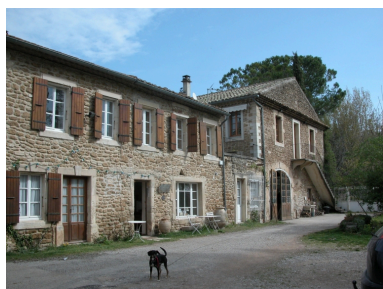
Vue d'ensemble depuis le sud. Phot. Geneviève Jourdan IVR82_20092600001NUCA
