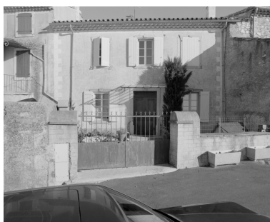
Le Fraysse. L'élévation sur rue d'une maison (C3 320). Phot. Alain Franchella IVR82_19992600698X
