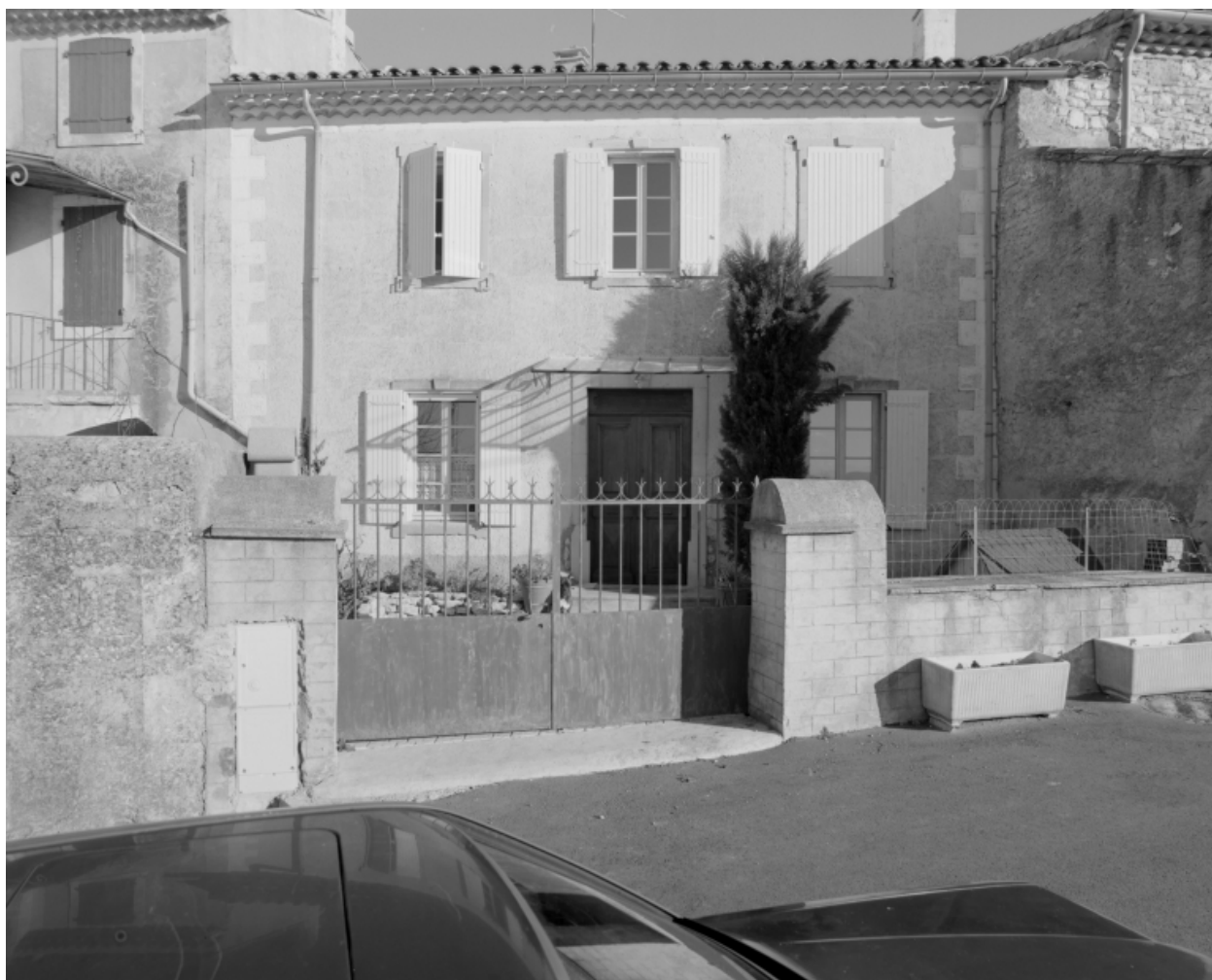
Le Fraysse. L'élévation sur rue d'une maison (C3 320).
