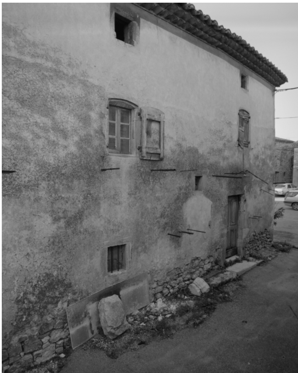
Le Village. Elévation ouest de la maison (A1 159), sur la ruelle.
