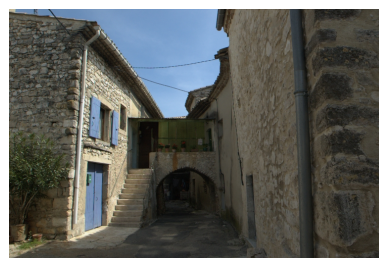
Le village, deux maisons reliées par un corps de passage dit soustet. Phot. Geneviève Jourdan IVR82_20102600507NUCA
