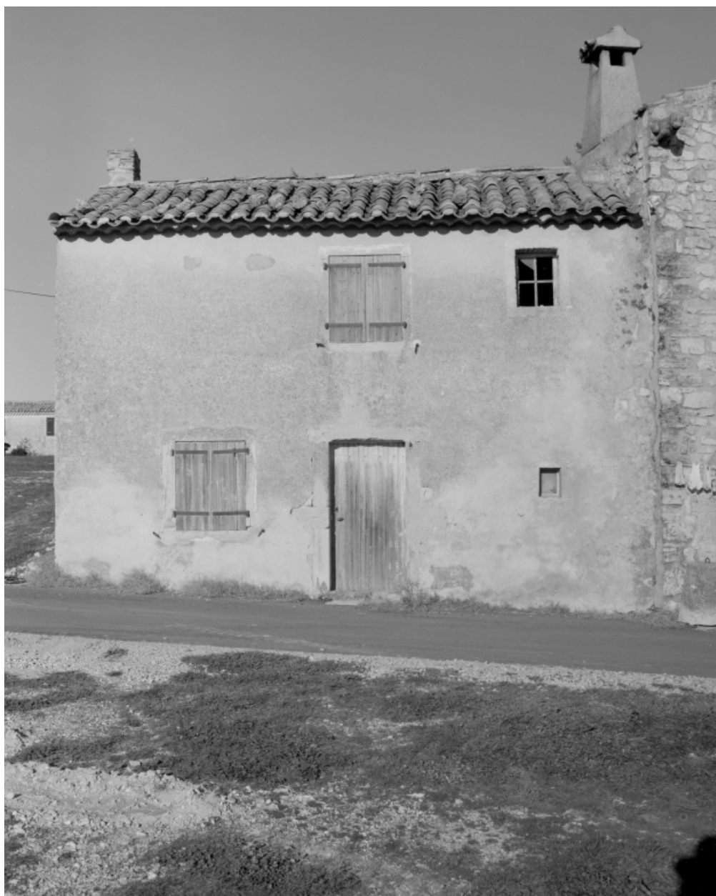
L e Fraysse. Façade de maison (C3 313).
