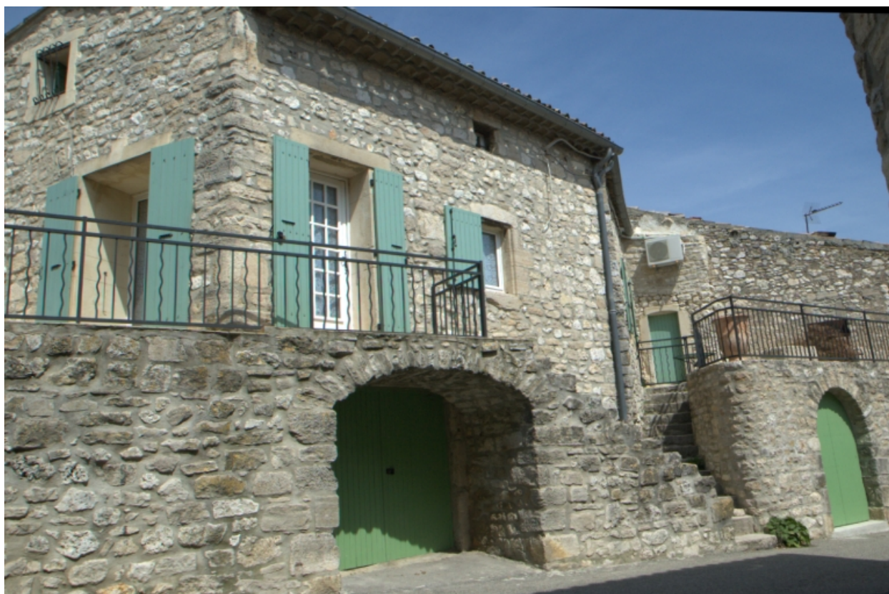
Le village, une maison de type 2, à logis situé au-dessus d'anciennes bergeries et dépendances .
