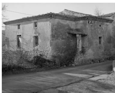
Le village. Vue d'ensemble d'une ancienne ferme (dite fenil Loudet), futurs locaux de la mairie Phot. Alain Franchella IVR82_19992600693X
