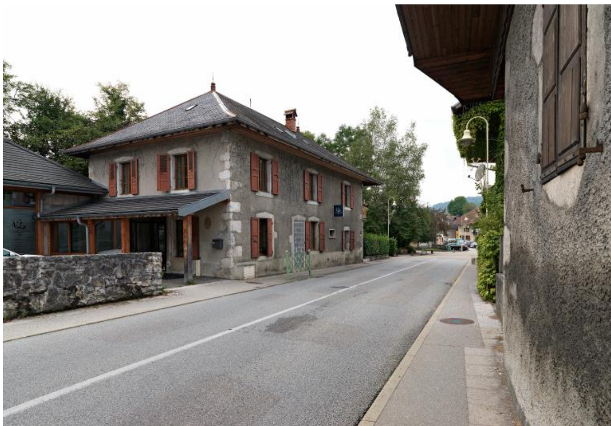
Vue d'ensemble de trois-quarts arrière droit.
