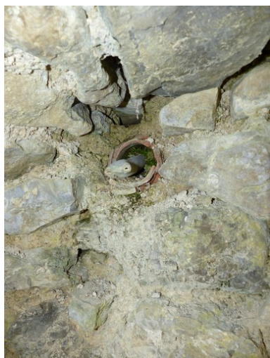
Canalisation d'amenée d'eau. Phot. Alexeï Laurent IVR84_20162600241NUCA
