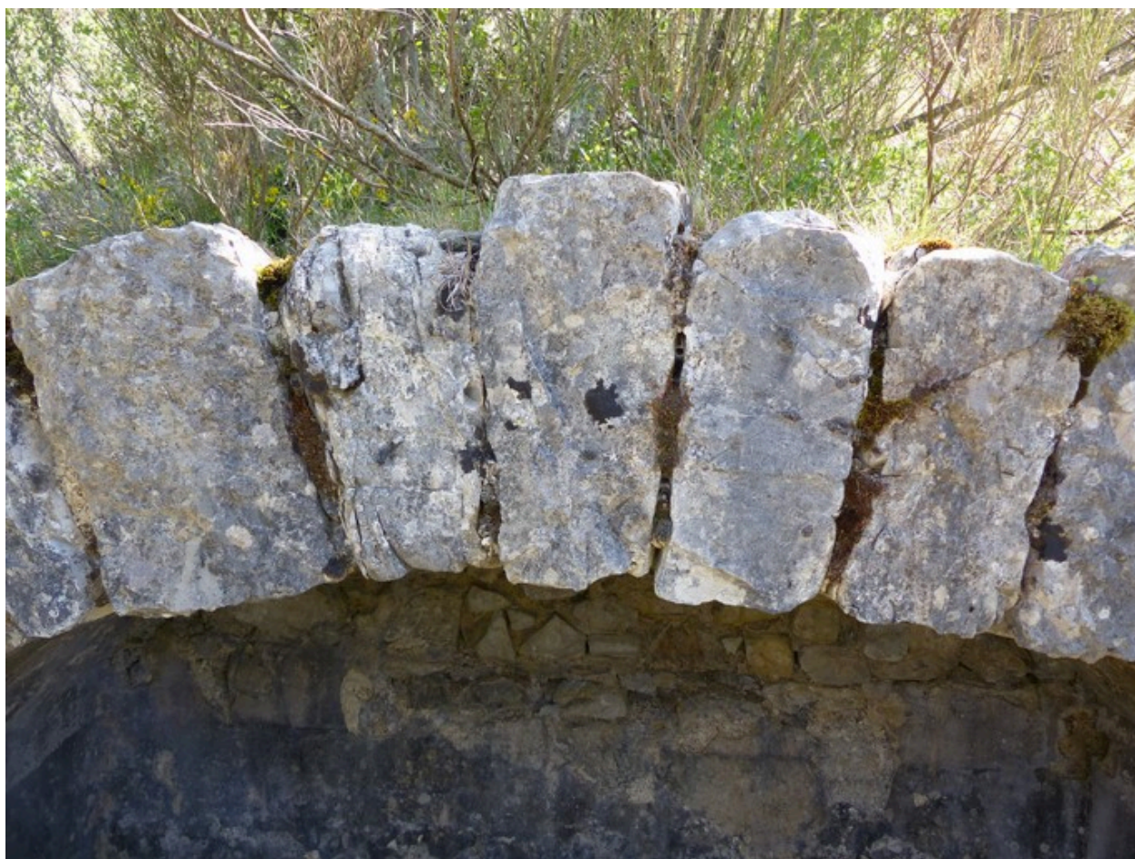
Claveaux de la voûte.
