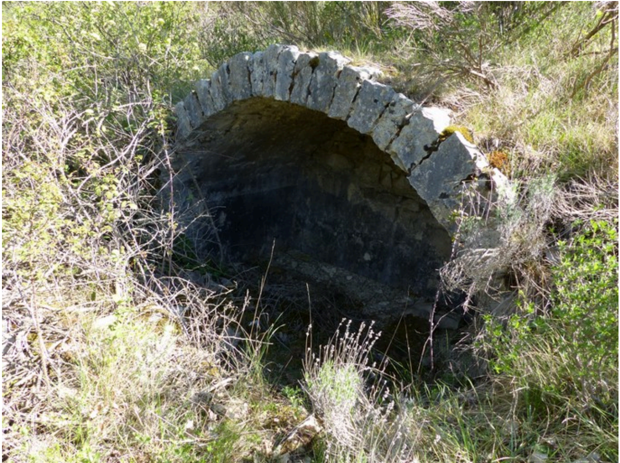
Vue d'ensemble prise du nord-ouest.
