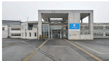
Entrée du lycée Phot. Thierry Leroy IVR84_20217401406NUCAQ
