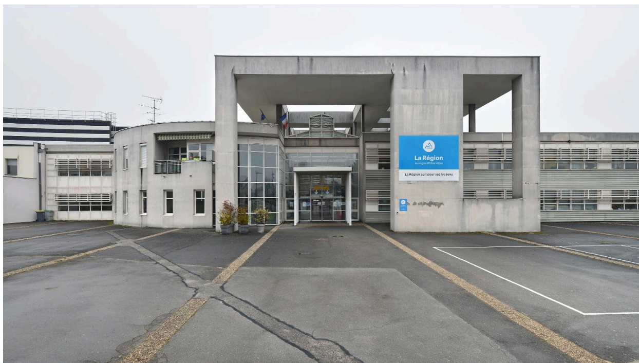
Entrée du lycée
