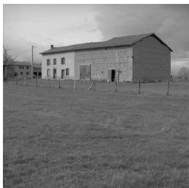
Vue d'ensemble de trois-quarts, depuis le sud. Phot. Eric Dessert IVR82_20024201538X
