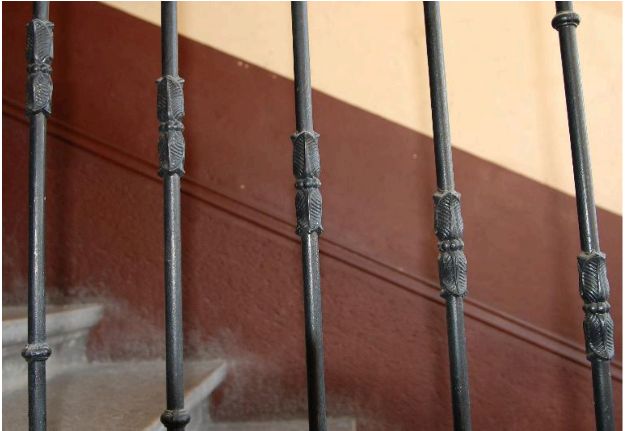
Immeuble sur rue : détail de la rampe d'escalier
