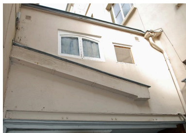
Vue de la loge de concierge, en encorbellement dans la cour Phot. Magali Delavenne IVR82_20146902881NUCA
