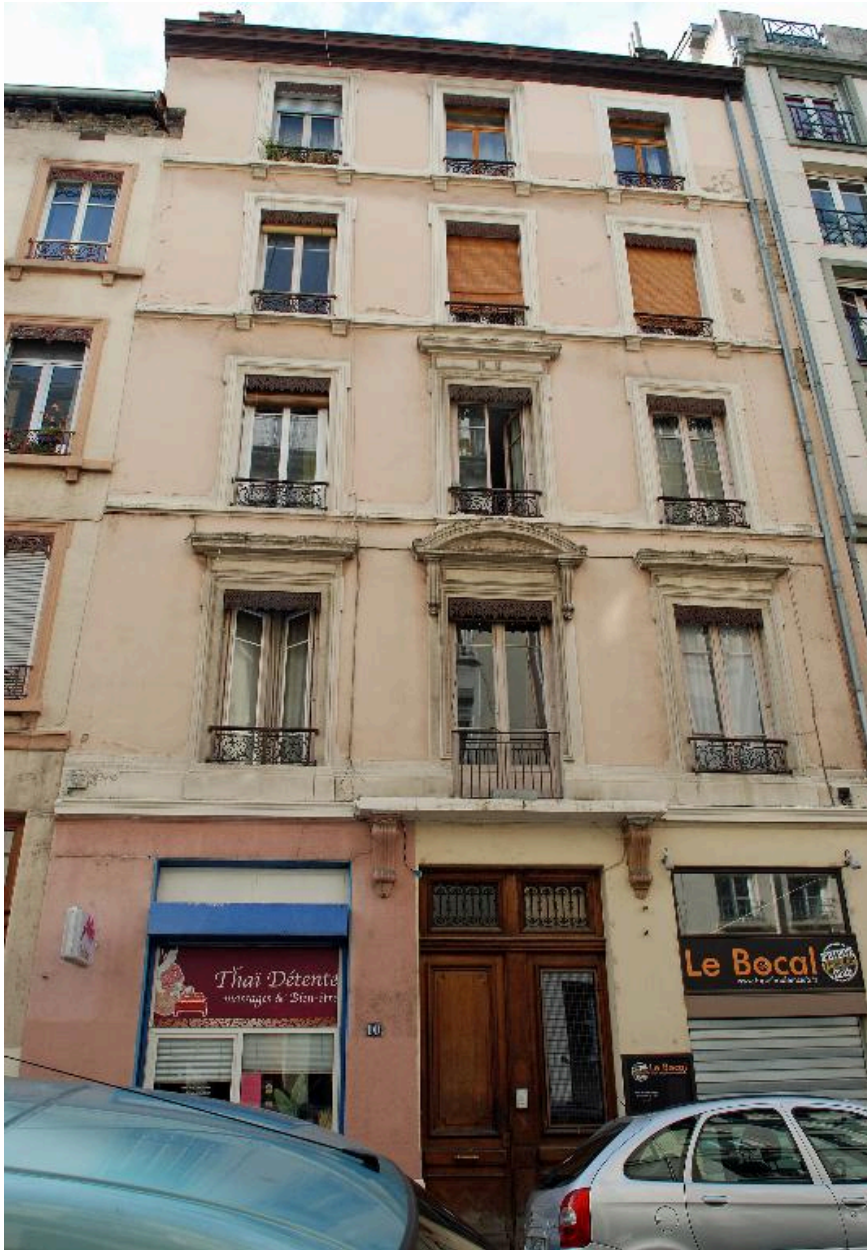
Vue générale de l'immeuble sur rue
