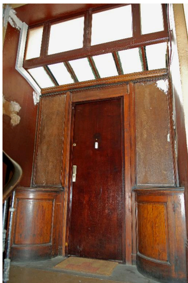
Immeuble sur rue : entrée de la loge de concierge, au niveau du premier repos Phot. Magali Delavenne IVR82_20146902879NUCA
