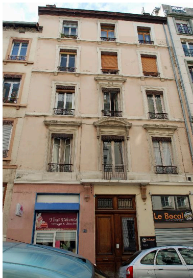
Vue générale de l'immeuble sur rue Phot. Magali Delavenne IVR82_20146902875NUCA
