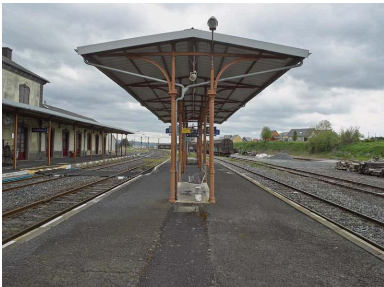
L'abri de voyageurs à colonnettes en fonte ouvragées, sur les quais de la gare.
