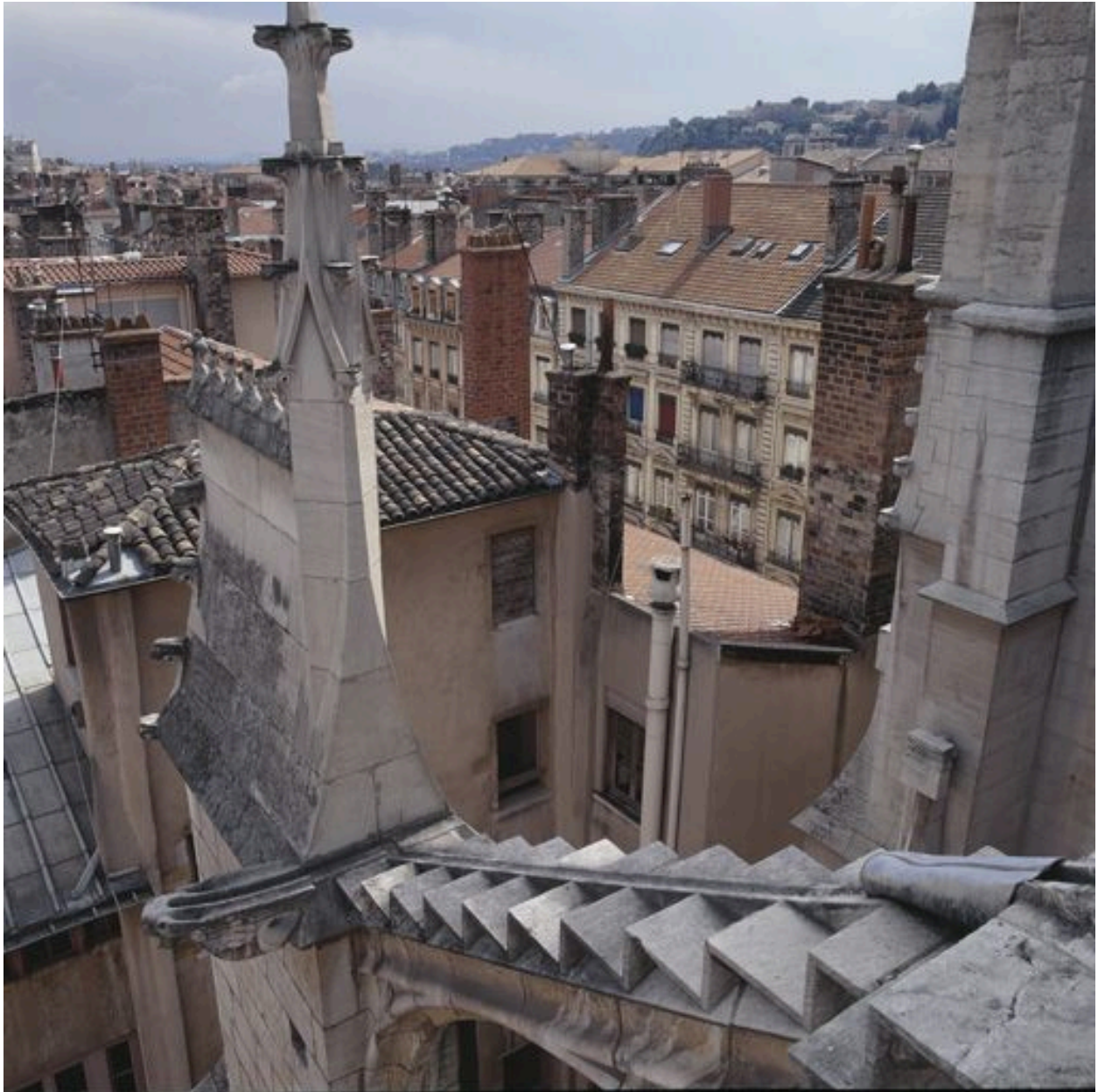
Pavillon d'escalier vu depuis les toits de la collégiale Saint-Nizier
