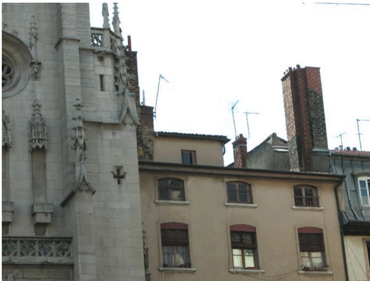
Façade principale, vue des deux derniers niveaux et de la tour surmontant l'escalier
