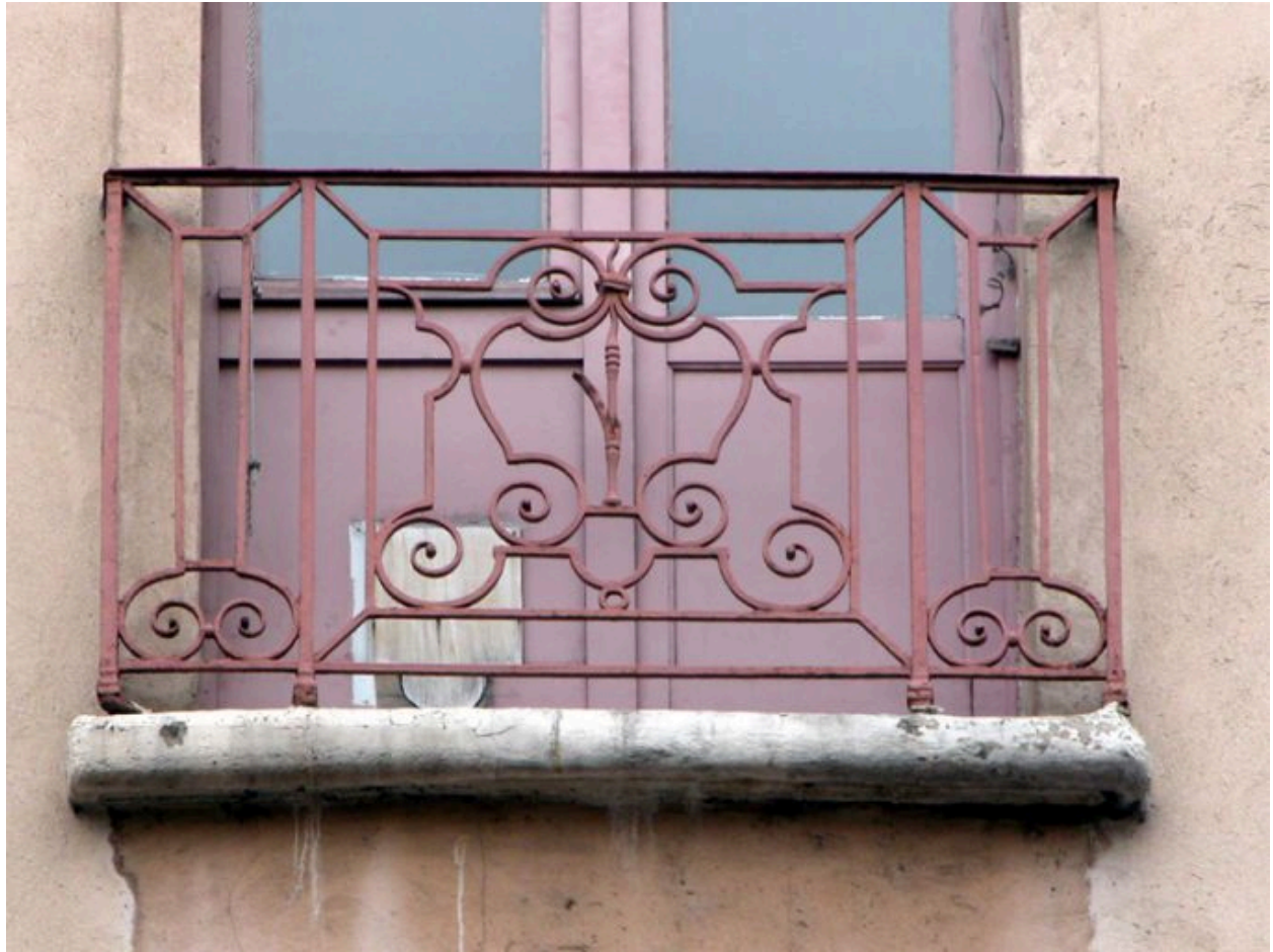
Façade principale, détail d'un balconnet du 4e niveau
