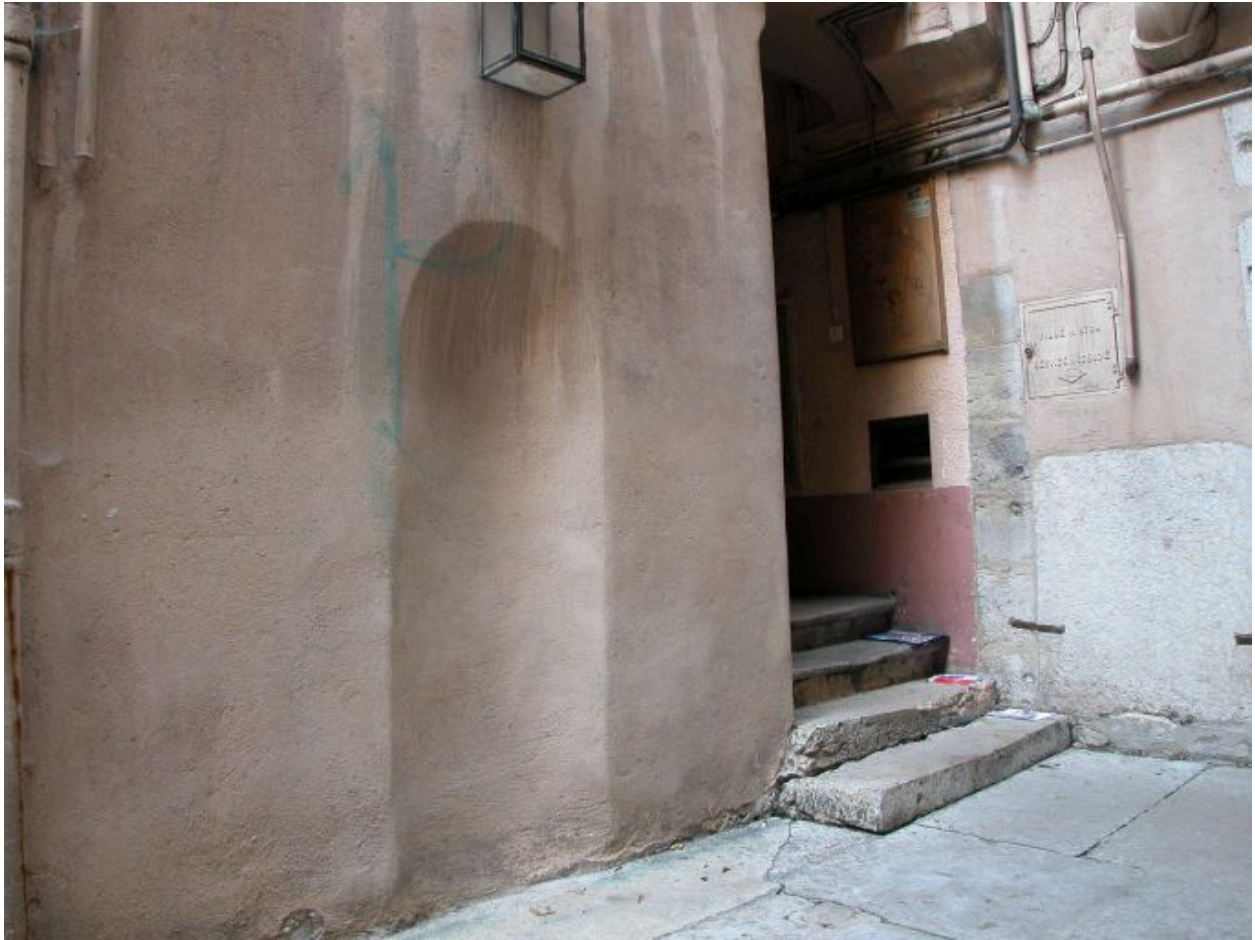
Cour, niche du puits et entrée de l'escalier
