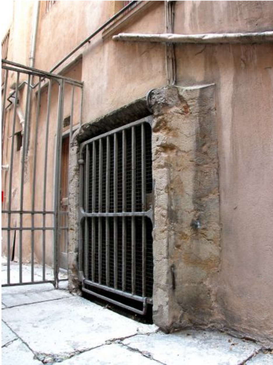
Cour, entrée de l'escalier du sous-sol
