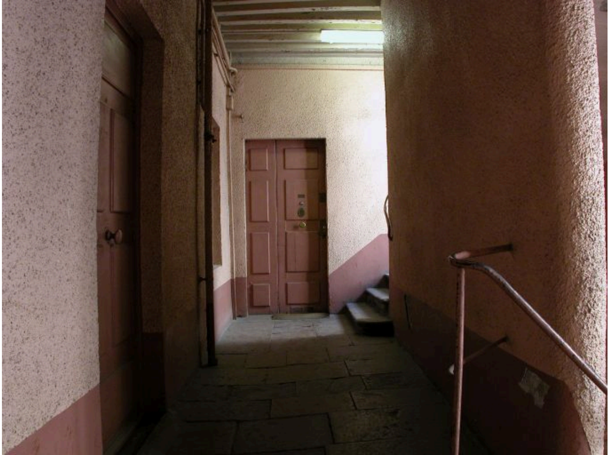
Escalier, palier du 4e étage
