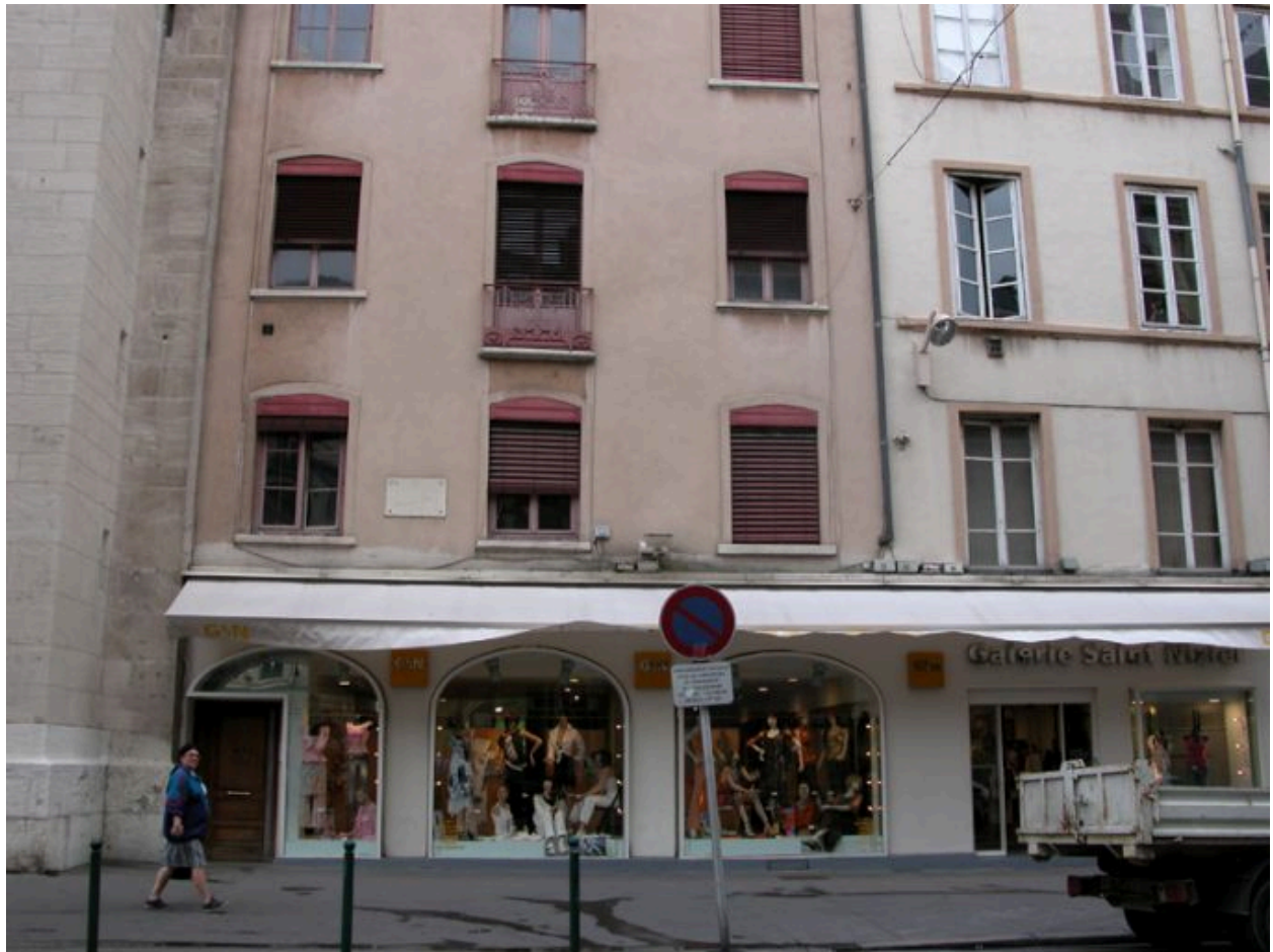
Façade principale, vue des 3 premiers niveaux
