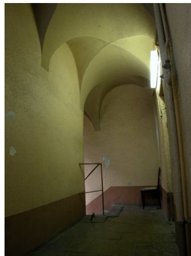
Escalier, palier du 1er étage Phot. Phot. Inv. V. Belle IVR82_20046905770NUCA
