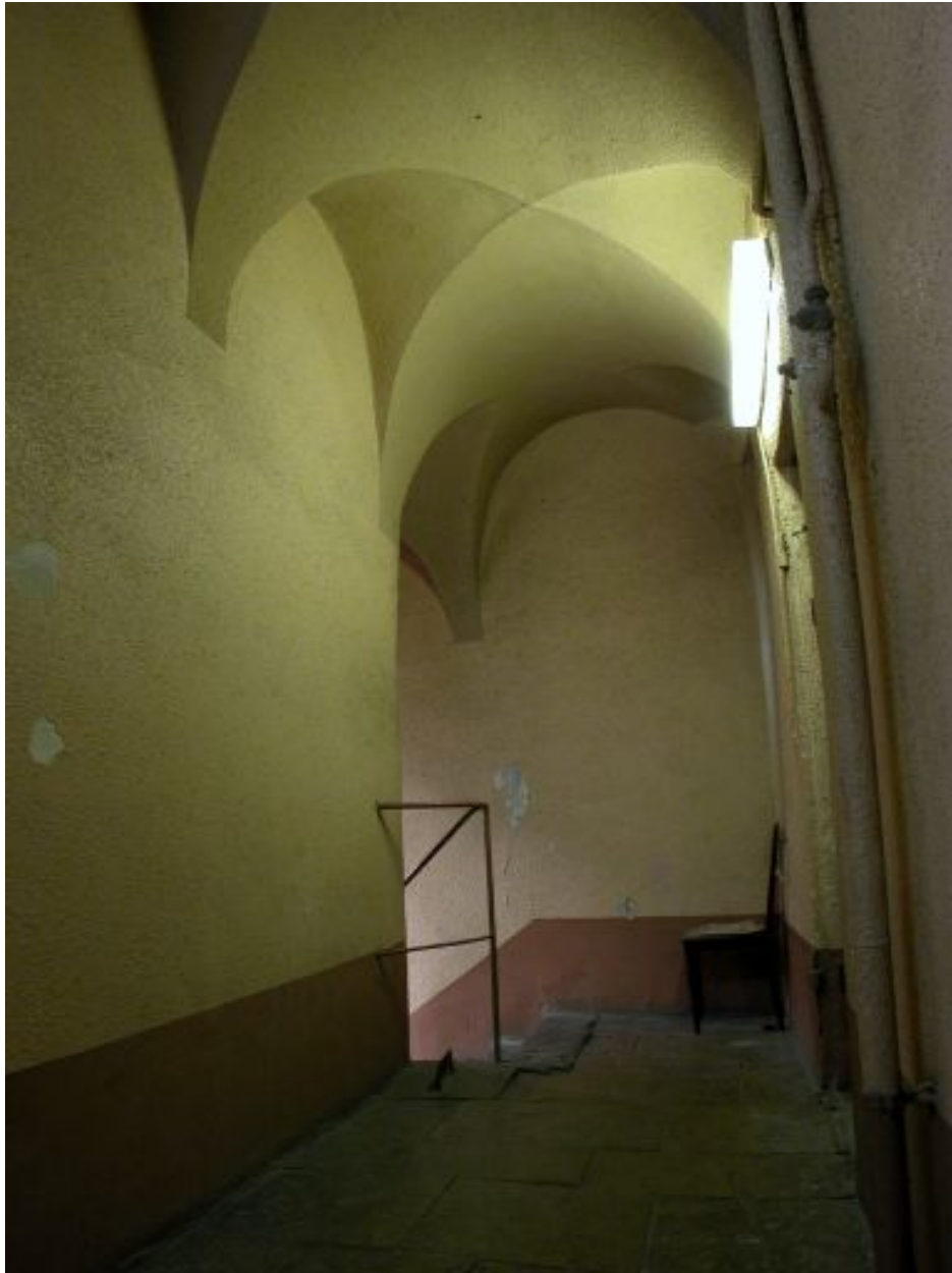
Escalier, palier du 1er étage
