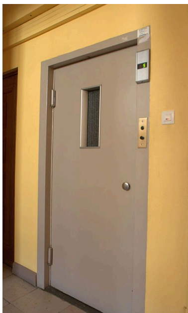
Ascenseur, détail de la porte, rez-de-chaussée Phot. Maryannick Chalabi IVR82_20106903554NUCA
