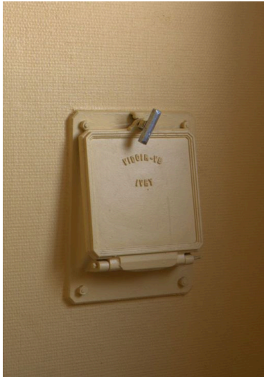
Vide-ordure, détail Phot. Maryannick Chalabi IVR82_20106903558NUCA
