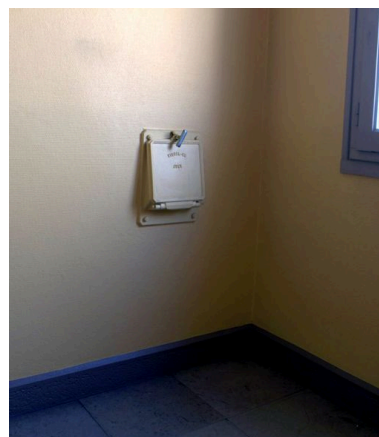
Repos de l'escalier avec vide-ordure Phot. Maryannick Chalabi IVR82_20106903557NUCA
