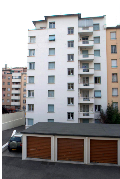
Elévation postérieure depuis l'ouest Phot. Maryannick Chalabi IVR82_20126902450NUCA
