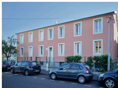
Immeuble collectif (restauré) du n° 8 rue de Beaupeyras, depuis le sud-ouest : un des deux vestiges de la cité.
