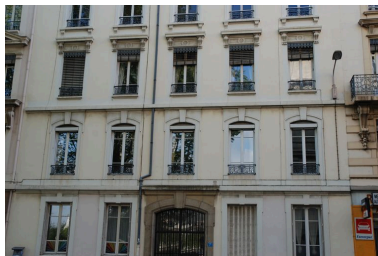
Détail de l'élévation sur rue Phot. Catherine Guillot IVR82_20126900873NUCA
