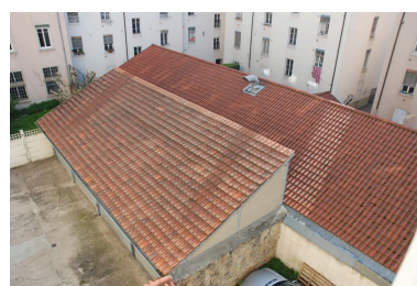
Vue des garages Phot. Catherine Guillot IVR82_20126900877NUCA
