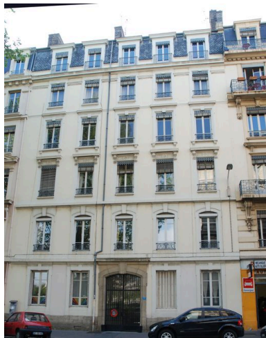
Vue générale Phot. Catherine Guillot IVR82_20126900872NUCA
