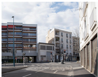
Façades sur le boulevard Aristide-Briand Phot. Félicie Fougère IVR84_20256302378NUCA
