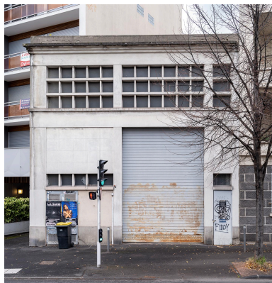
Façade sur le boulevard Aristide-Briand Phot. Michel Pérès IVR84_20256302553NUCA
