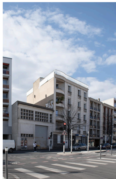
Façades sur le boulevard Aristide-Briand Phot. Félicie Fougère IVR84_20256302377NUCA
