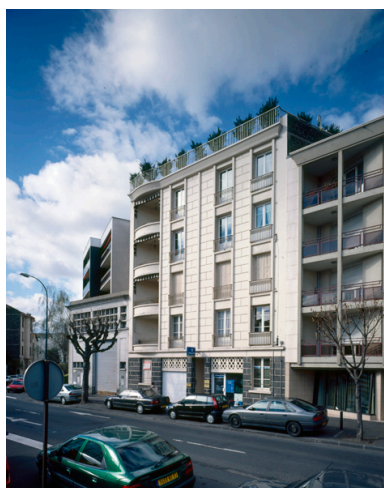
Vue de la façade de l'immeuble Phot. Roger Choplain, Phot. Roland Maston IVR83_20006300388VA
