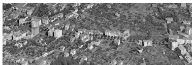
Boulevard Aristide-Briand en 1951 Repro. Félicie Fougère , Autr. auteur inconnu IVR84_20256300819NUC
