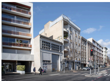
Façades sur le boulevard Aristide-Briand Phot. Félicie Fougère IVR84_20256302379NUCA
