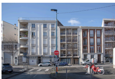
Façades sur le boulevard Aristide-Briand Phot. Félicie Fougère IVR84_20256302374NUCA
