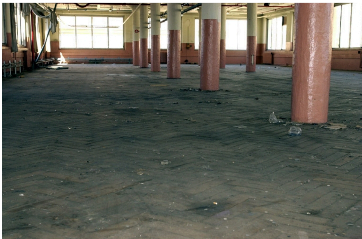
Vue des ateliers : parquet chevron
