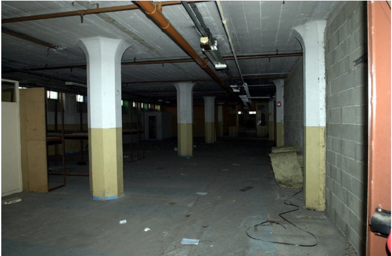
Atelier en sous-sol : pilier octogonaux
