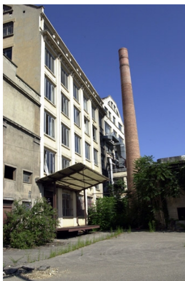
Vue de la cheminée avant la démolition Phot. Nadine Halitim-Dubois IVR82_20036901896NUCA
