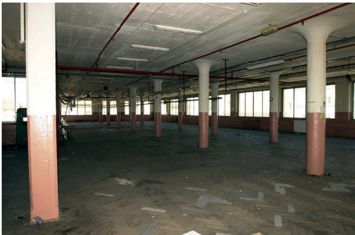
Vue d'ensemble des ateliers du bâtiment de 1914, piliers béton
