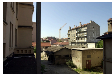
Vue nord, transformateur électrique Phot. Nadine Halitim-Dubois IVR82_20036901907NUCA
