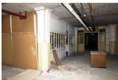
Séparation structure bois Phot. Nadine Halitim-Dubois IVR82_20036901950NUCA
