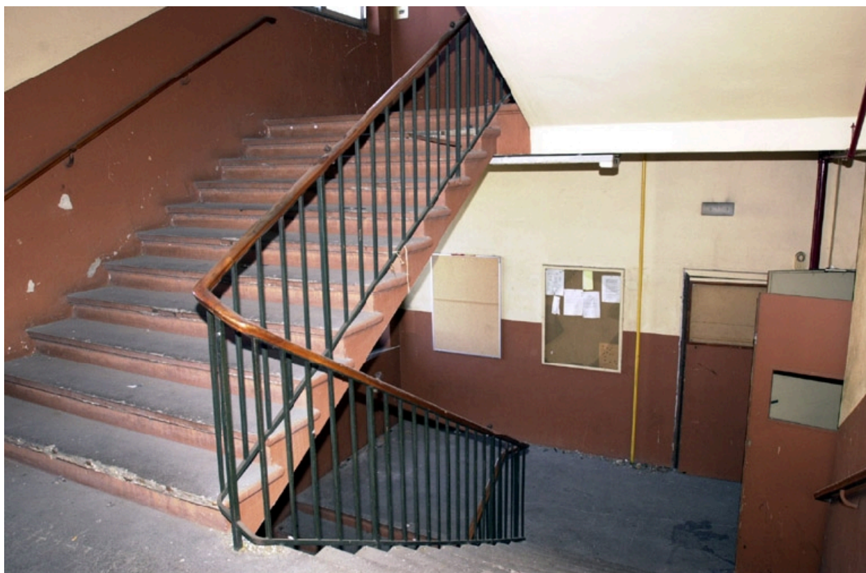
Vue de l'escalier
