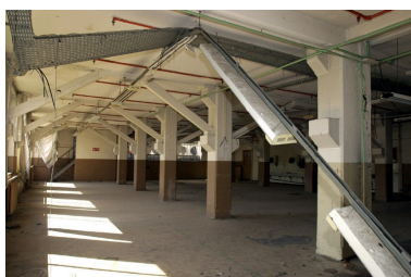
Vue du dernier étage Phot. Nadine Halitim-Dubois IVR82_20036901912NUCA
