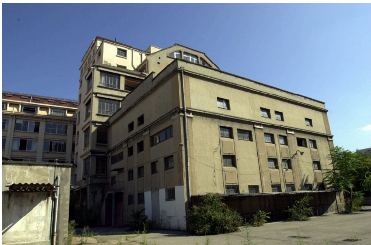
Vue du bâtiment des années 30
