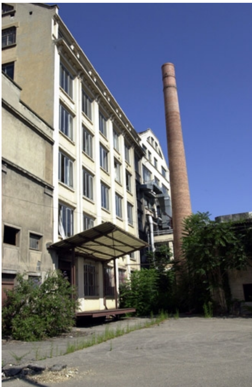
Vue de la cheminée avant la démolition
