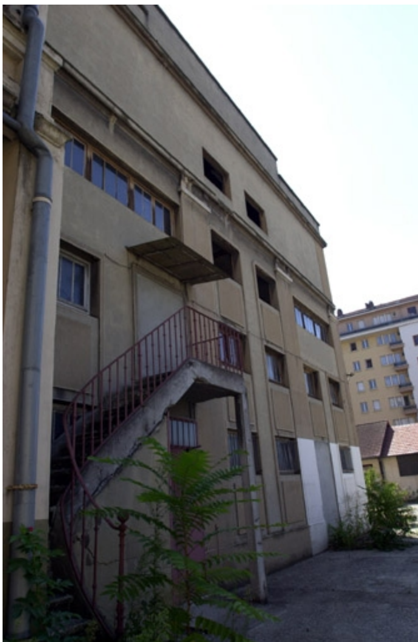
Vue nord du bâtiment des années 30
