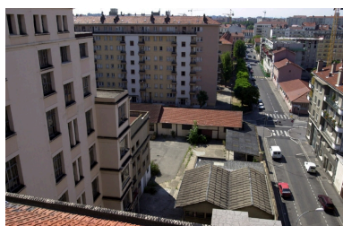
Vue d'ensemble nord Phot. Nadine Halitim-Dubois IVR82_20036901943NUCA
