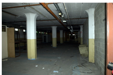
Atelier en sous-sol : pilier octogonaux Phot. Nadine Halitim-Dubois IVR82_20036901949NUCA
