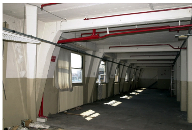
Détail structure béton Phot. Nadine Halitim-Dubois IVR82_20036901927NUCA
