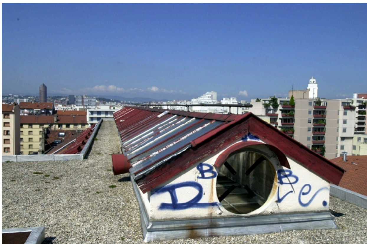
Lanterneau sur toit de l'atelier sous comble
