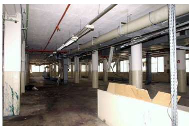
Vue de l'atelier du rez-de-chaussée Phot. Nadine Halitim-Dubois IVR82_20036901909NUCA
