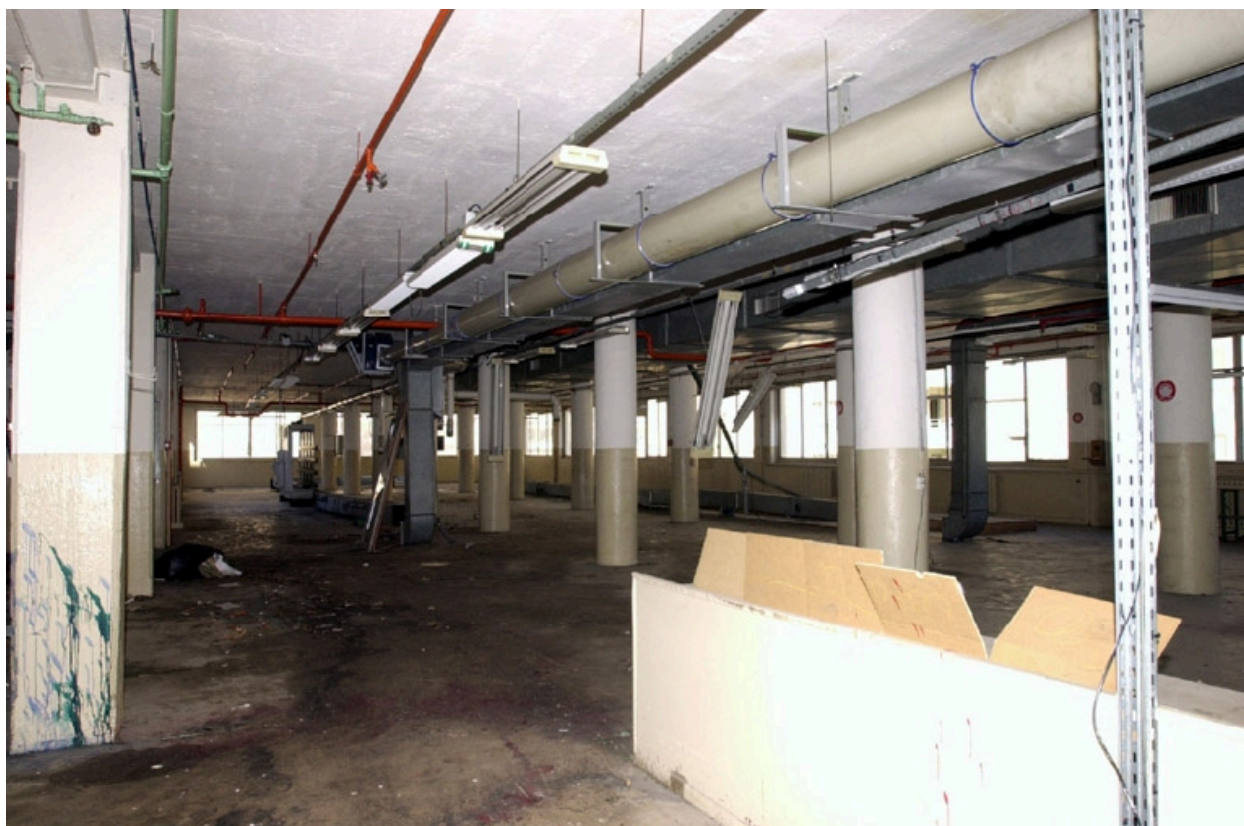
Vue de l'atelier du rez-de-chaussée
