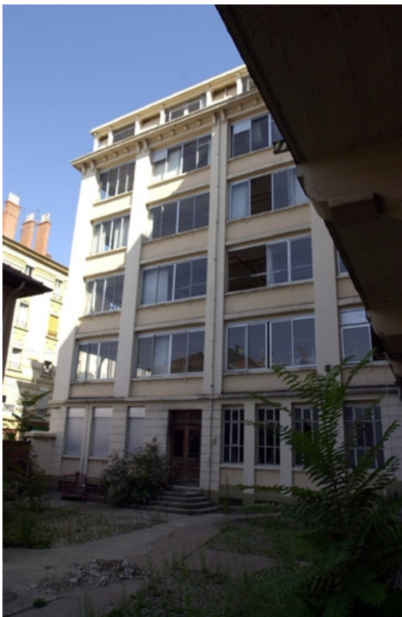
Vue du bâtiment des années 20
