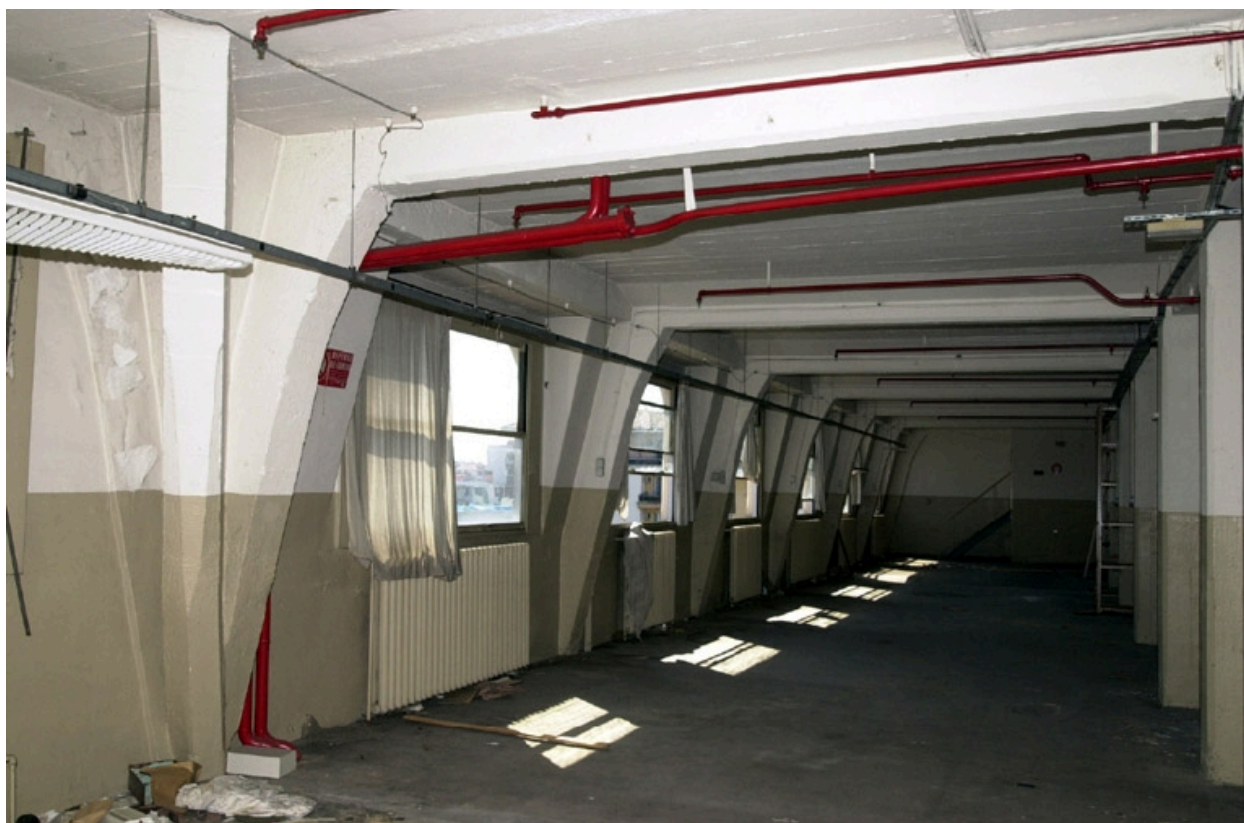
Détail structure béton
