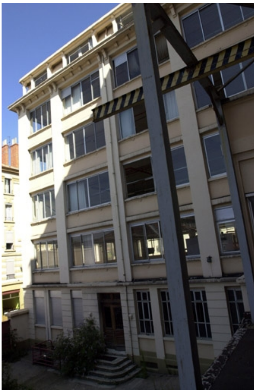
Façade sud du bâtiment des années 20
