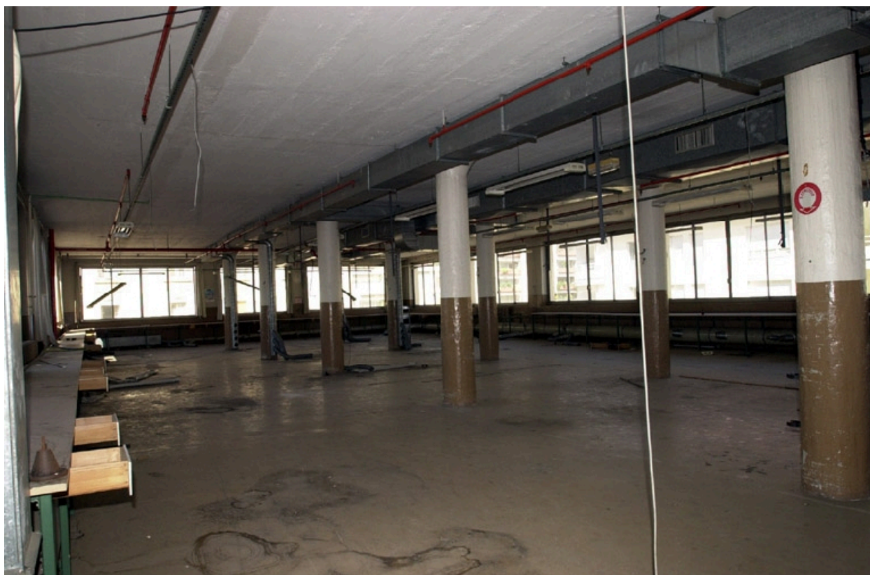
Atelier en étage : pilier circulaire en béton
