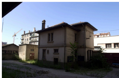
Bureau et maison du gardien, entrée ouest du site Phot. Nadine Halitim-Dubois IVR82_20036901902NUCA
