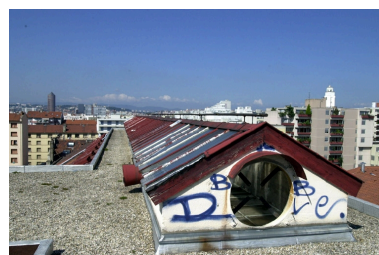
Lanterneau sur toit de l'atelier sous comble Phot. Nadine Halitim-Dubois IVR82_20036901940NUCA
