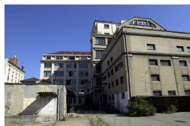
Vue d'ensemble est Phot. Nadine Halitim-Dubois IVR82_20036901898NUCA
