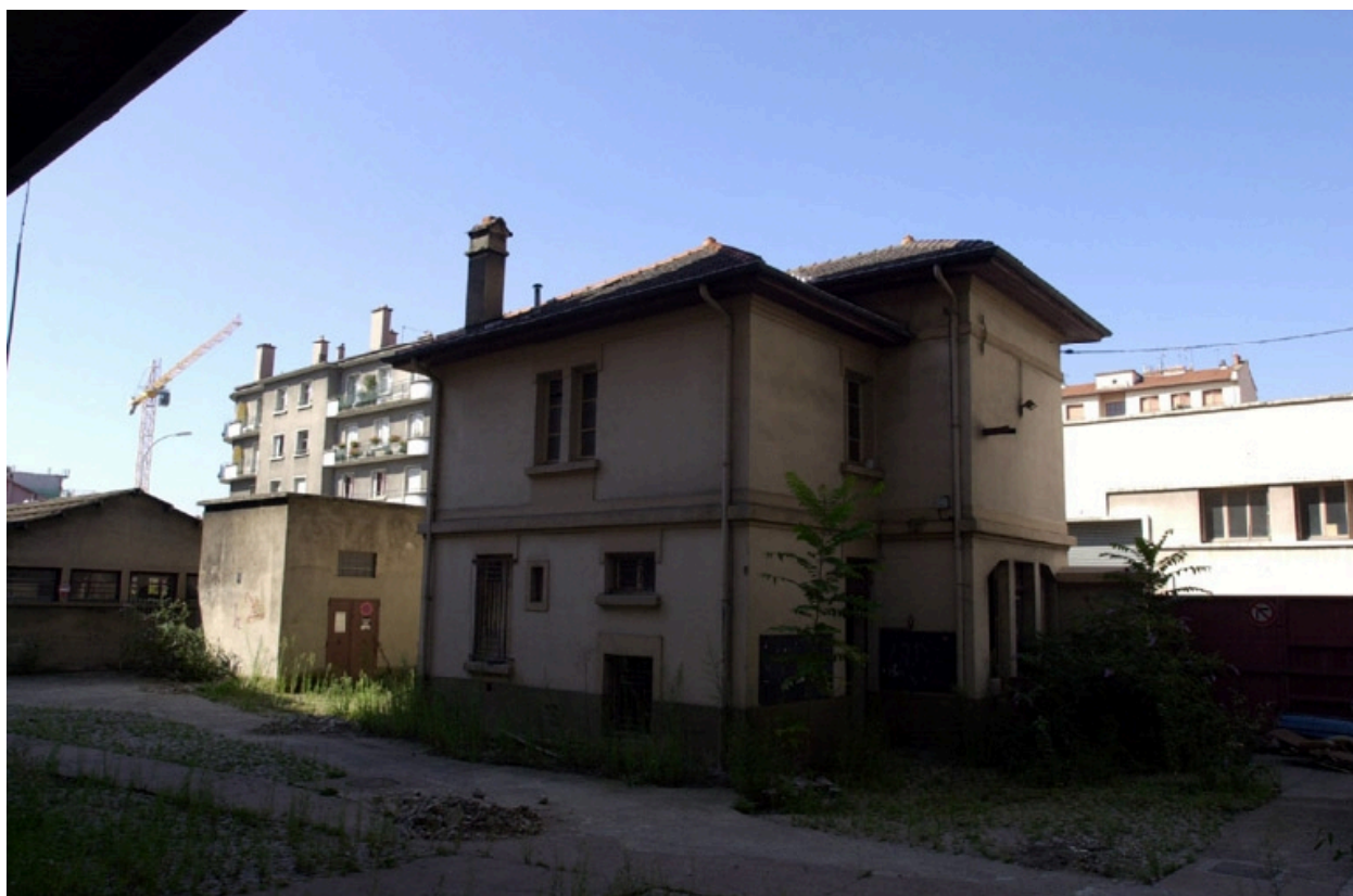
Bureau et maison du gardien, entrée ouest du site
