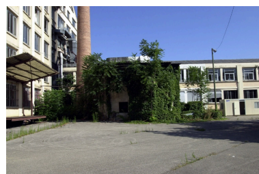
Embase de cheminée Phot. Nadine Halitim-Dubois IVR82_20036901895NUCA
