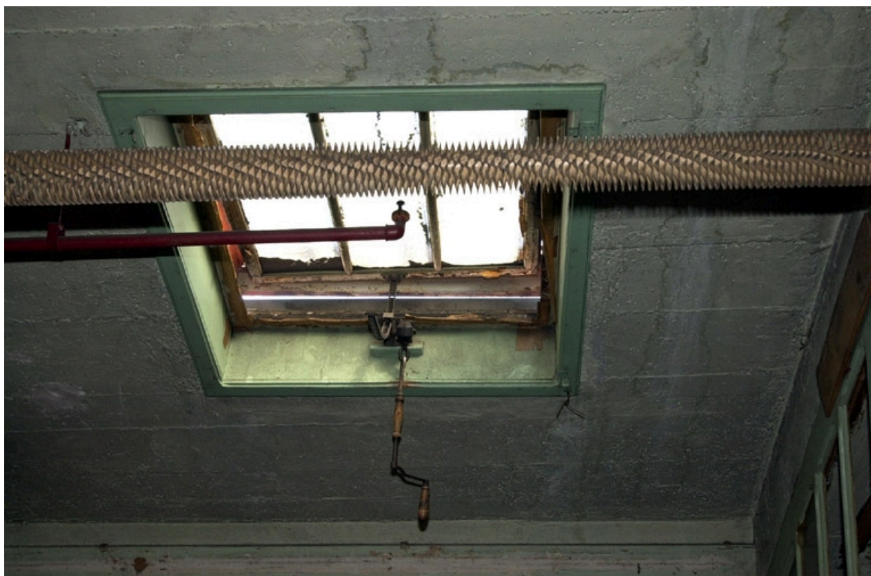
Lucarne, vue de l'intérieur
