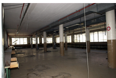
Atelier en étage : pilier circulaire en béton Phot. Nadine Halitim-Dubois IVR82_20036901915NUCA
