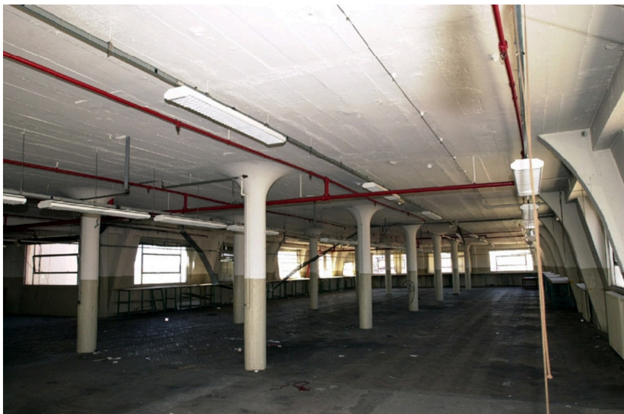
Vue des atelier du bâtiment de 1914
