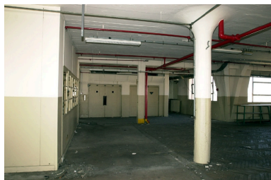
Emplacement des monte-charge Phot. Nadine Halitim-Dubois IVR82_20036901926NUCA
