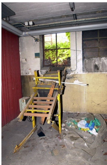
Détail sous-sol Phot. Nadine Halitim-Dubois IVR82_20036901952NUCA
