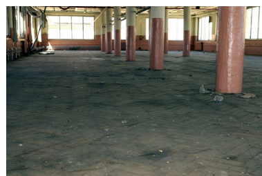
Vue des ateliers : parquet chevron Phot. Nadine Halitim-Dubois IVR82_20036901922NUCA
