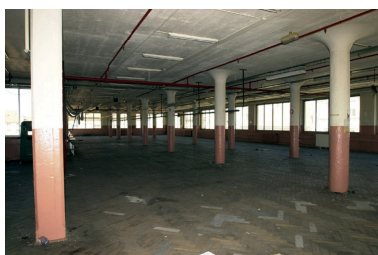
Vue d'ensemble des ateliers du bâtiment de 1914, piliers béton Phot. Nadine Halitim-Dubois IVR82_20036901921NUCA
