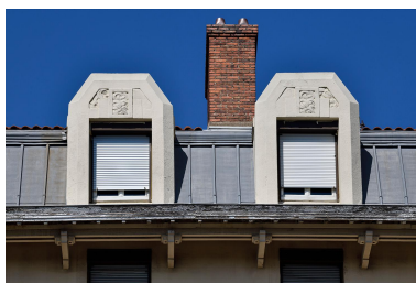
Détail de deux lucarnes Phot. Thierry Leroy IVR84_20266900673NUCAQ
