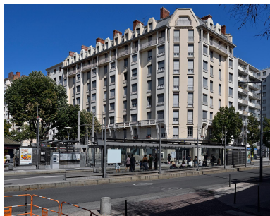
Vue générale Phot. Thierry Leroy IVR84_20266900671NUCAQ
