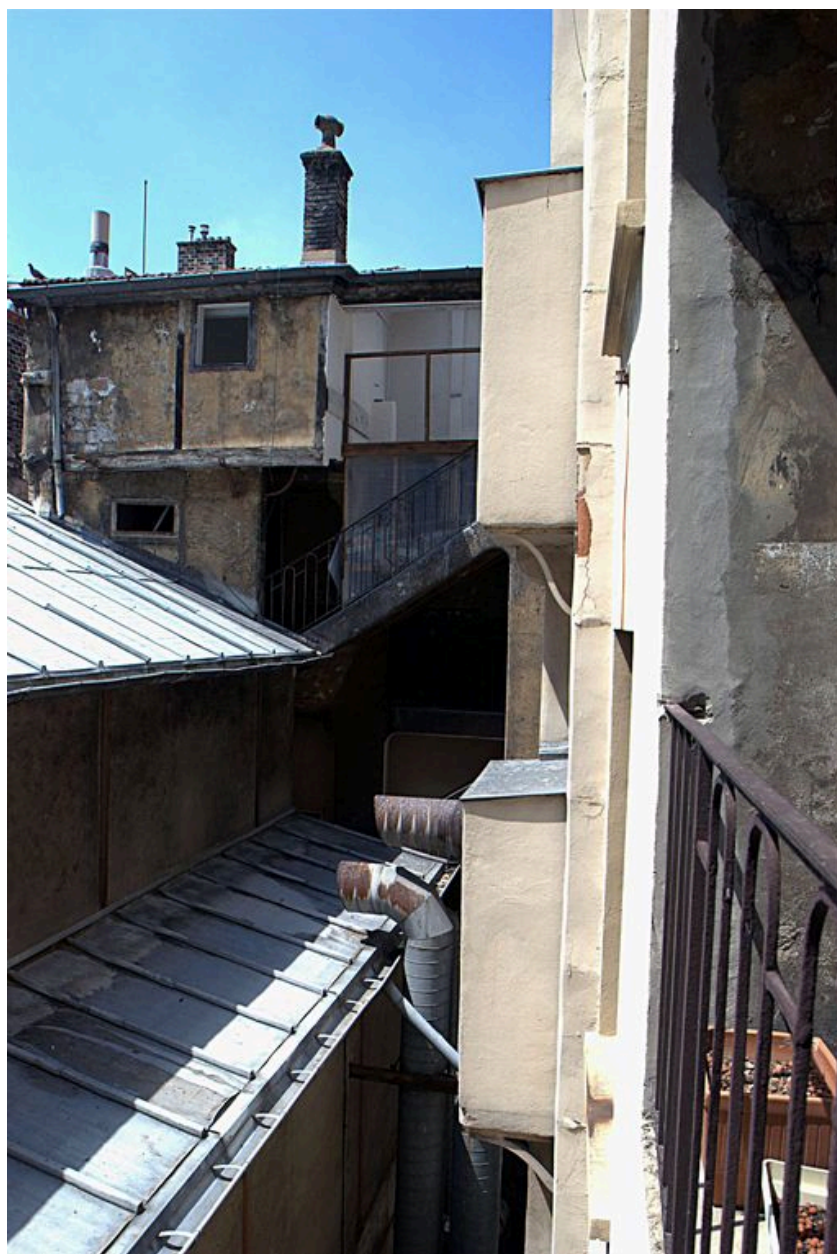
Elévation postérieure, détail des toilettes en encorbellement
