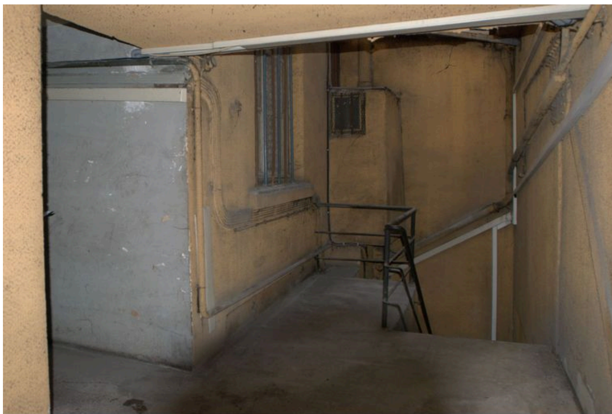
Terrasse couverte au débouché de l'escalier en équerre
