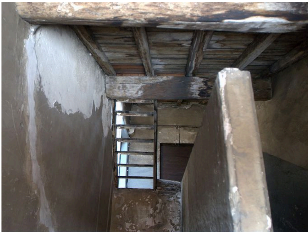
Vue du comble depuis le dernier repos de l'escalier
