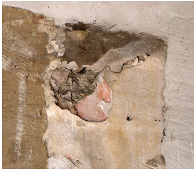
Cage d'escalier, détail des anciens enduits et badigeons Phot. Catherine Guégan IVR82_20086903119NUCA
