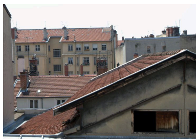
Vue du comble de la salle de cinéma, détail Phot. Catherine Guégan IVR82_20096900503NUCA
