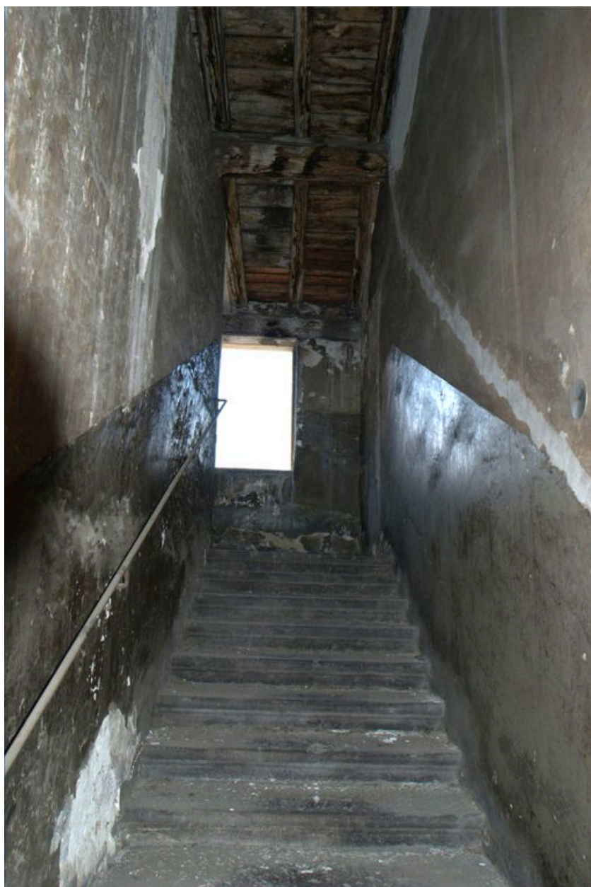
Escalier, vue de la 5e volée et de la charpente
