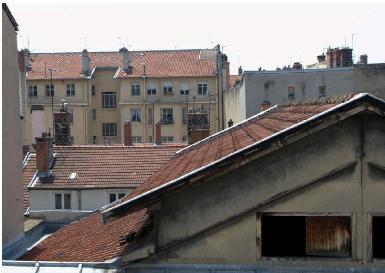
Vue du comble de la salle de cinéma, détail
