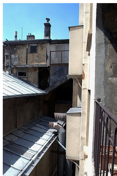
Elévation postérieure, détail des toilettes en encorbellement Phot. Catherine Guégan IVR82_20096900510NUCA
