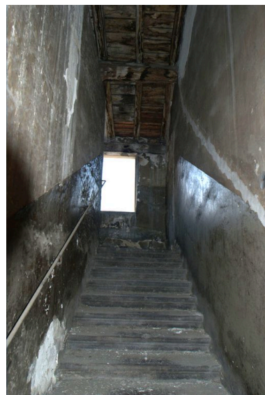
Escalier, vue de la 5e volée et de la charpente Phot. Catherine Guégan IVR82_20086903122NUCA
