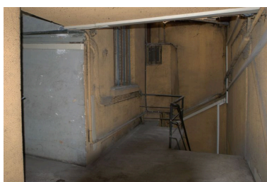
Terrasse couverte au débouché de l'escalier en équerre Phot. Catherine Guégan IVR82_20086903114NUCA
