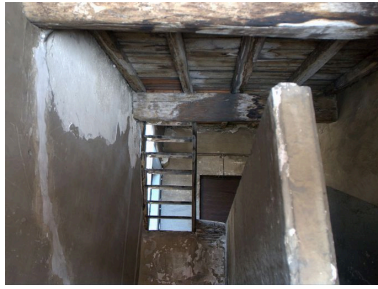
Vue du comble depuis le dernier repos de l'escalier Phot. Catherine Guégan IVR82_20086903123NUCA
