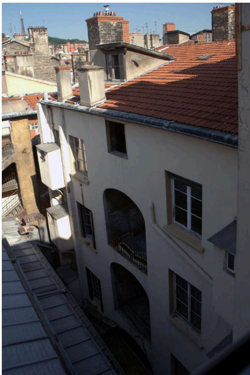
Vue de l'élévation postérieure
