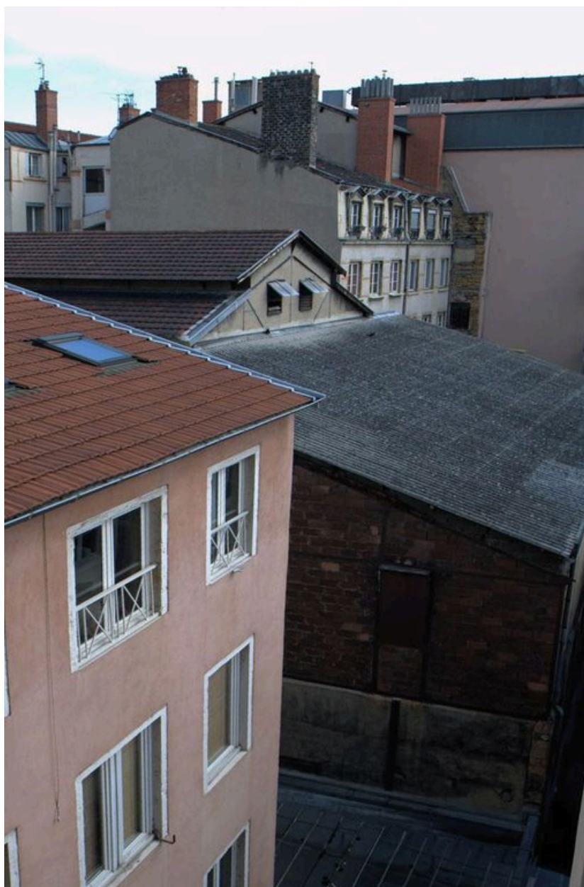
Vue de la salle de cinéma depuis l'ouest
