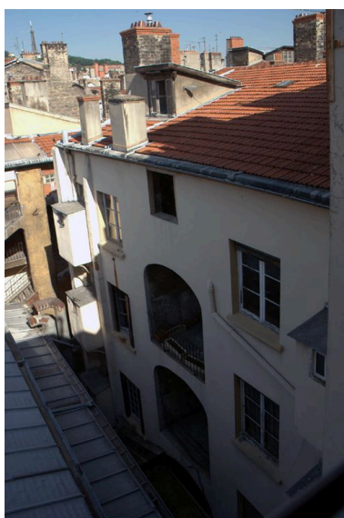
Vue de l'élévation postérieure Phot. Catherine Guégan IVR82_20096900647NUCA
