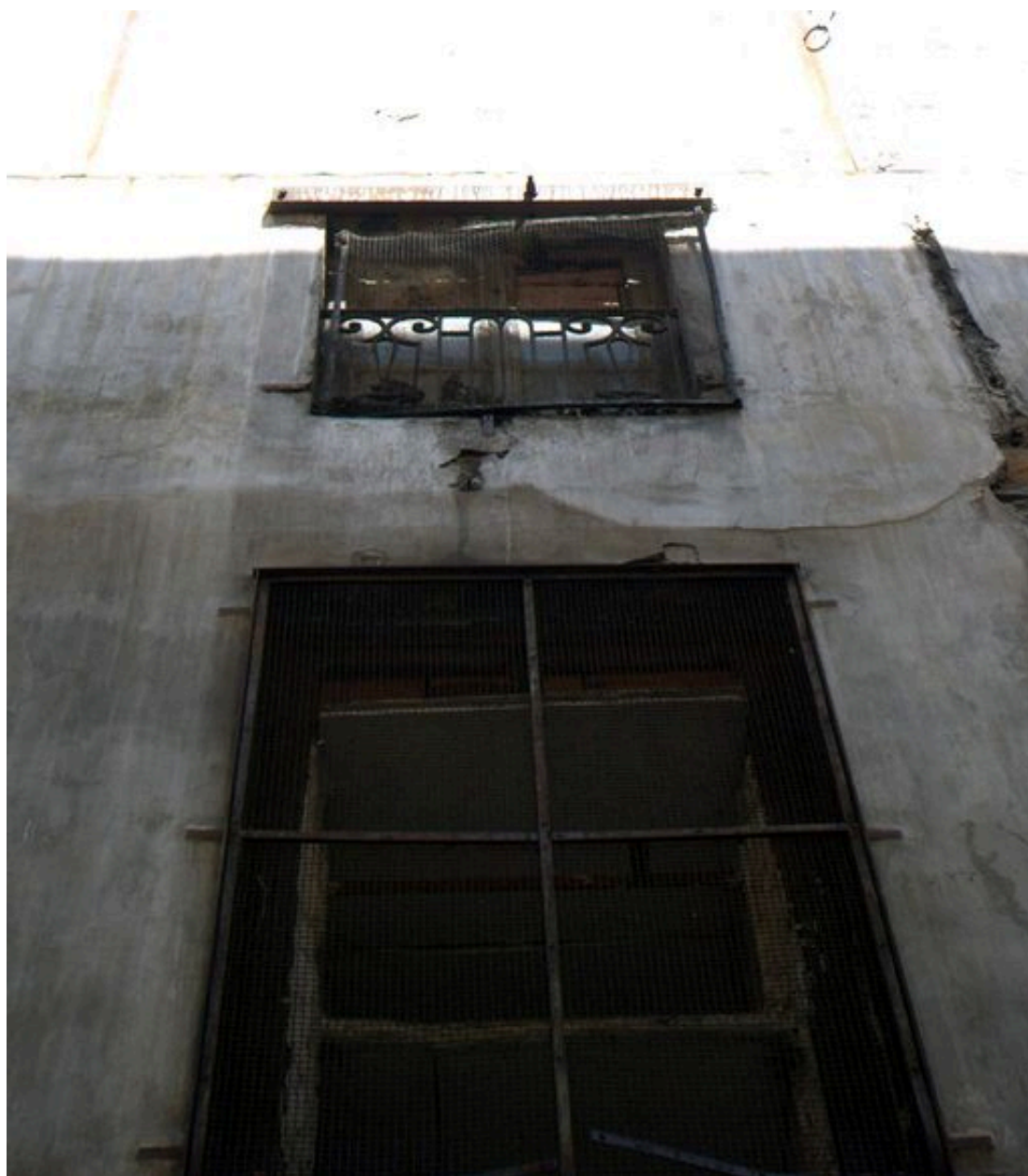
Détail d'un garde-corps
