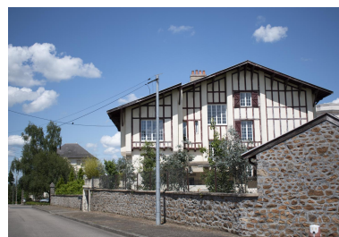
Elévation postérieure de la Villa du Docteur Macé de Lépinay, depuis la rue Alphonse Daudet Phot. Isabelle Brown IVR84_20250300617NUCA
