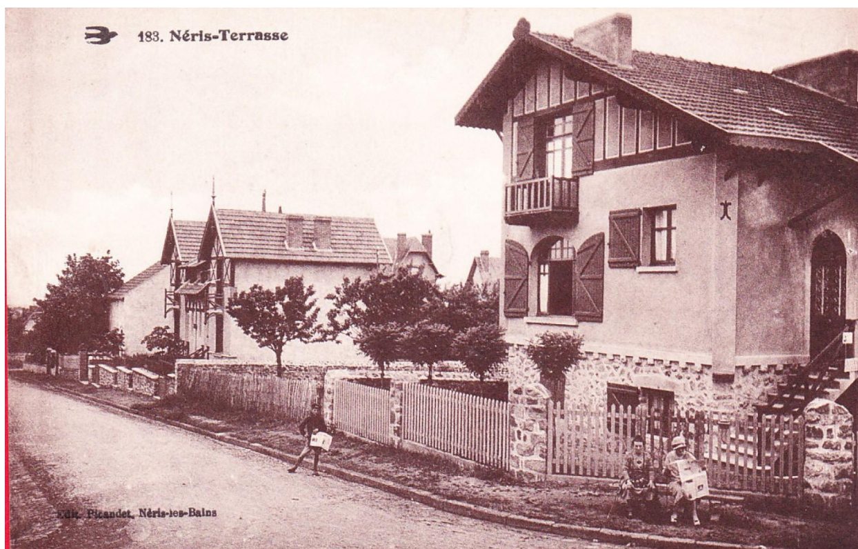
Façade de la maison du 12 rue Massenet et des villa jumelles de la rue des Kars, vers 1930
