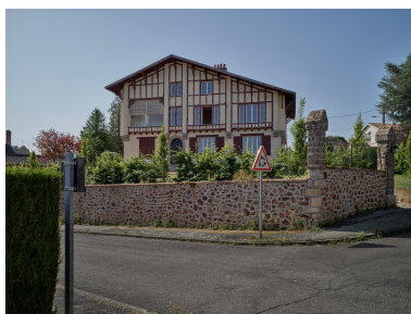
Vue depuis la place Saint-Georges Phot. Christian Parisey IVR84_20250300417NUC4A
