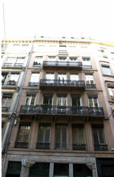
Façade sur rue, vue générale par-dessous Phot. Bernard Ducouret IVR82_20046900406NUCA
