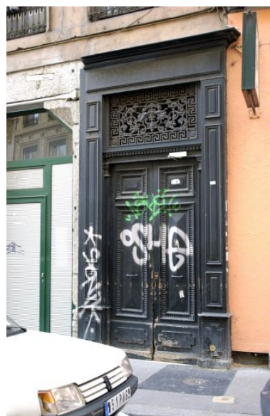
Façade sur rue, détail de la porte de l'allée conduisant à la cour commune Phot. Bernard Ducouret IVR82_20046900407NUCA
