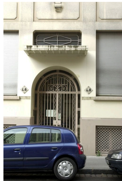
Détail de la porte principale Phot. David Chevallier
