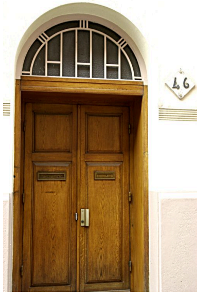
Détail de la porte secondaire Phot. David Chevallier IVR82_20046902084NUCA
