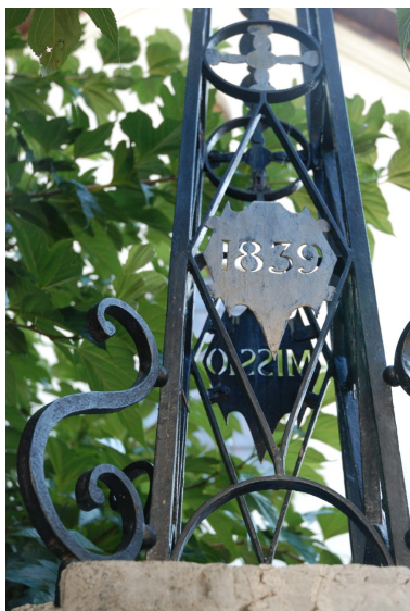
Détail de la date. Phot. Caroline Guibaud IVR84_20247301492NUCA
