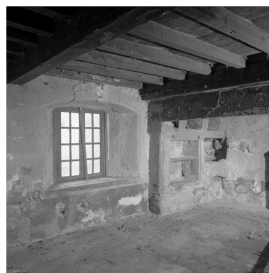
Logis, angle gauche de la cheminée : avec placard mural et vasque en terre cuite. Phot. Jean-Marie Refflé IVR82_20024200985X
