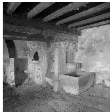
Logis, détail de l'angle droit de la cheminée avec four à pain, vasque en pierre et moulin à huile.. Phot. Jean-Marie Refflé IVR82_20024200982X
