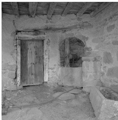
Partie annexe de la ferme. Détail de l'entrée avec son puits. Phot. Jean-Marie Refflé IVR82_20024202397X
