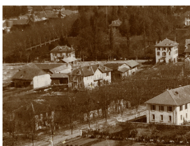
Vue aérienne de la villa au centre, vers 1885 Repro. François Fouger IVR82_20127300975NUCB
