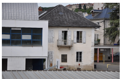
Élévation latérale Phot. François Fouger IVR82_20127301098NUCA
