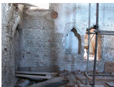
Détail de l'angle sud-est intérieur de la chapelle. Phot. Thierry Monnet IVR82_20134203311NUCA
