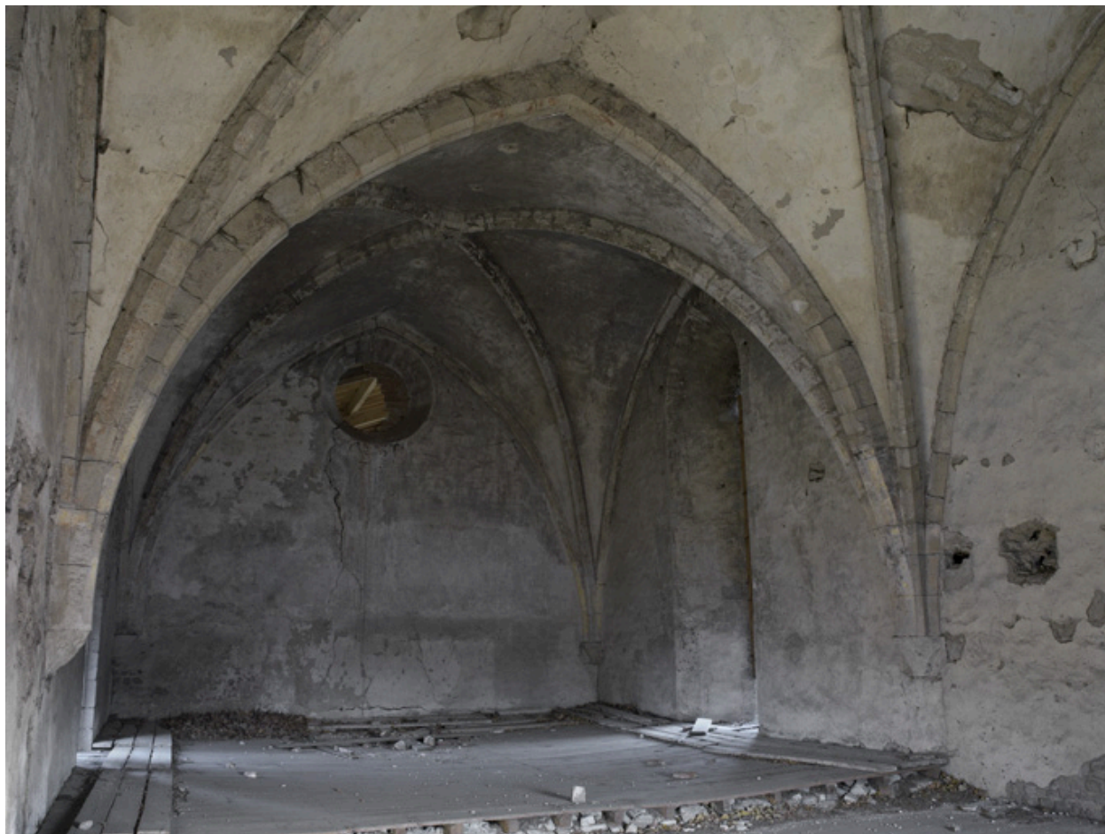
Vue d'ensemble des voûtes de la chapelle en direction du chœur (à l'est).
