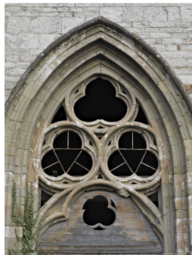
Détail de la partie haute du portail de la chapelle. Phot. Eric Dessert IVR82_20084200134NUCA
