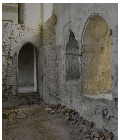
Détail de l'angle sud- est de la chapelle. Phot. Eric Dessert IVR82_20084200121NUCA
