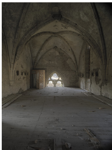
Vue d'ensemble des voûtes de la chapelle en direction de l'ouest. Phot. Eric Dessert IVR82_20084200149NUCA
