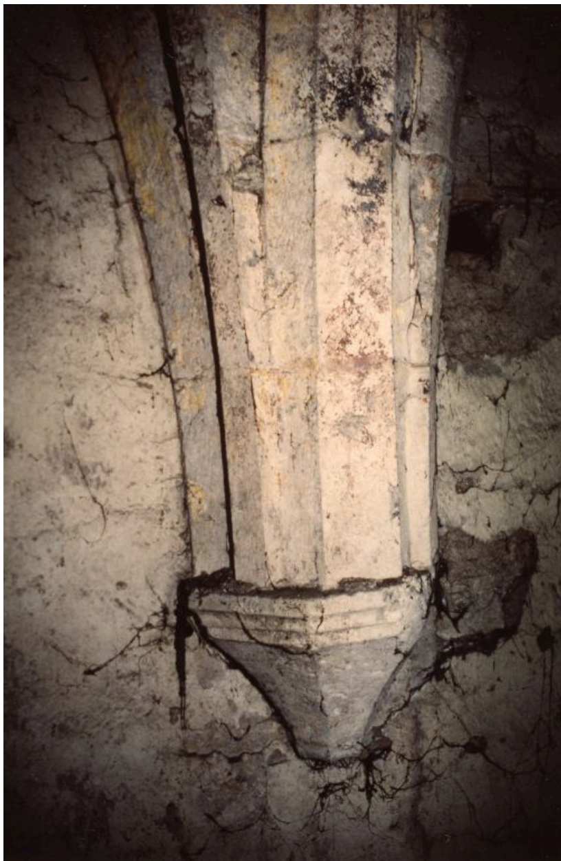
Détail d'un culot sur lequel reposent les ogives et arcs doubleaux.
