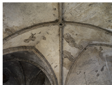
Détail des voûtes de la chapelle, première travée. Phot. Eric Dessert IVR82_20084200132NUCA
