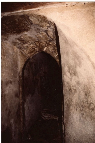
Porte dans le mur est, côté extérieur à la chapelle.
