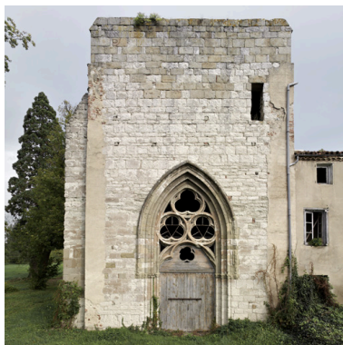
Elévation de la façade ouest de la chapelle. Phot. Eric Dessert IVR82_20074200907NUCA
