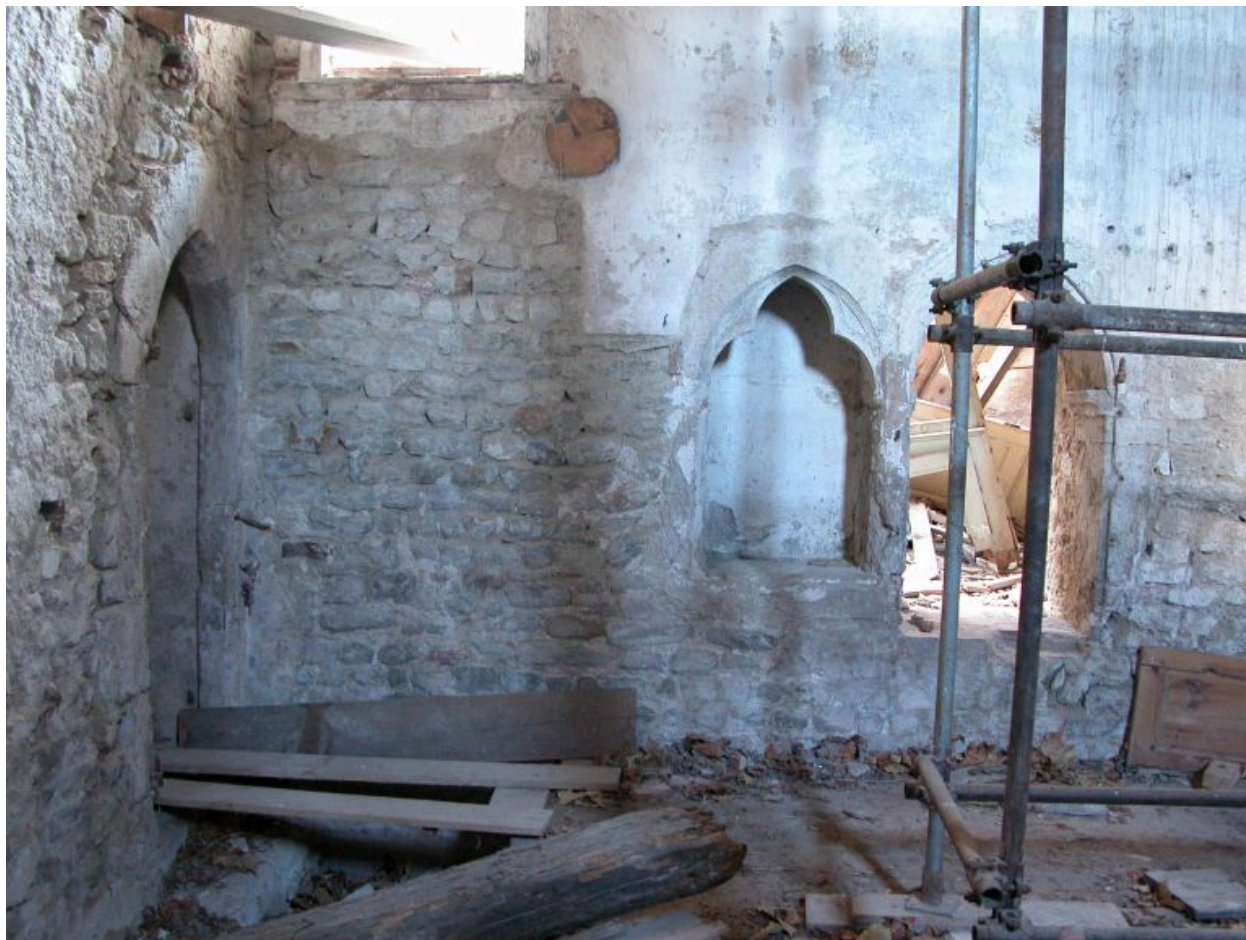
Détail de l'angle sud-est intérieur de la chapelle.
