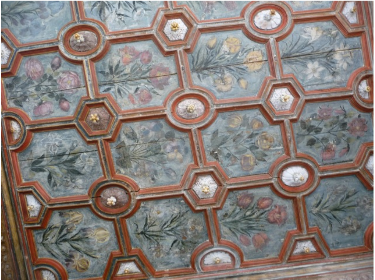
Nettoyage du plafond à caissons
