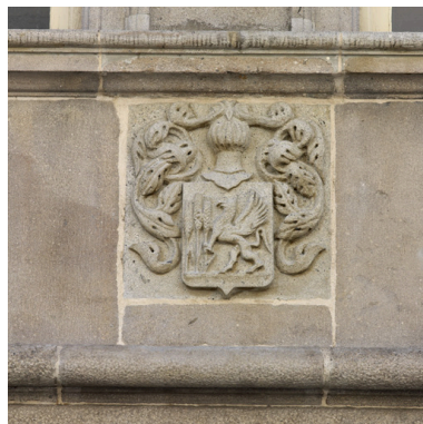
Détail, bandeau du 1er étage : armoiries restaurées de la famille Henrys. Phot. Eric Dessert
