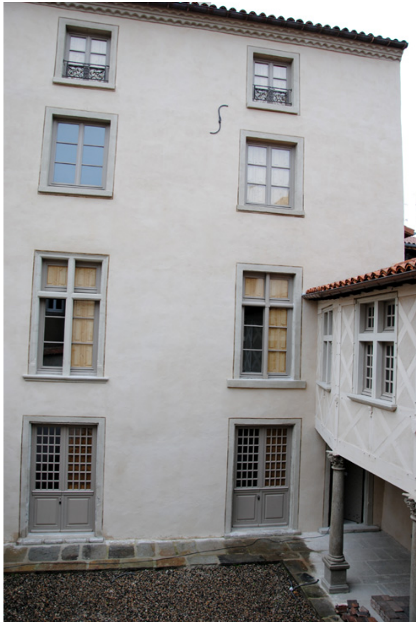
Vue générale de l'élévation sur cour après restauration, 2010.
