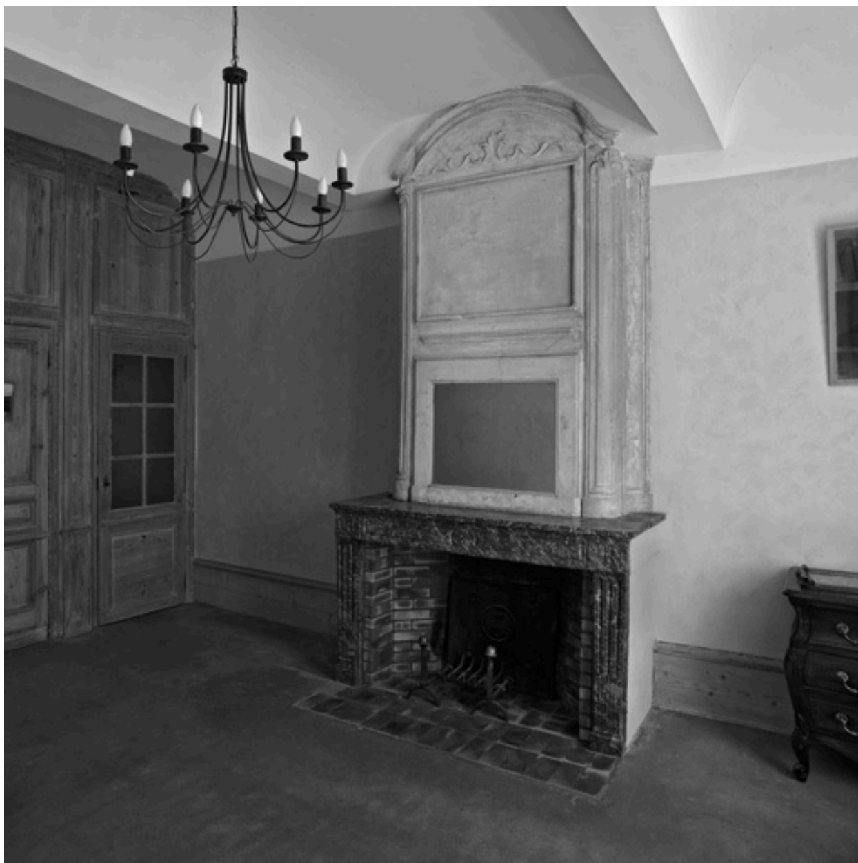
Cheminée de l'étage : hotte 18e siècle, manteau et piédroits 19e siècle (corps B).
