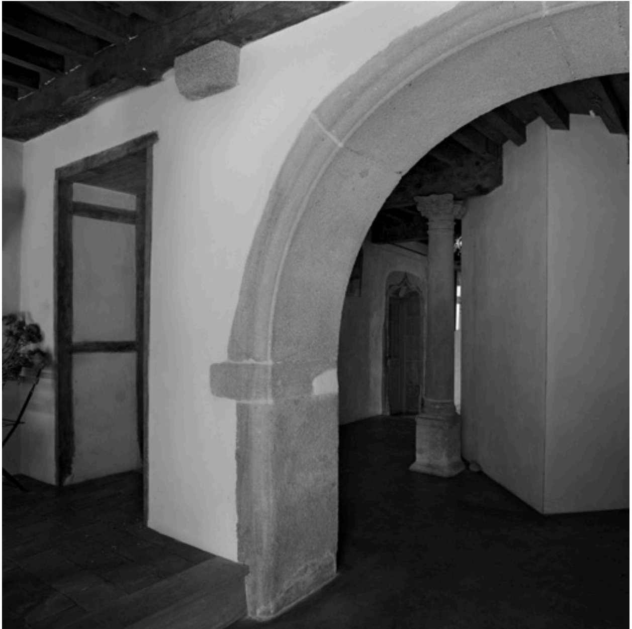
Vestiges architecturaux installés dans le palier du rez-de-chaussée (corps B).
