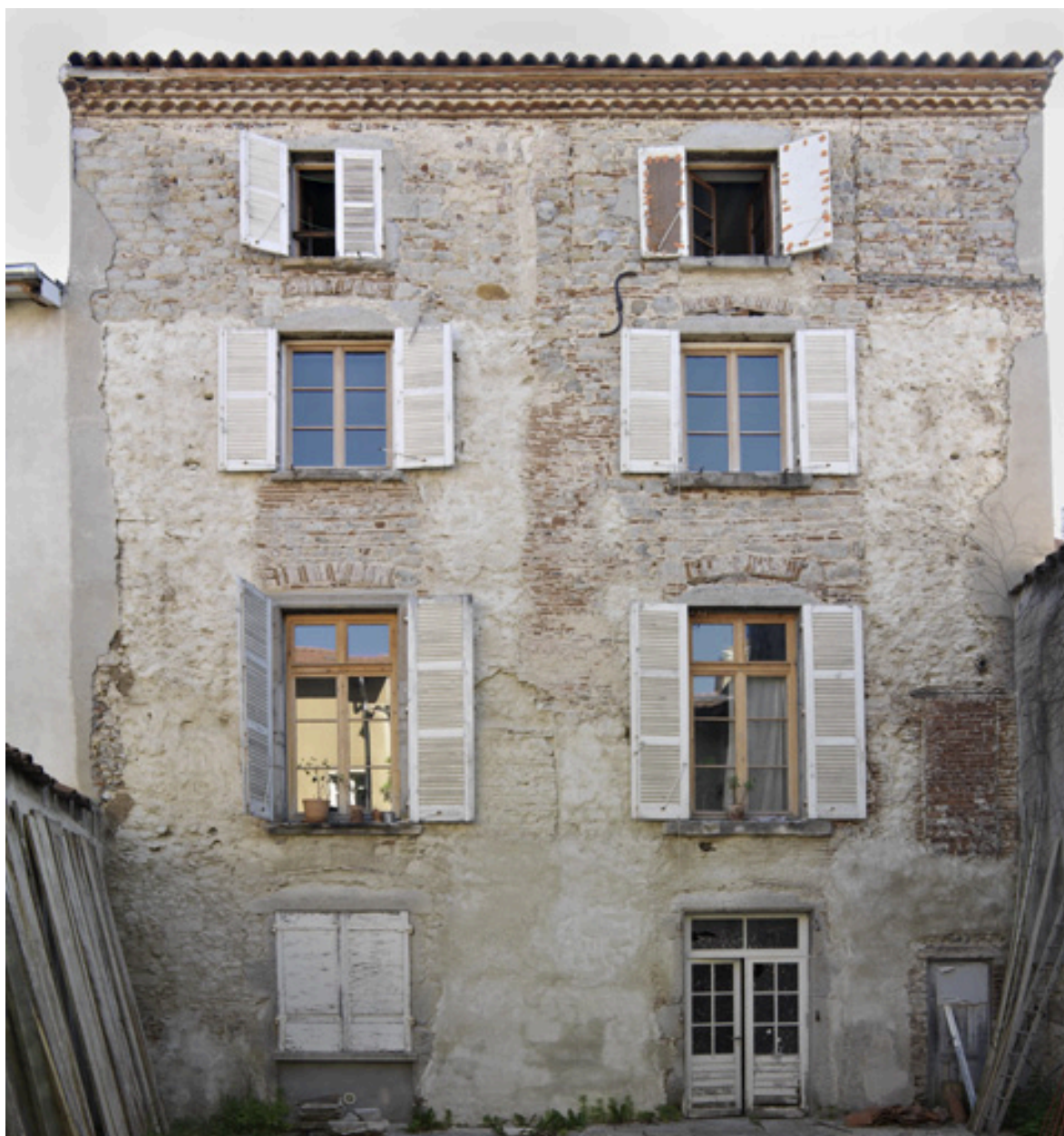
Vue générale de l'élévation sur cour avant restauration (corps A).
