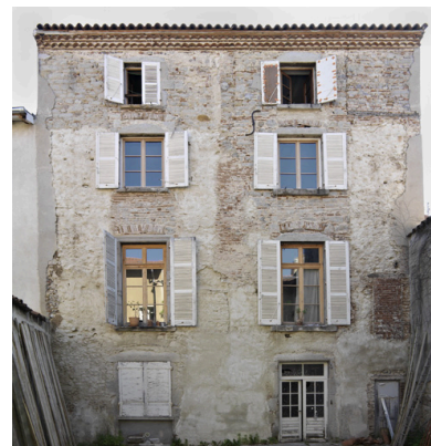
Vue générale de l'élévation sur cour avant restauration (corps A). Phot. Eric Dessert IVR82_20064200669NUCA
