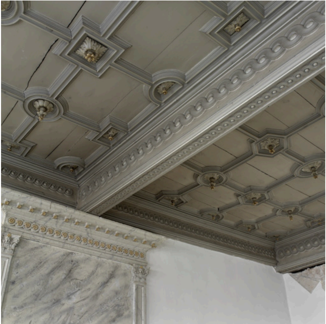
Vue partielle du plafond à caissons avant restauration.
