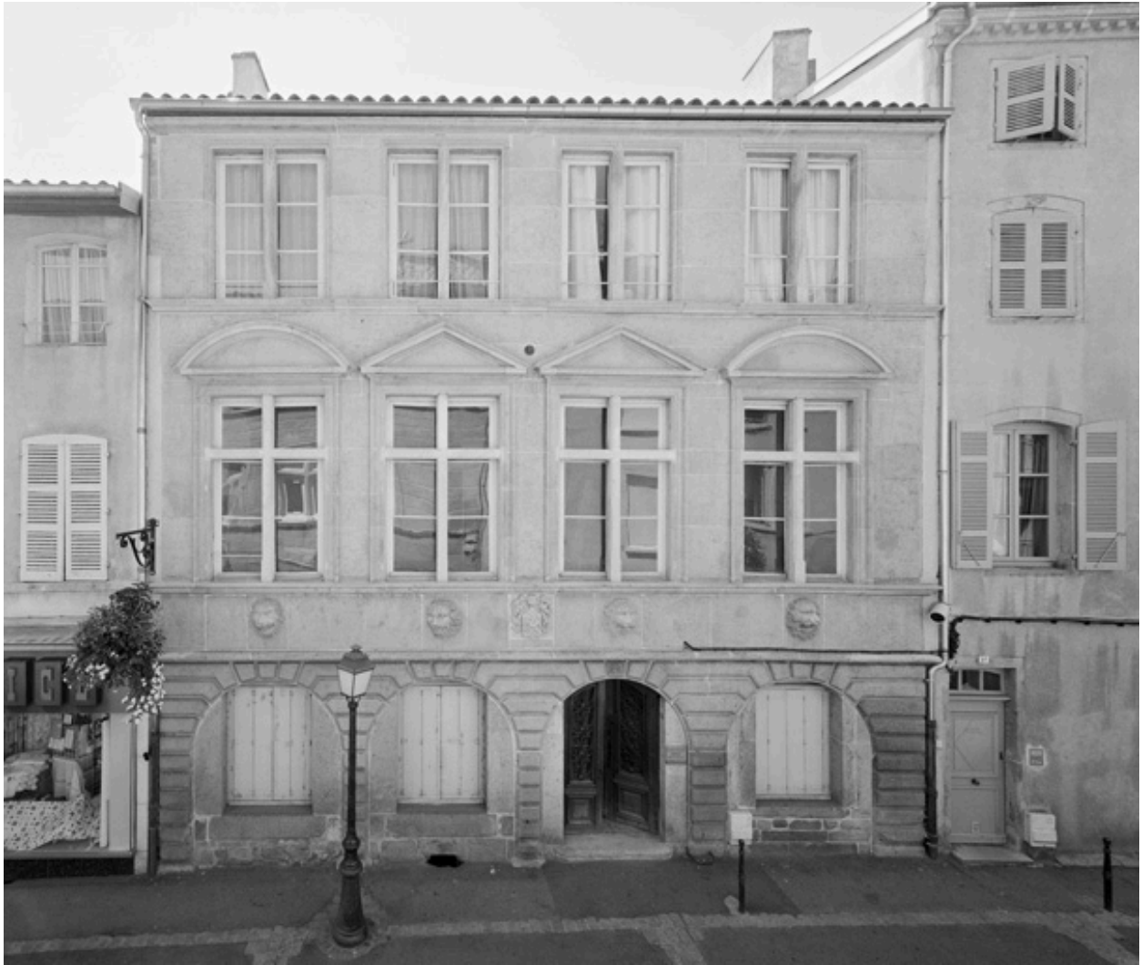
Vue générale (corps A).
