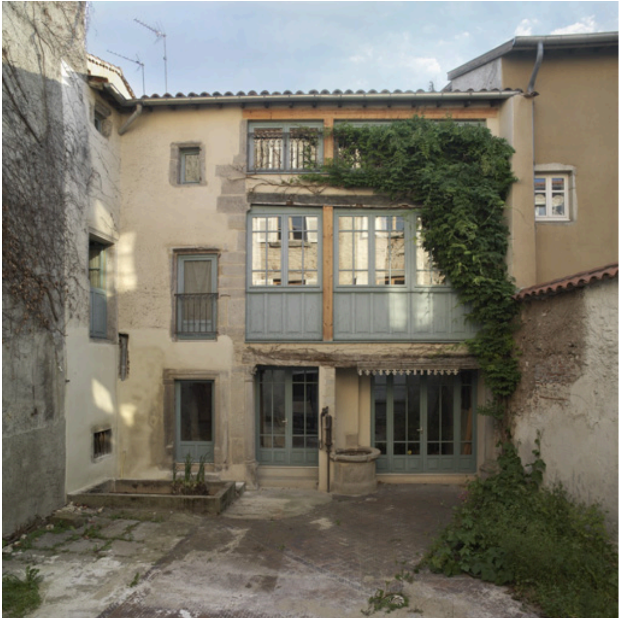
Vue générale de l'élévation sur cour avant restauration (corps B).
