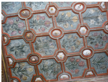
Nettoyage du plafond à caissons Phot. Josiane Boulon IVR82_20124202718NUCA
