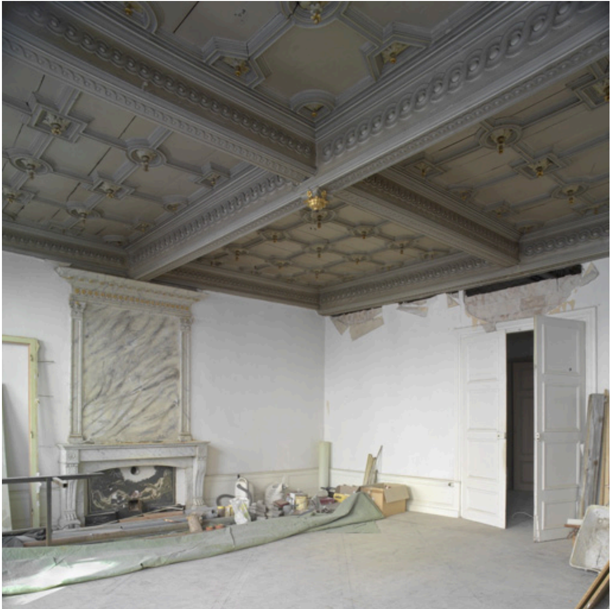
Vue partielle du salon, 1er étage (corps A).
