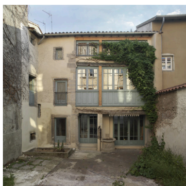
Vue générale de l'élévation sur cour avant restauration (corps B). Phot. Eric Dessert IVR82_20064200662NUCA
