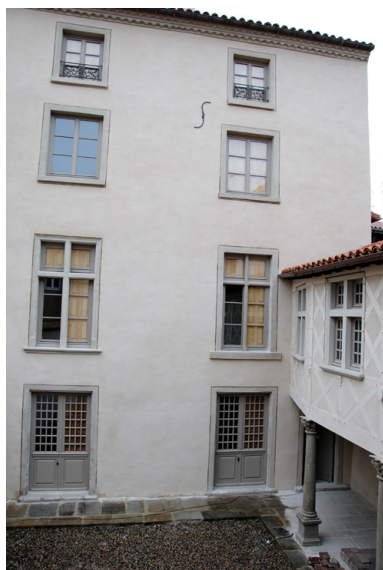
Vue générale de l'élévation sur cour après restauration, 2010. Phot. Josiane Boulon IVR82_20124202717NUCA
