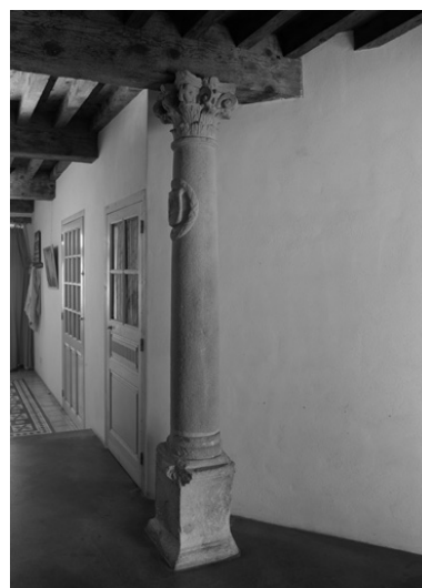
Colonne soutenant l'ancienne galerie sur cour, déposée à la fin du 19e siècle ou au début du 20e siècle (corps B). Phot. Eric Dessert IVR82_20064200680NUC
