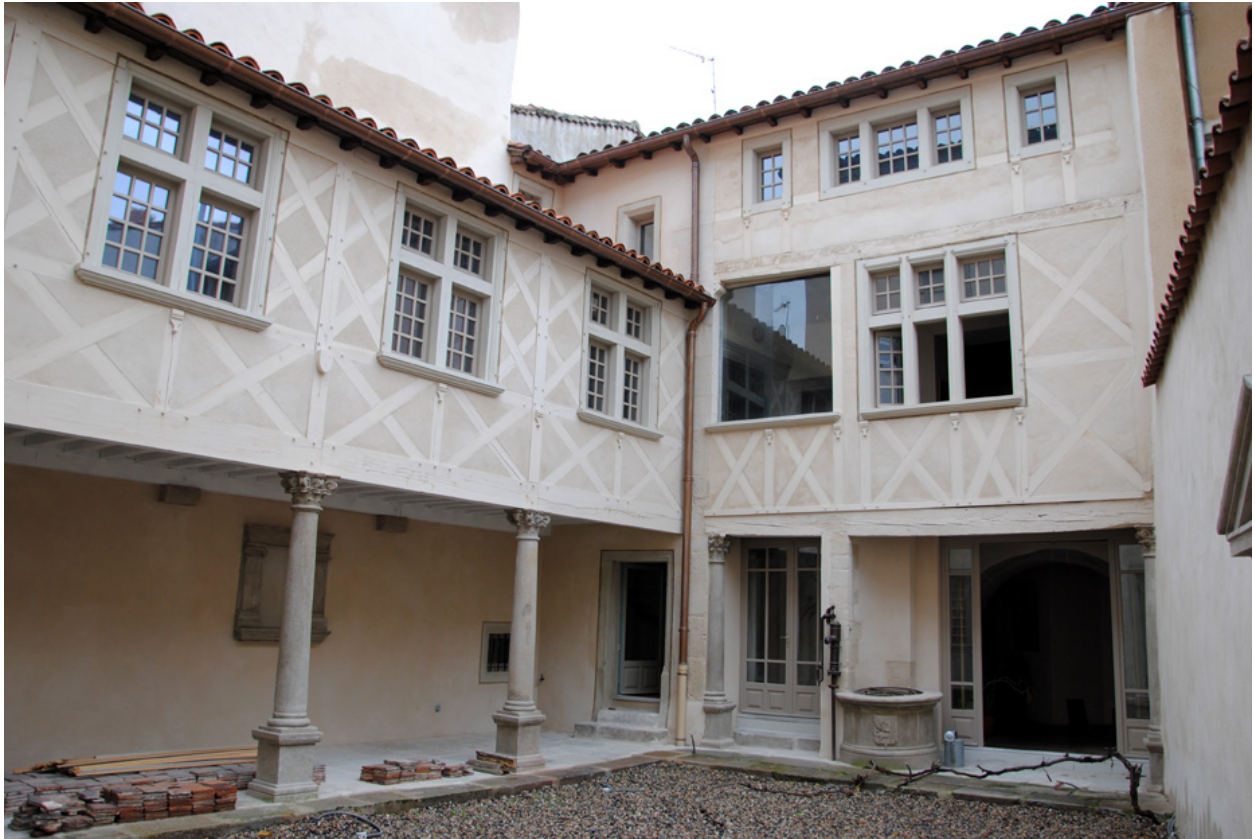
Restauration de l'élévation sur cour et restitution de la galerie, 2010 (corps B).
