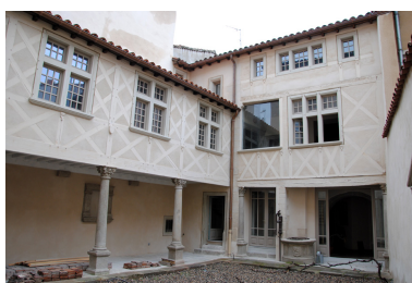
Restauration de l'élévation sur cour et restitution de la galerie, 2010 (corps B). Phot. Josiane Boulon IVR82_20124202716NUCA
