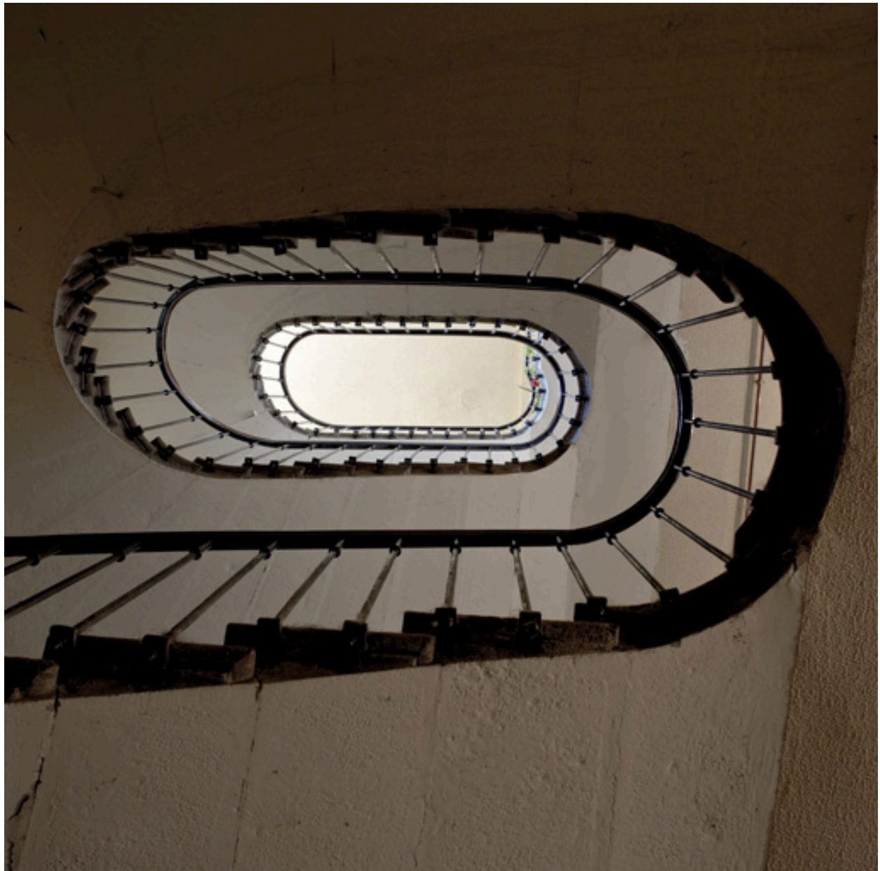
Escalier tournant à retours avec jour, suspendu, vu du bas vers le haut, 19e siècle (corps A).
