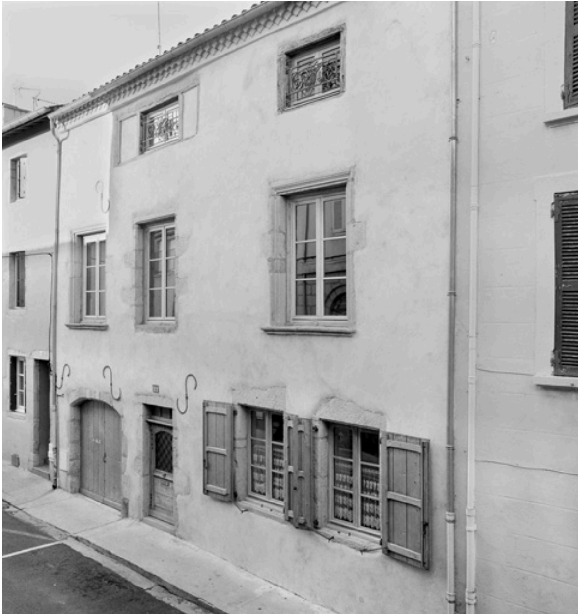
Vue générale depuis la rue Legouvé (anciennement rue Neuve, corps B).
