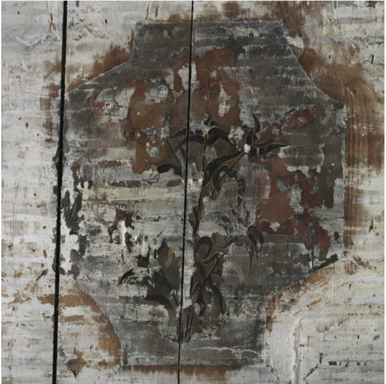
Sondage du décor peint dans les caissons.
