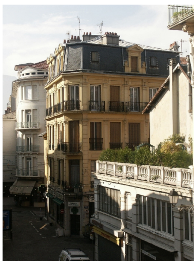
Vue de la terrasse
