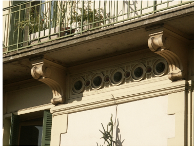
Détail du décor de cabochons de la façade Phot. François Fouger IVR82_20047300097NUCA
