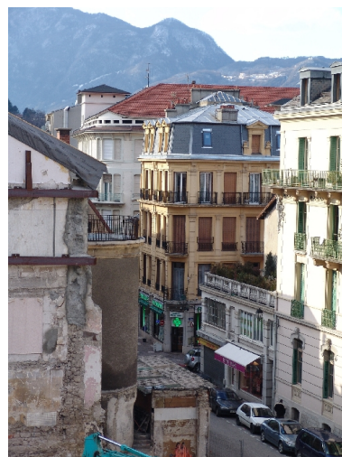
Partie occidentale de la façade Phot. François Fouger IVR82_20057300770NUCA
