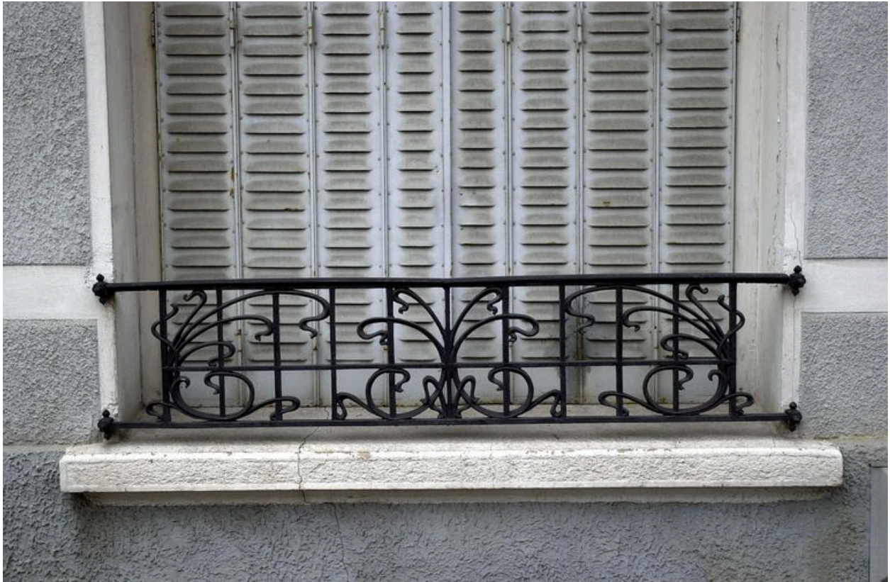
Façade sur rue, détail de la grille d'appui d'une fenêtre du rez-de-chaussée
