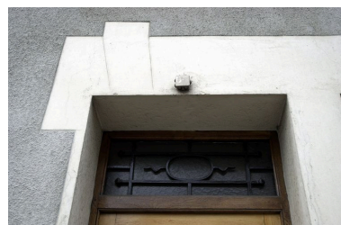
Porte, détail de la grille d'imposte Phot. Véronique Belle IVR82_20036902127NUCA
