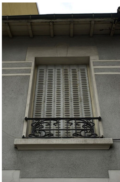
Façade sur rue, détail d'une fenêtre du premier étage Phot. Véronique Belle IVR82_20036902125NUCA
