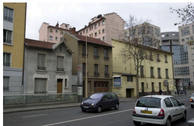
Vue générale de la maison parmi les autres constructions à détruire. Phot. Véronique Belle IVR82_20036902122NUCA
