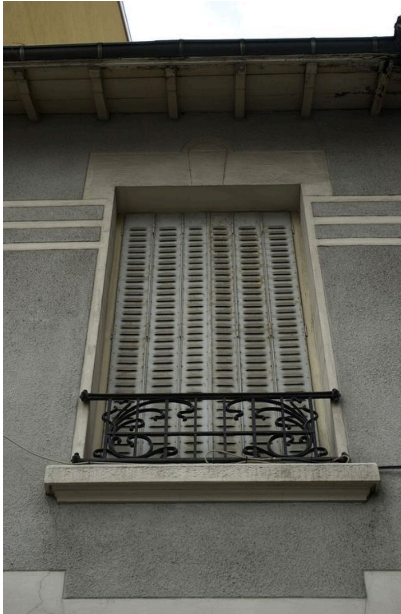
Façade sur rue, détail d'une fenêtre du premier étage
