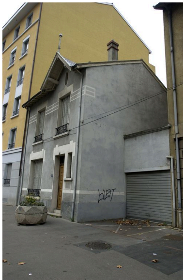
Vue générale de la maison et de son garage. Phot. Véronique Belle IVR82_20036902123NUCA
