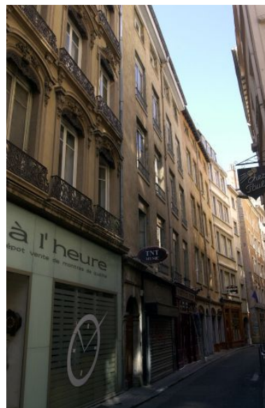
Façade sur rue, vue générale prise sur la gauche Phot. Bernard Ducouret IVR82_20036901221NUCA
