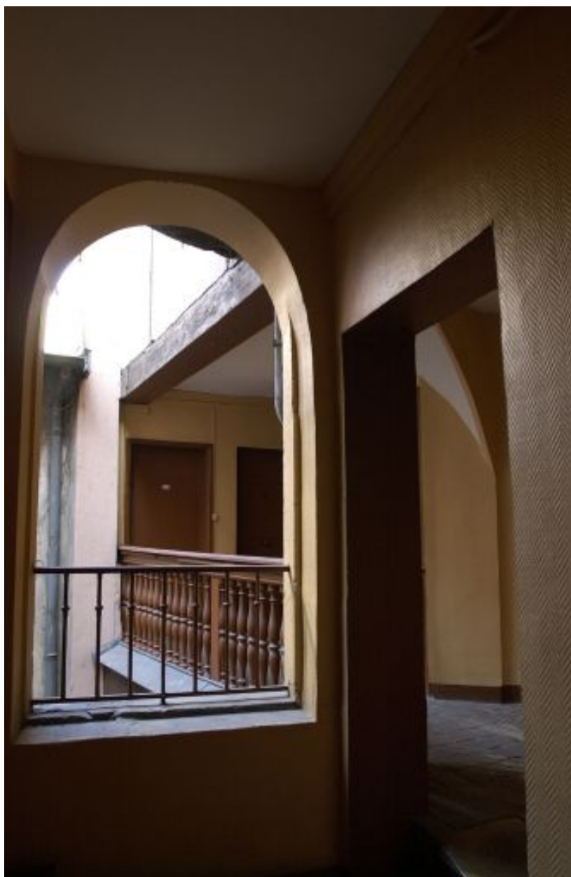
Revers du 1er corps de bâtiment, coursière du dernière étage vu depuis l'escalier
