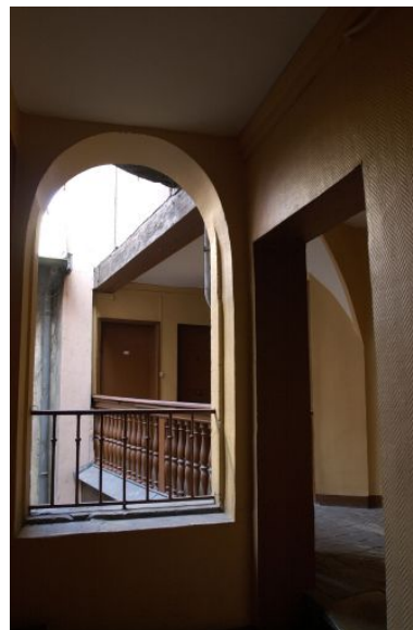
Revers du 1er corps de bâtiment, coursière du dernière étage vu depuis l'escalier Phot. Bernard Ducouret IVR82_20036901222NUCA
