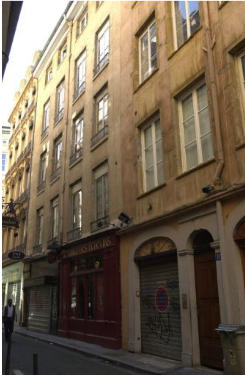
Façade sur rue, vue générale prise sur la droite
