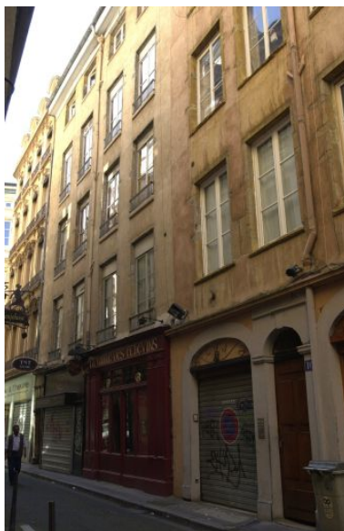
Façade sur rue, vue générale prise sur la droite Phot. Maryannick Chalabi IVR82_20036901060NUCA
