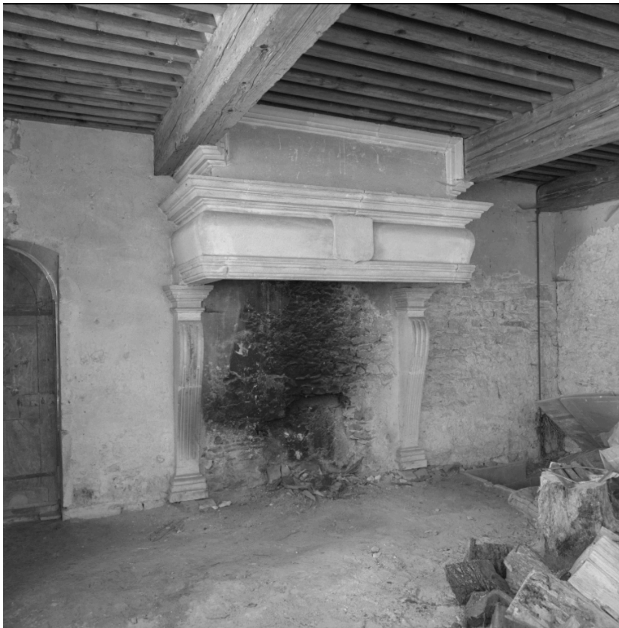
Aile gauche, cheminée du rez-de-chaussée.
