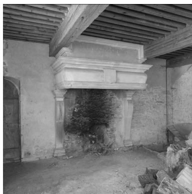
Aile gauche, cheminée du rez-de-chaussée.
