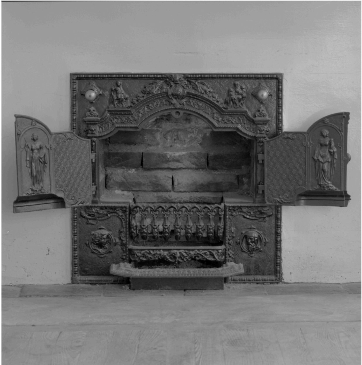
Détail de la cheminée de la chambre n°1 au rez-de-chaussée : foyer en fonte (ouvert).
