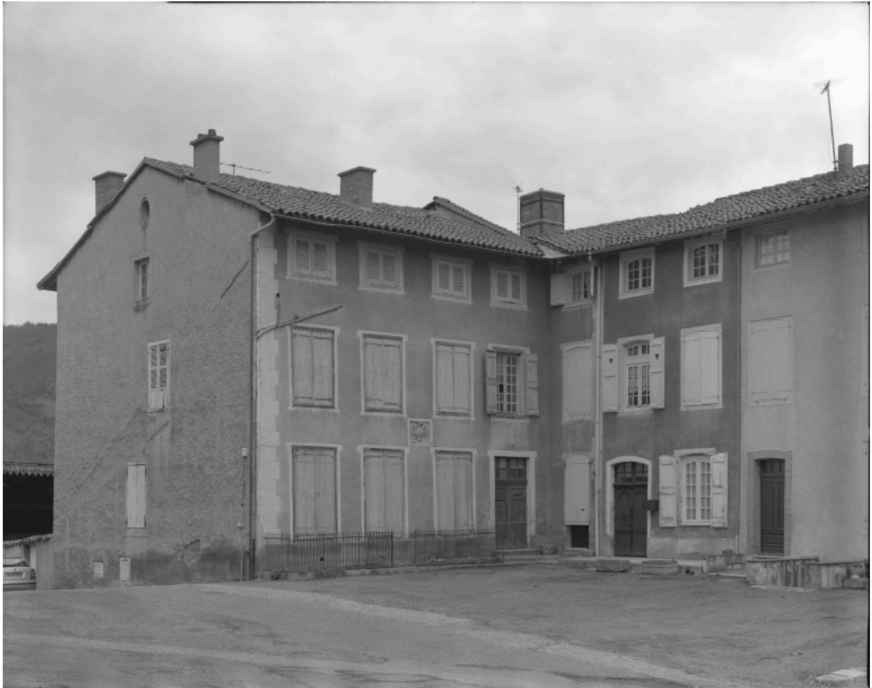
Vue d'ensemble de l'élévation donnant sur la place du chapitre.
