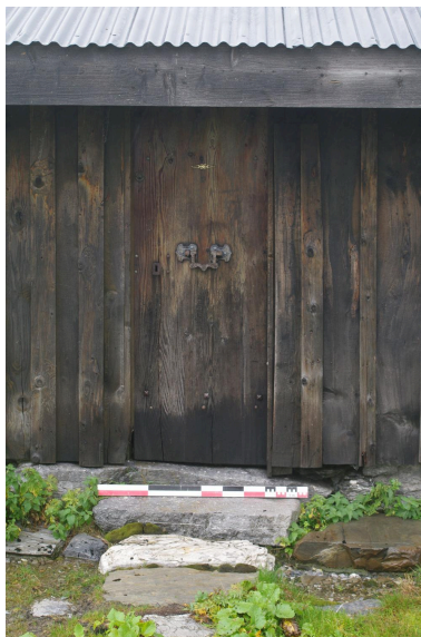
Détail de la porte d'entrée donnant sur la façade antérieure Phot. Jocelyn Laidebeur IVR84_20227402444NUCA
