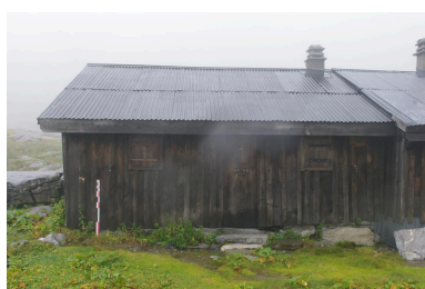
Vue de la façade antérieure est Phot. Jocelyn Laidebeur
