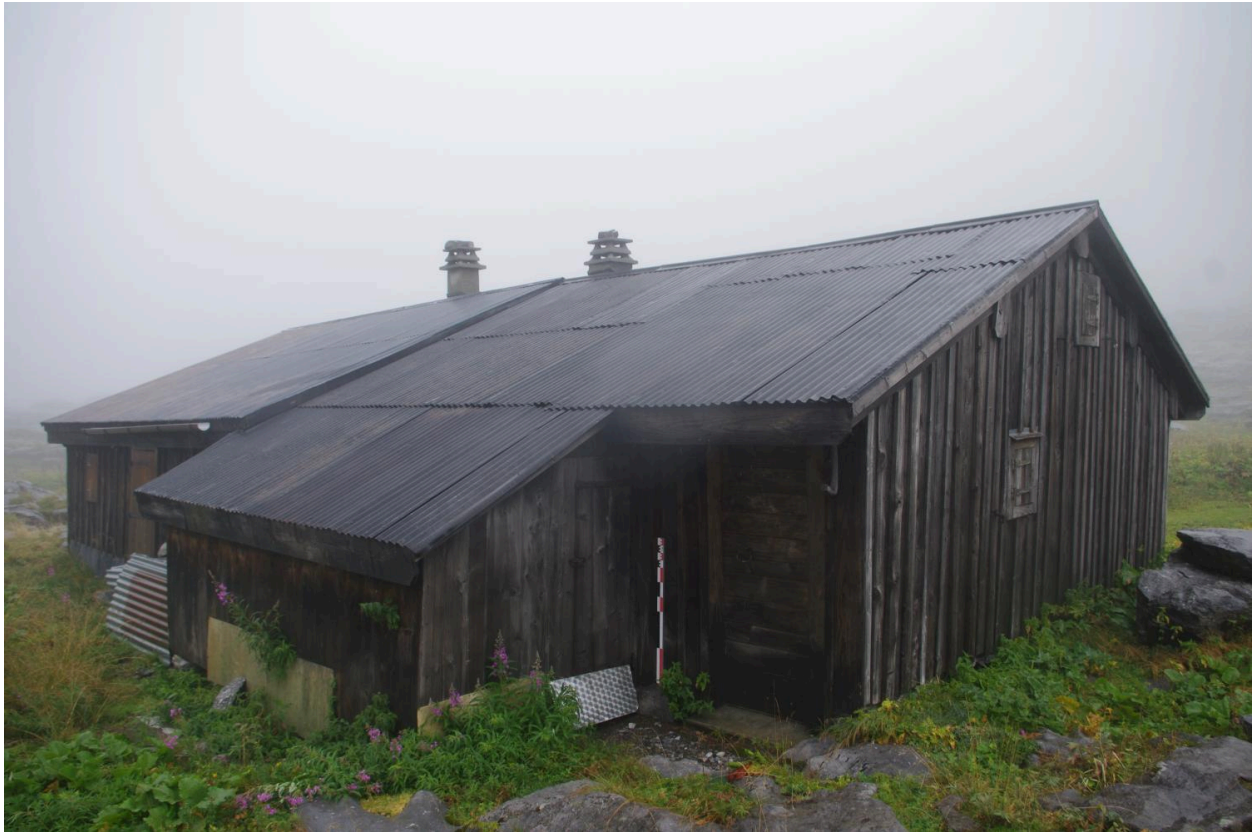
Vue de l'élévation sud-ouest
