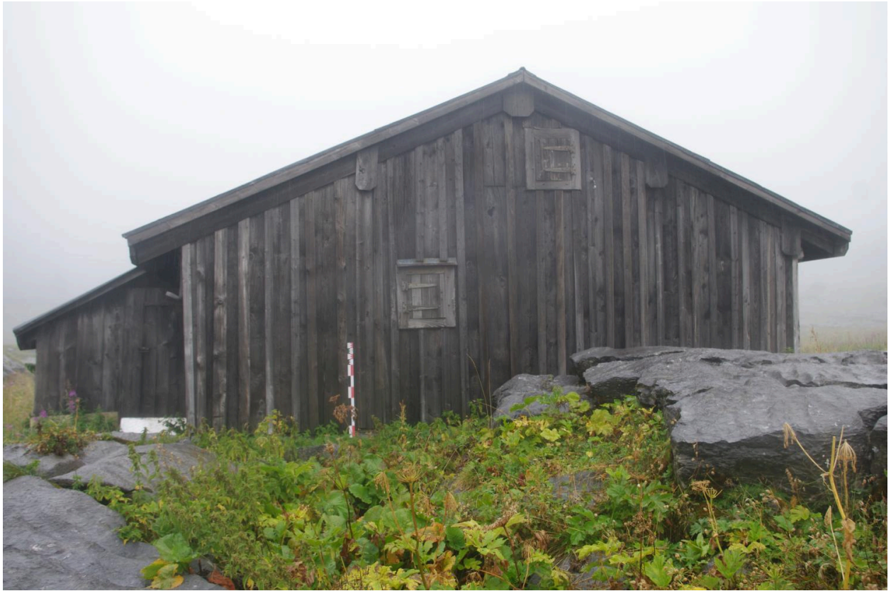
Vue du mur pignon sud
