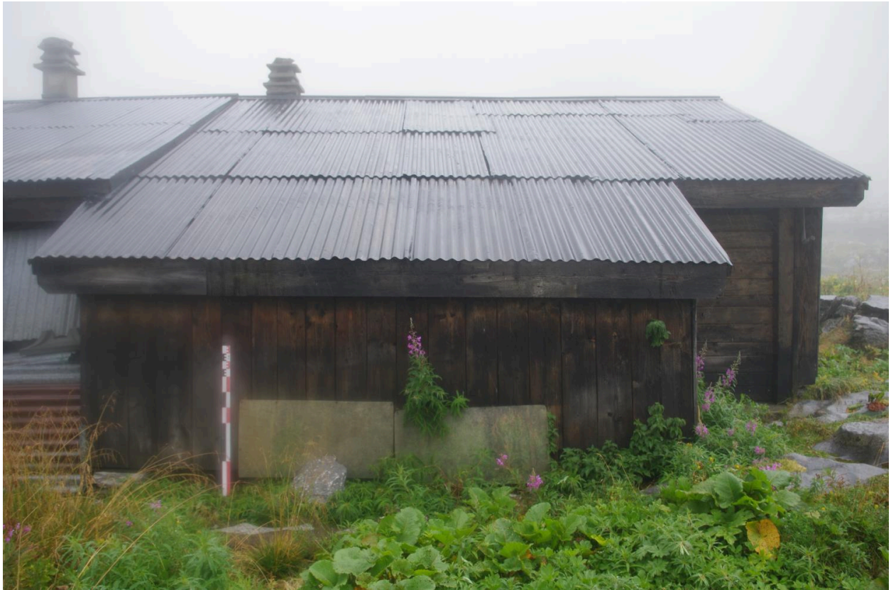
Vue de la façade postérieure ouest
