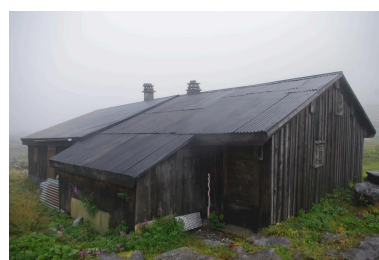
Vue de l'élévation sud-ouest Phot. Jocelyn Laidebeur
