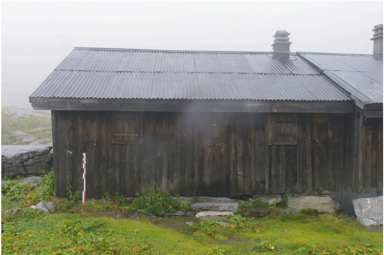
Vue de la façade antérieure est
