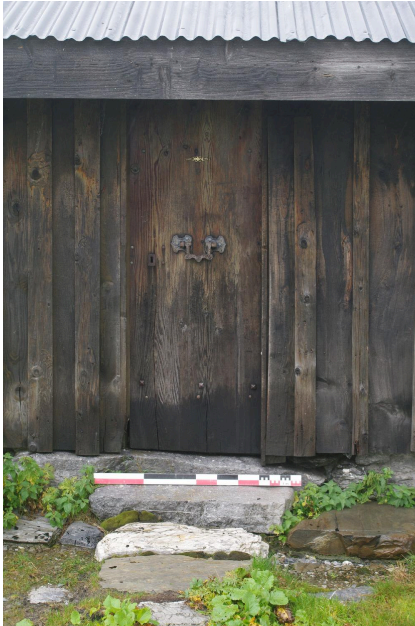
Détail de la porte d'entrée donnant sur la façade antérieure
