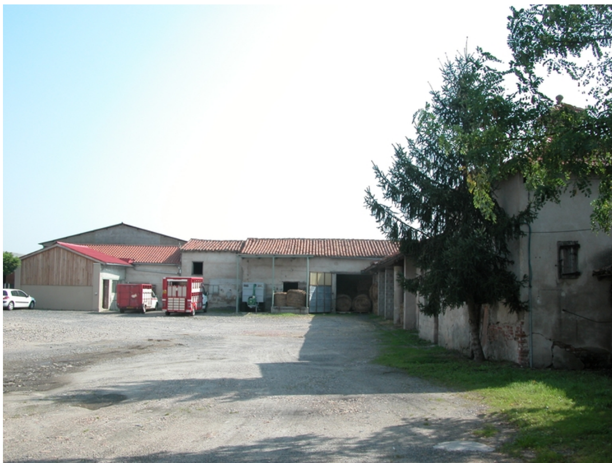
Vue d'ensemble de la cour, depuis l'ouest.
