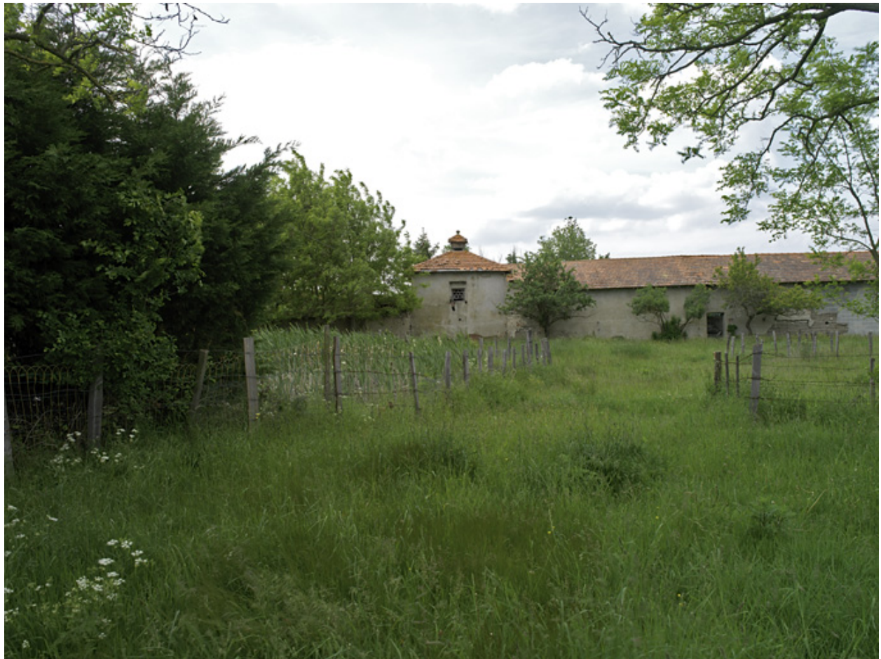
Vue générale depuis le sud.
