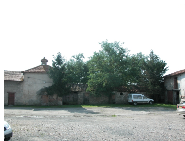
Vue d'ensemble de l'angle sud- ouest de la cour, depuis l'est. Phot. Caroline Guibaud IVR82_20134204693NUCA
