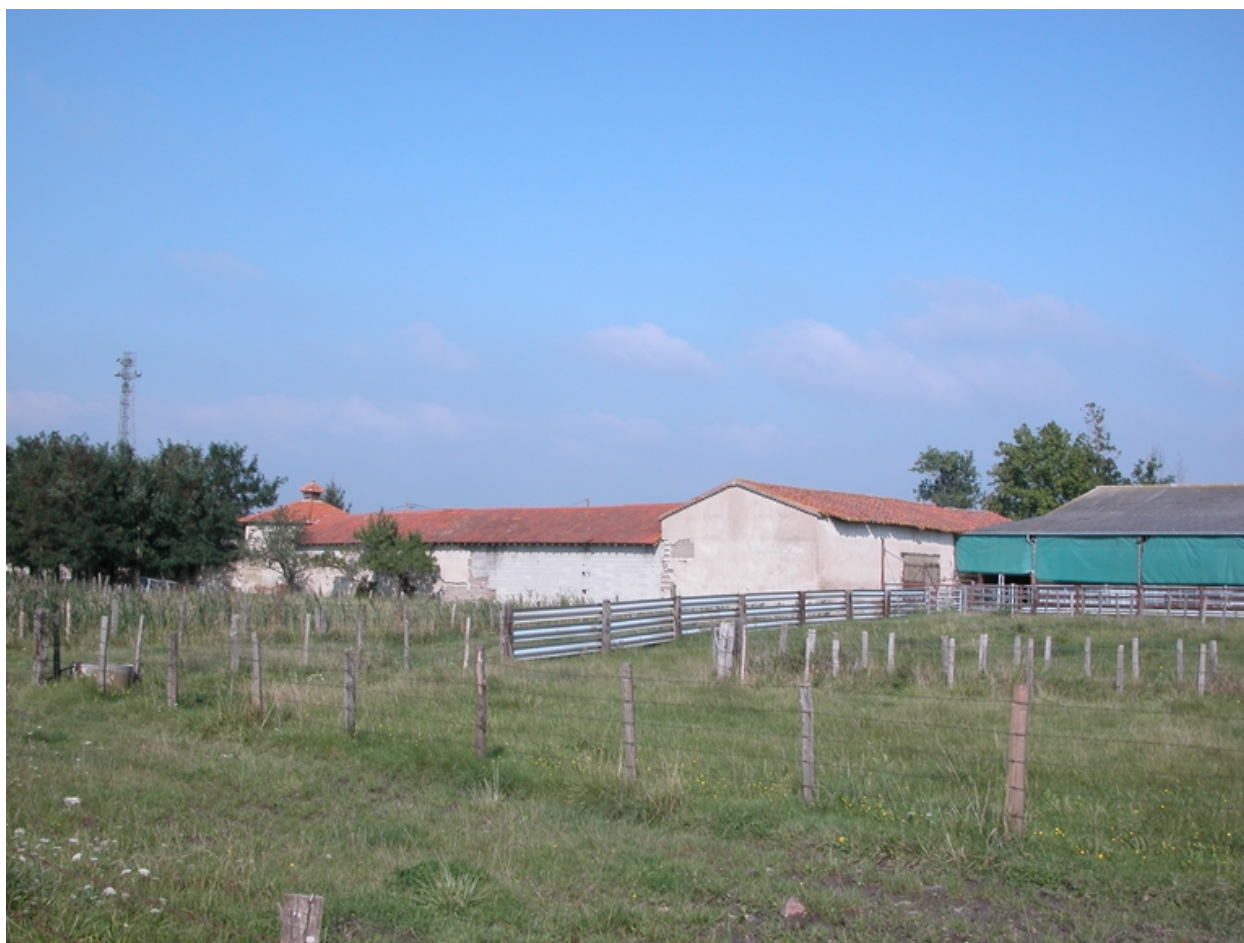
Vue générale depuis le sud.
