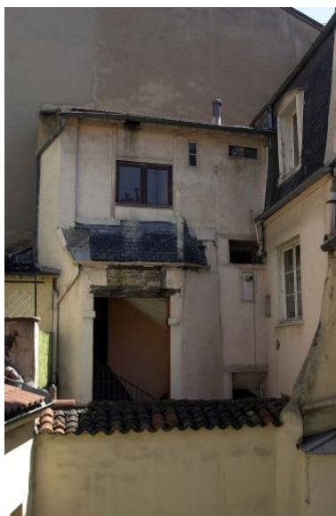
Escalier, partie supérieure de l'élévation Phot. Bernard Ducouret IVR82_20036901276NUCA
