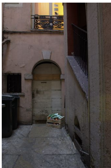
Cour, rez-de-chaussée du corps du fond Phot. Bernard Ducouret IVR82_20056900412NUCA
