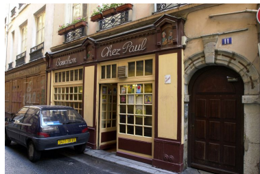
Façade sur rue, vue du rez-de-chaussée Phot. Bernard Ducouret IVR82_20036901269NUCA
