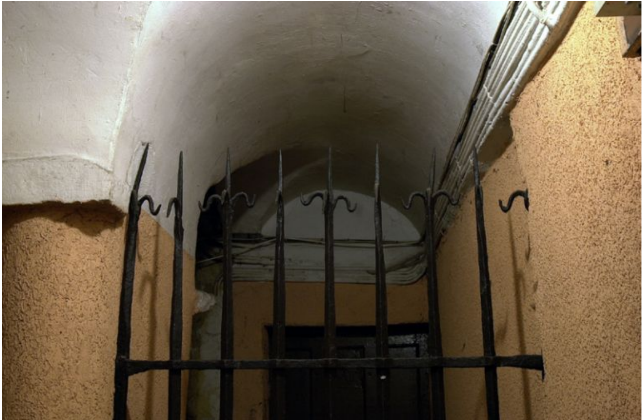
Grille fermant l'extrémité de l'allée, détail
