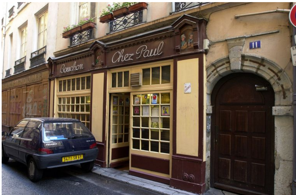
Façade sur rue, vue du rez-de-chaussée
