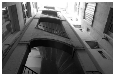
Cour, élévation de l'escalier Phot. Bernard Ducouret IVR82_20056900415NUC
