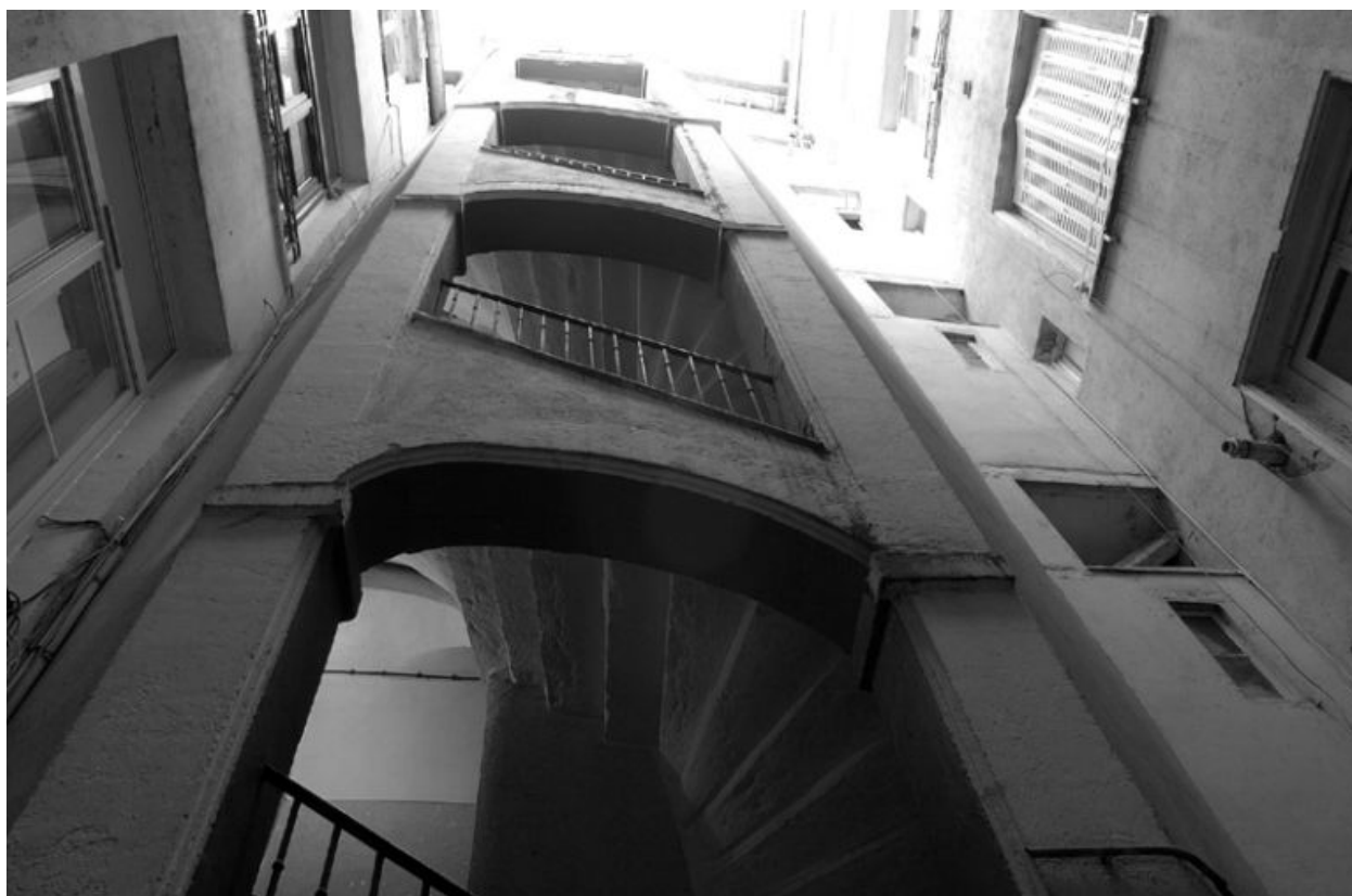
Cour, élévation de l'escalier
