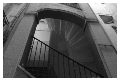
Cour, arcade ouvrant sur le rez- de-chaussée de l'escalier et le dessous des marches du 1er étage Phot. Bernard Ducouret IVR82_20056900414NUC
