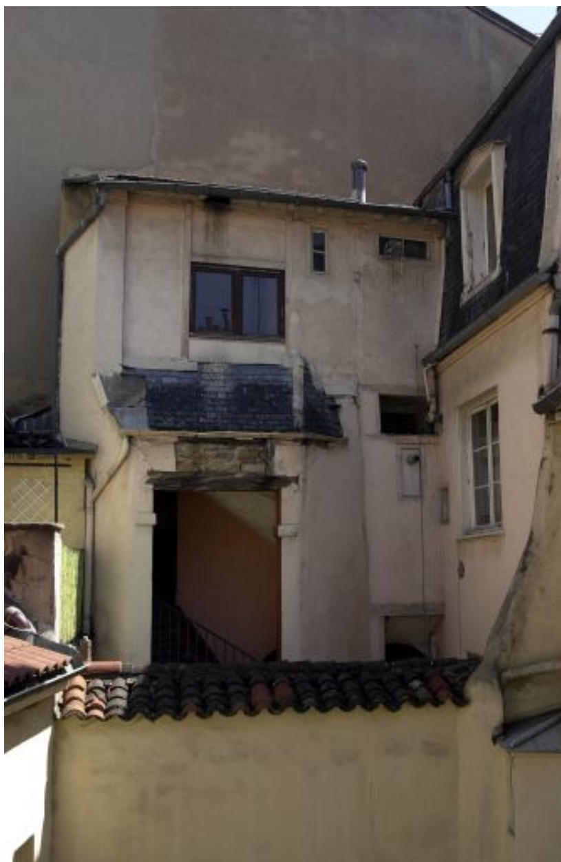
Escalier, partie supérieure de l'élévation
