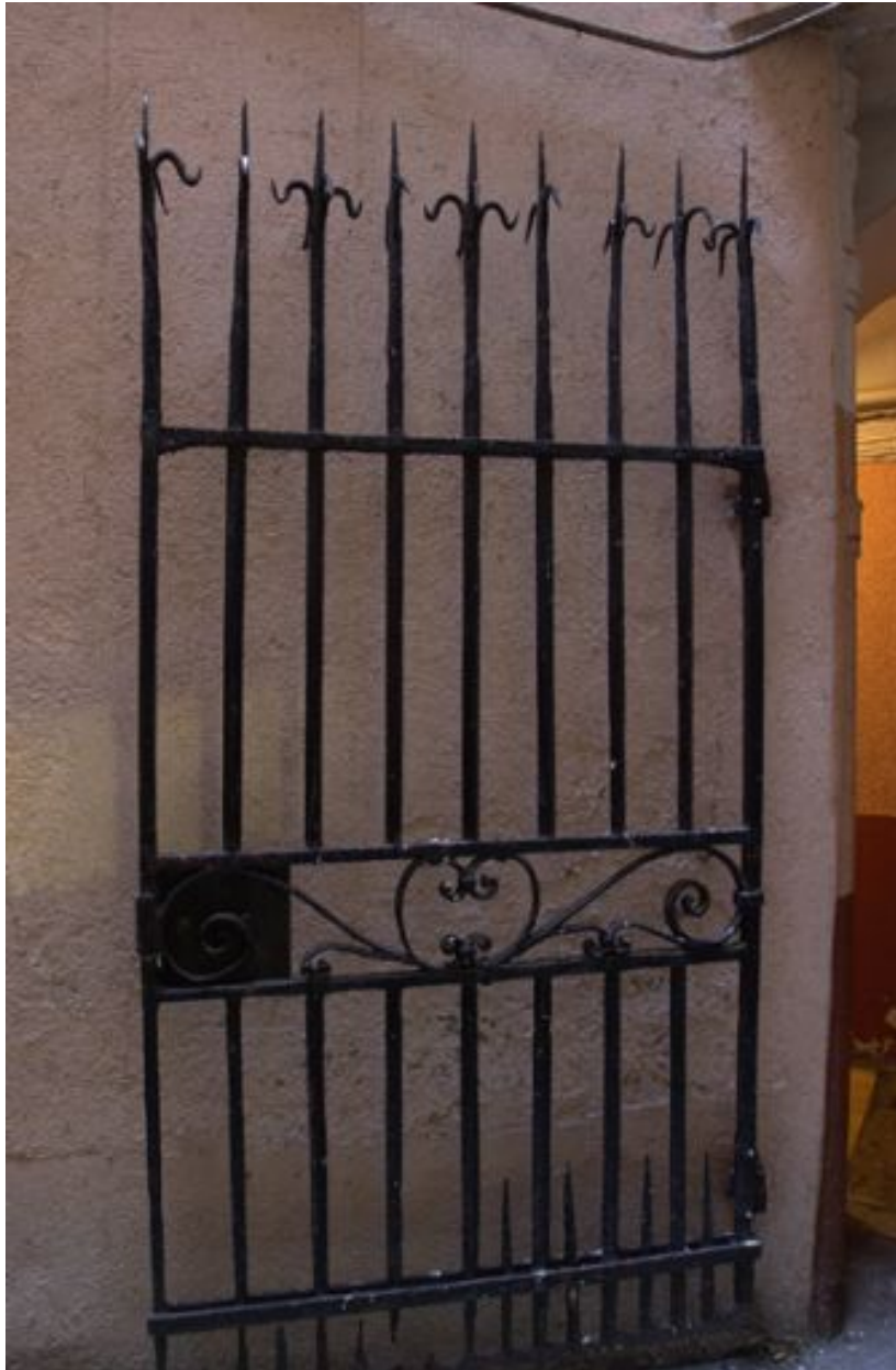
Cour, grille en fermant l'accès depuis l'escalier
