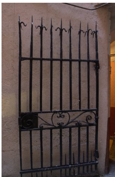
Cour, grille en fermetant l'accès depuis l'escalier Phot. Bernard Ducouret IVR82_20056900413NUCA
