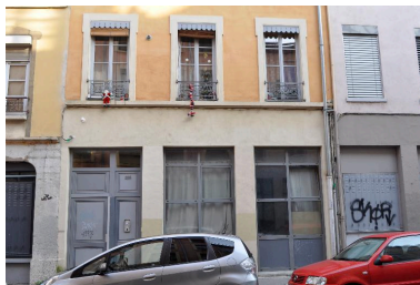
Rez-de-chaussée et premier étage Phot. Magali Delavenne IVR84_20166902247NUCA
