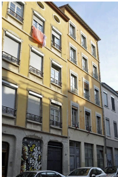
Vue d'ensemble depuis l'ouest Phot. Magali Delavenne IVR84_20166902246NUCA
