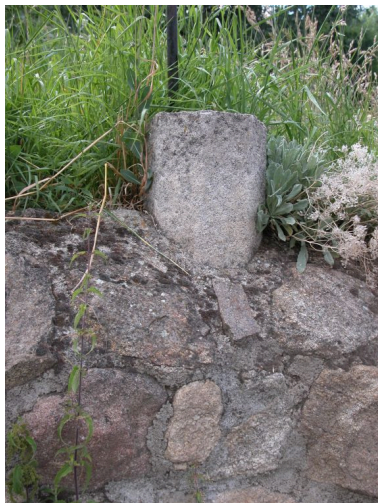
Vue de la base de la croix fichée dans un muret. Phot. Thierry Monnet IVR82_20124202925NUCA
