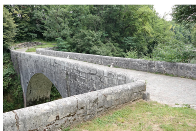
Pont Coppet, vue générale depuis la rive droite Phot. Pascale Renard IVR84_20207403151NUCA
