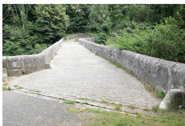
Pont Coppet, vue de la chaussée depuis la rive gauche
