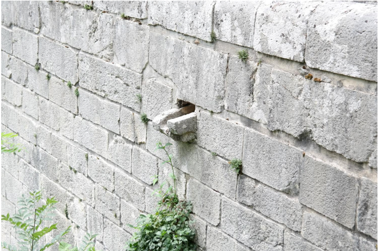
Pont Coppet, détail d'une gargouille
