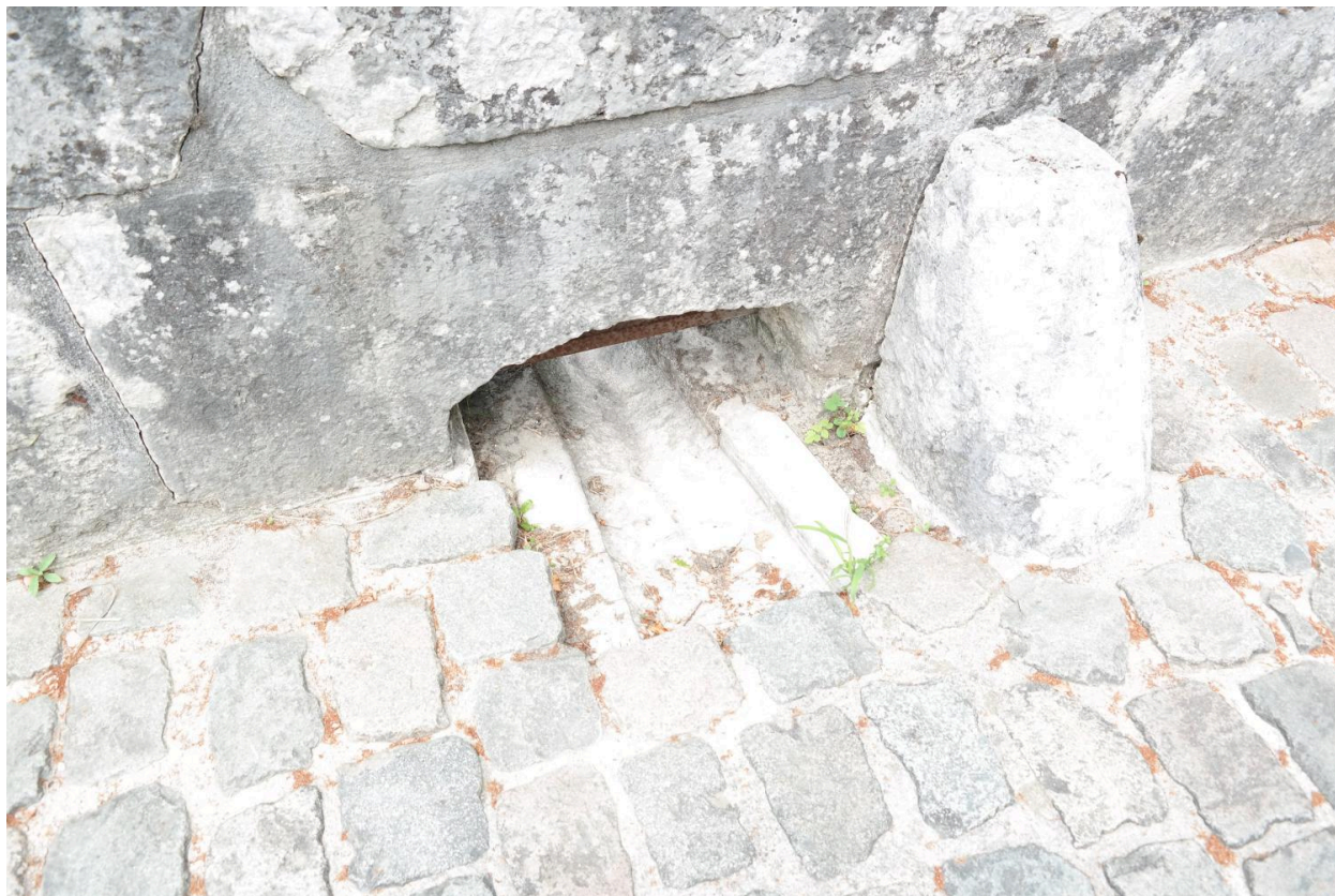
Pont Coppet, détail d'une gargouille depuis la chaussée
