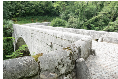
Pont Coppet, détail des parapets Phot. Pascale Renard IVR84_20207403159NUCA
