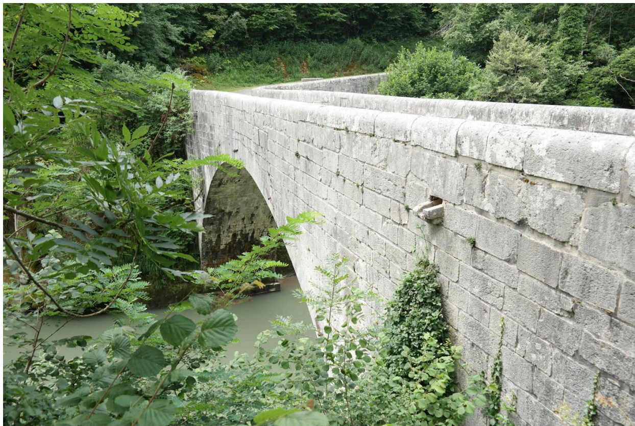
Pont Coppet, vue de la face aval
