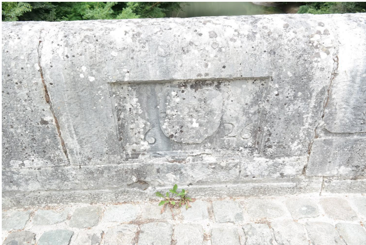
Pont Coppet, détail de l'écusson de la Maison de Savoie avec la date de 1626
