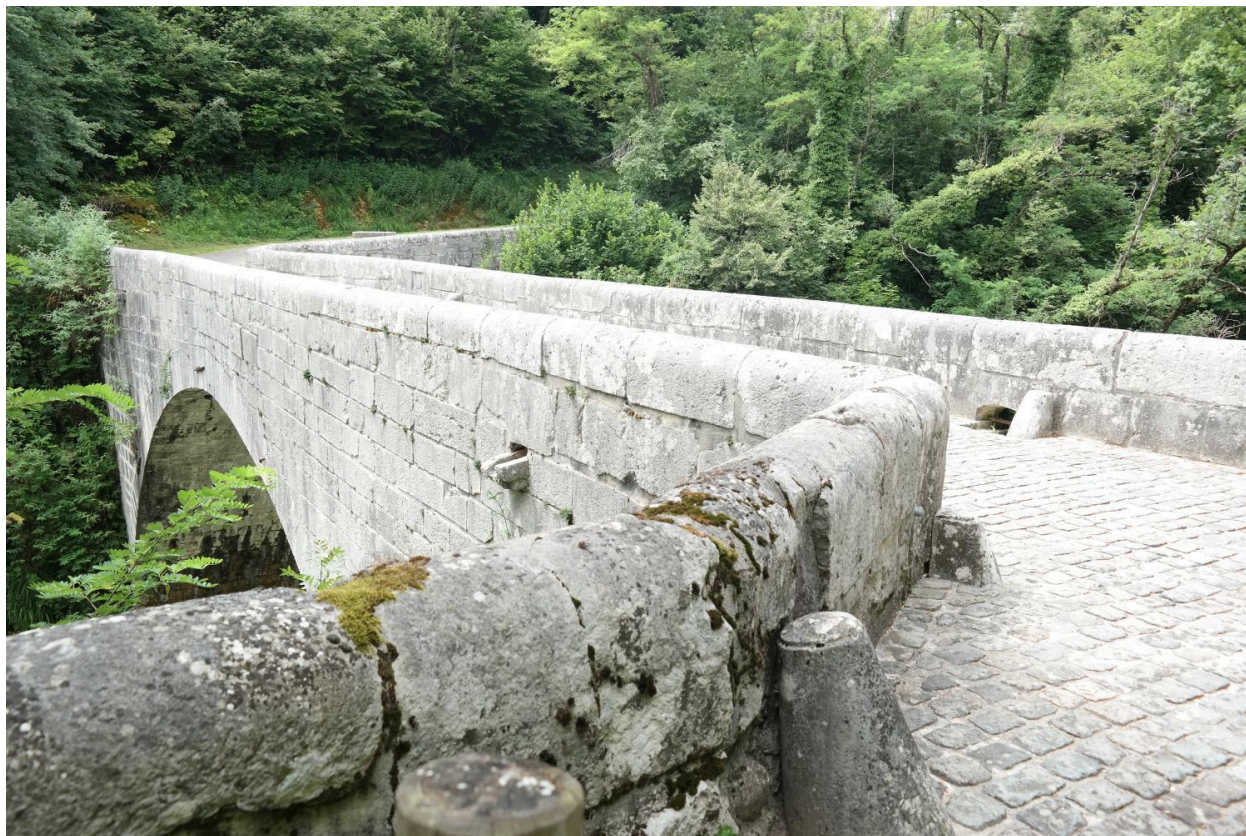
Pont Coppet, détail des parapets
