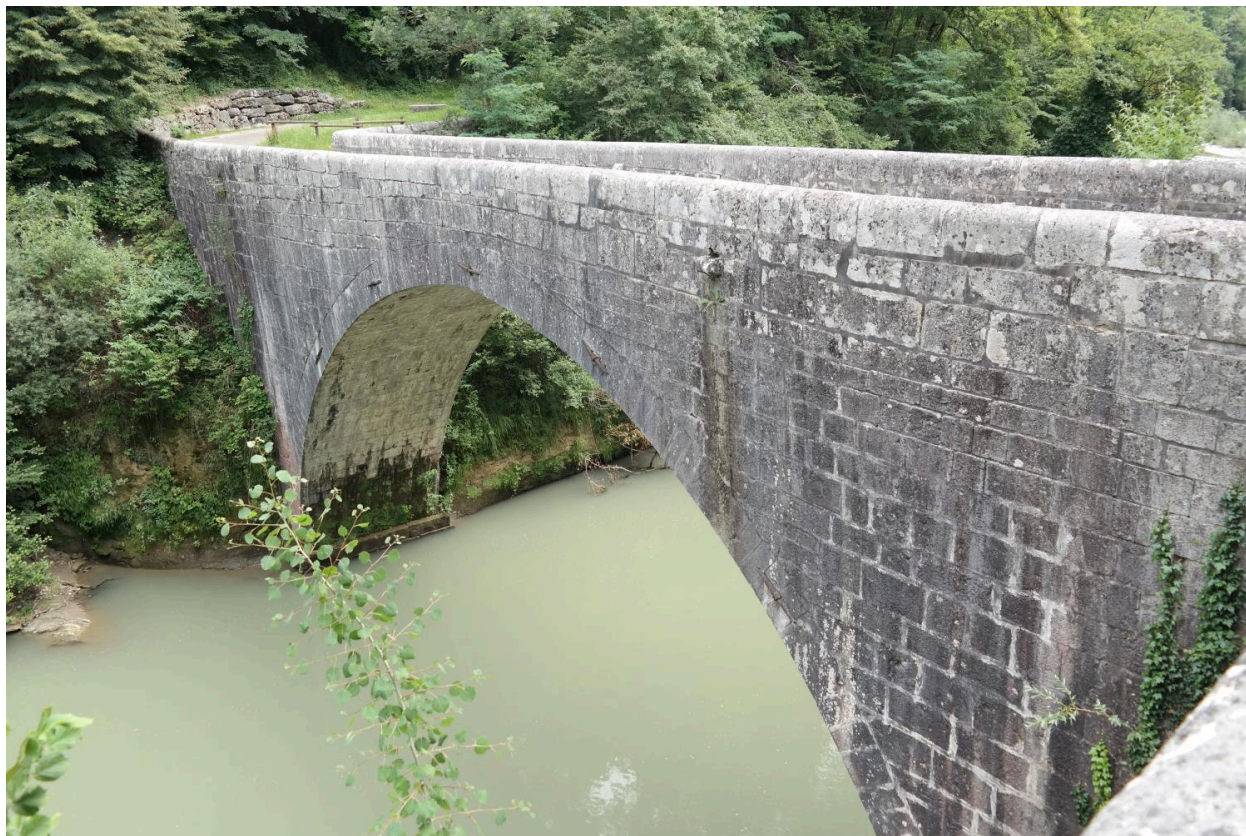
Pont Coppet, vue de la face amont
