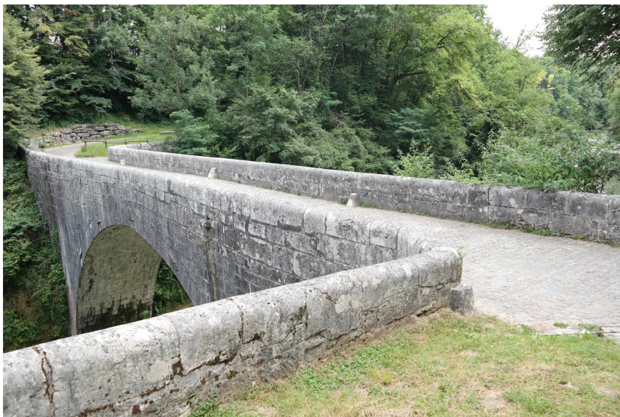
Pont Coppet, vue générale depuis la rive droite
