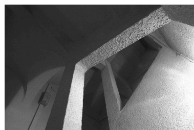
Deuxième étage d'escalier, vue prise depuis la première volée Phot. Bernard Ducouret IVR82_20056900422NUC
