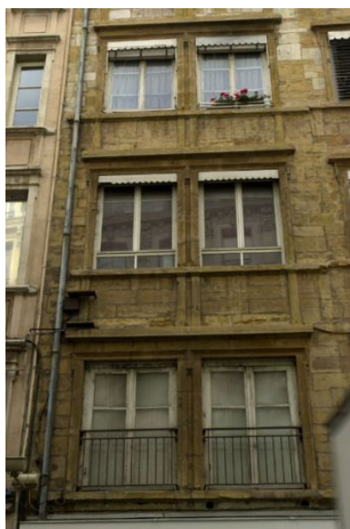
Façade rue de Brest, niveaux 2 à 4 Phot. Bernard Ducouret IVR82_20046900751NUCA
