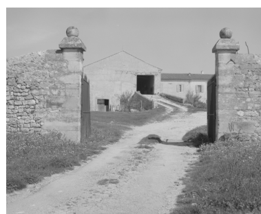
Portail d'entrée du domaine. Phot. Alain Franchella IVR82_20002600446X
