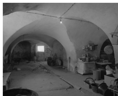
Vue partielle d'une dépendance voûtée : bergerie. Phot. Alain Franchella IVR82_20002600436X
