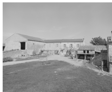
Vue d'ensemble du corps de logis et d'une partie des dépendances agricoles. Phot. Alain Franchella IVR82_20002600448X
