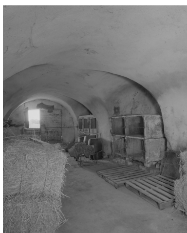
Vue partielle d'une dépendance voûtée à fonction multiple : écurie, étable et clapiers. Phot. Alain Franchella IVR82_20002600434X
