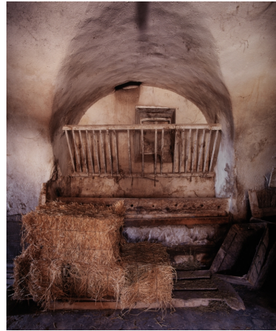
Ecurie : détail d'une mangeoire, de son râtelier et de la cheminée à fourrage. Phot. Alain Franchella IVR82_20002600438XA
