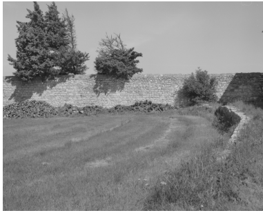
Détail du mur de clôture du domaine. Phot. Alain Franchella IVR82_20002600445X
