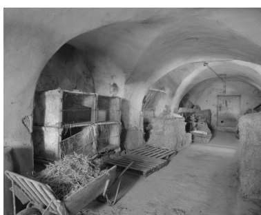
Vue partielle d'une dépendance voûtée à fonction multiple : écurie, étable et clapiers. Phot. Alain Franchella IVR82_20002600435X
