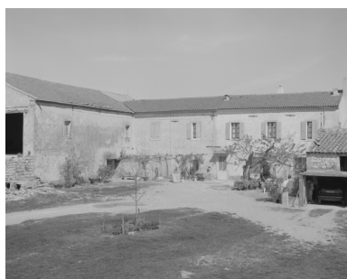
Corps de logis et vue partielle de la dépendance agricole contenant les étables, remise et fenil. Phot. Alain Franchella IVR82_20002600449X
