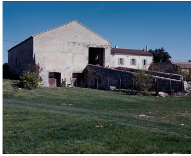
Vue de la rampe d'accès de la plus grande dépendance, menant à l'étage composé d'un fenil et d'une remise. Phot. Alain Franchella IVR82_20002600444XA
