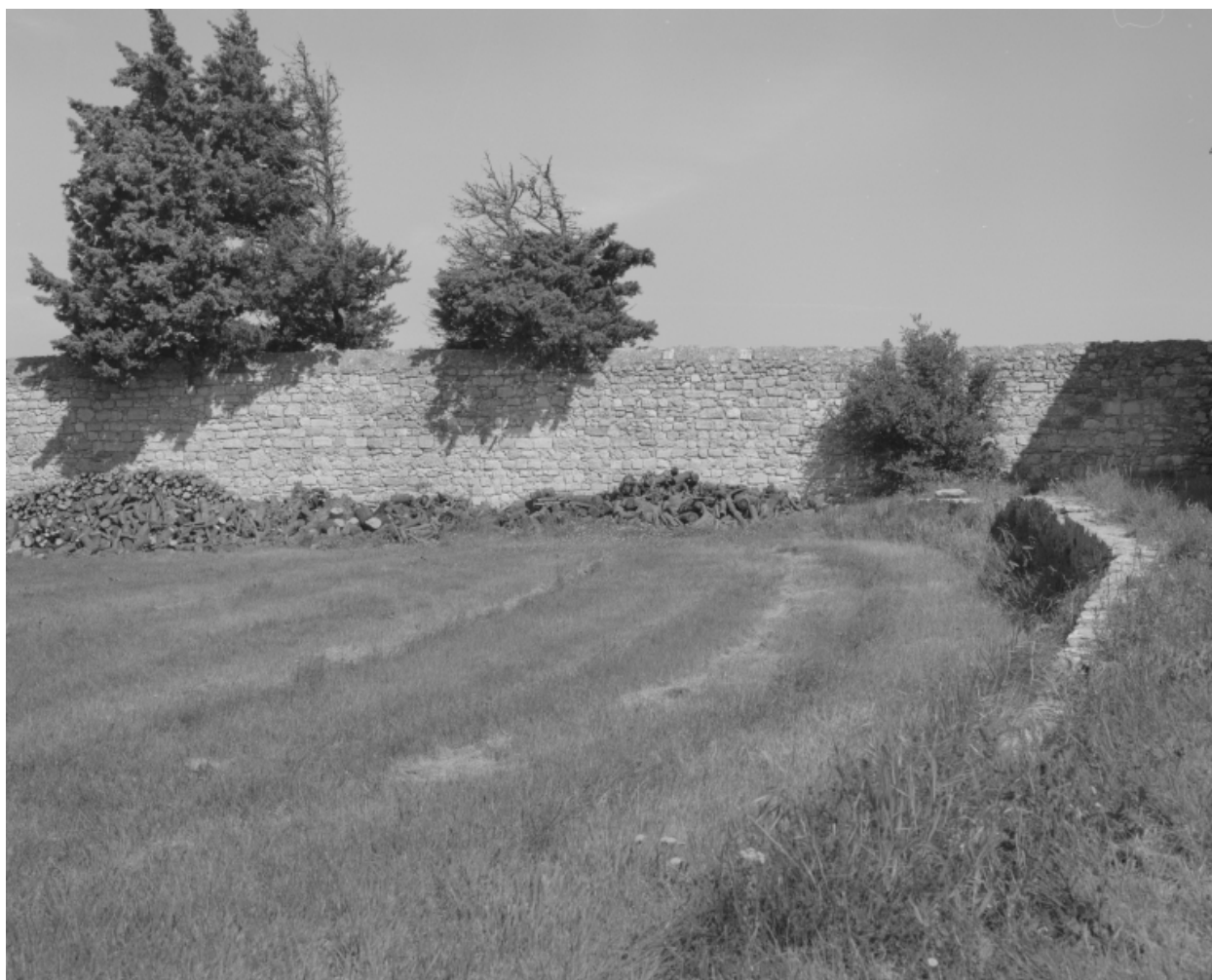
Détail du mur de clôture du domaine.
