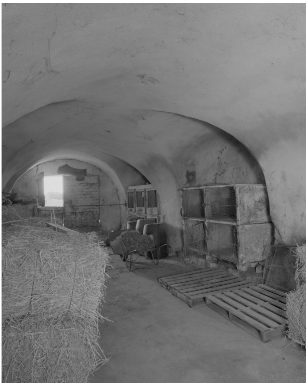
Vue partielle d'une dépendance voûtée à fonction multiple : écurie, étable et clapiers.
