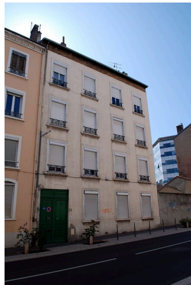
Immeuble voisin cadastre BS17 Phot. Véronique Belle IVR82_20096903462NUCA
