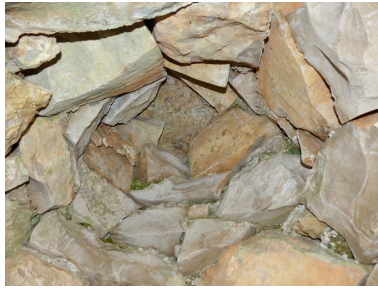
Couvrement en encorbellement. Phot. Alexeï Laurent IVR84_20162600235NUCA
