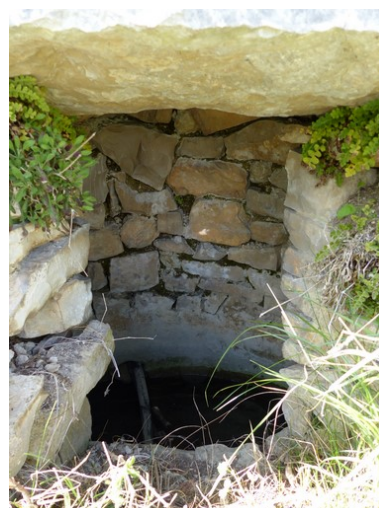
Vue de volume. Phot. Alexei Laurent IVR84_20162600233NUCA
