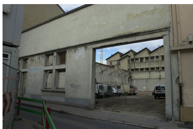
Vue derrière façade sud Phot. Nadine Halitim-Dubois IVR82_20016903195NUCA
