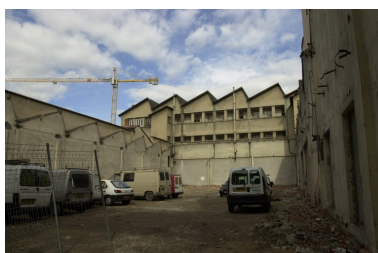
Site en cour de démolition Phot. Nadine Halitim-Dubois IVR82_20016903192NUCA
