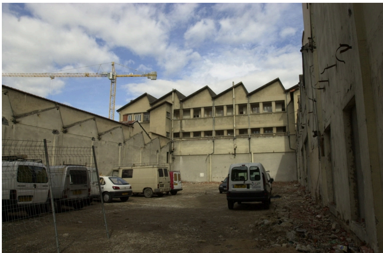
Site en cour de démolition
