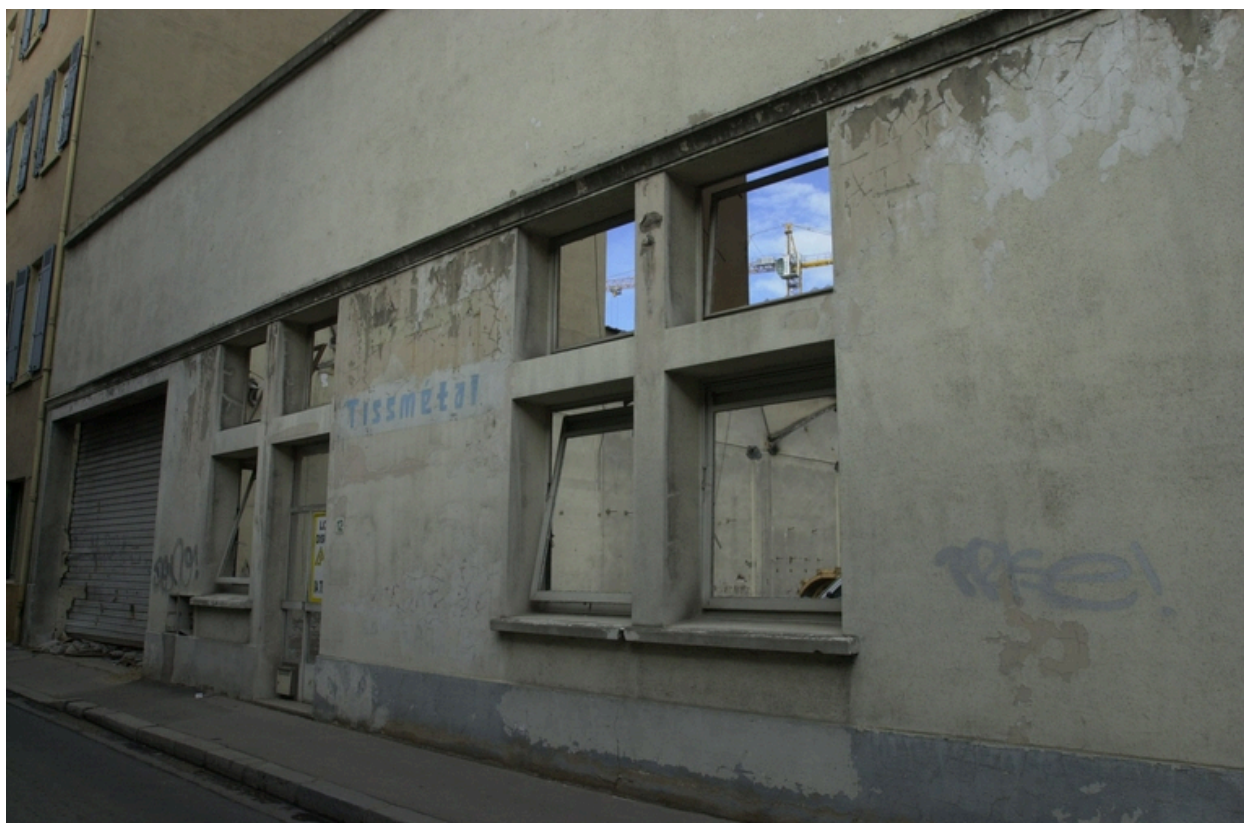
Vue d'ensemble sud avec enseigne 'Tissmétal'
