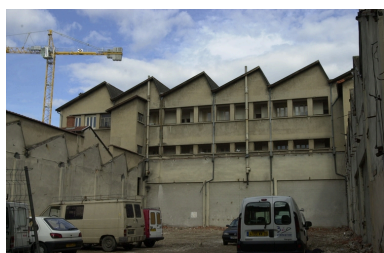
Détail bâtiment Phot. Nadine Halitim-Dubois IVR82_20016903191NUCA
