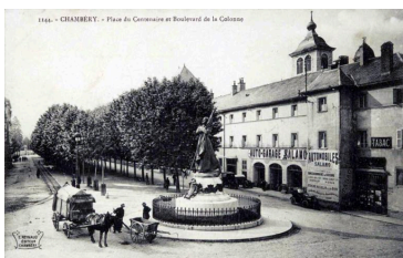
Façade sur le boulevard de la Colonne, début du 20e siècle (carte postale, AD Savoie, 2 FI 185)
