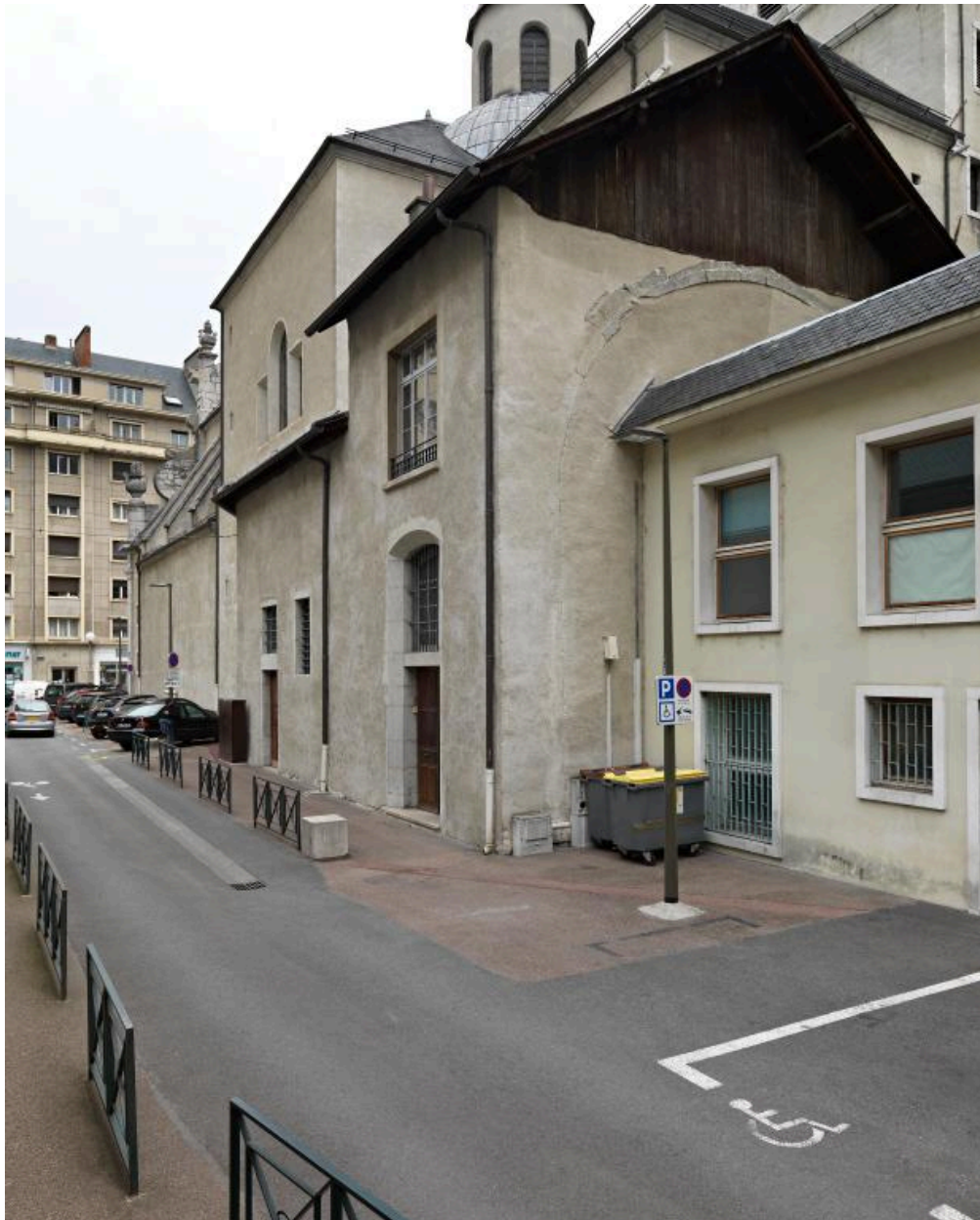
Vestige des bâtiments du collège : travée inscrite dans le prolongement du flanc sud de l'église Notre-Dame
