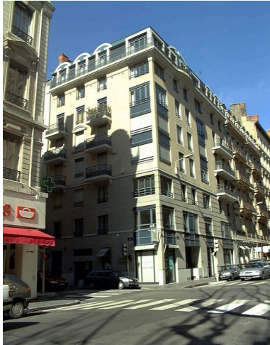
Vue générale des façades sur rue Phot. Bernard Ducouret IVR82_20016900823NUCA
