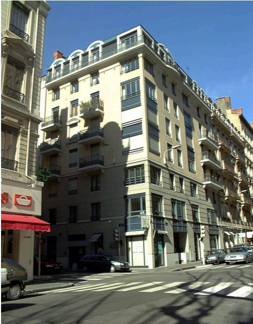
Vue générale des façades sur rue
