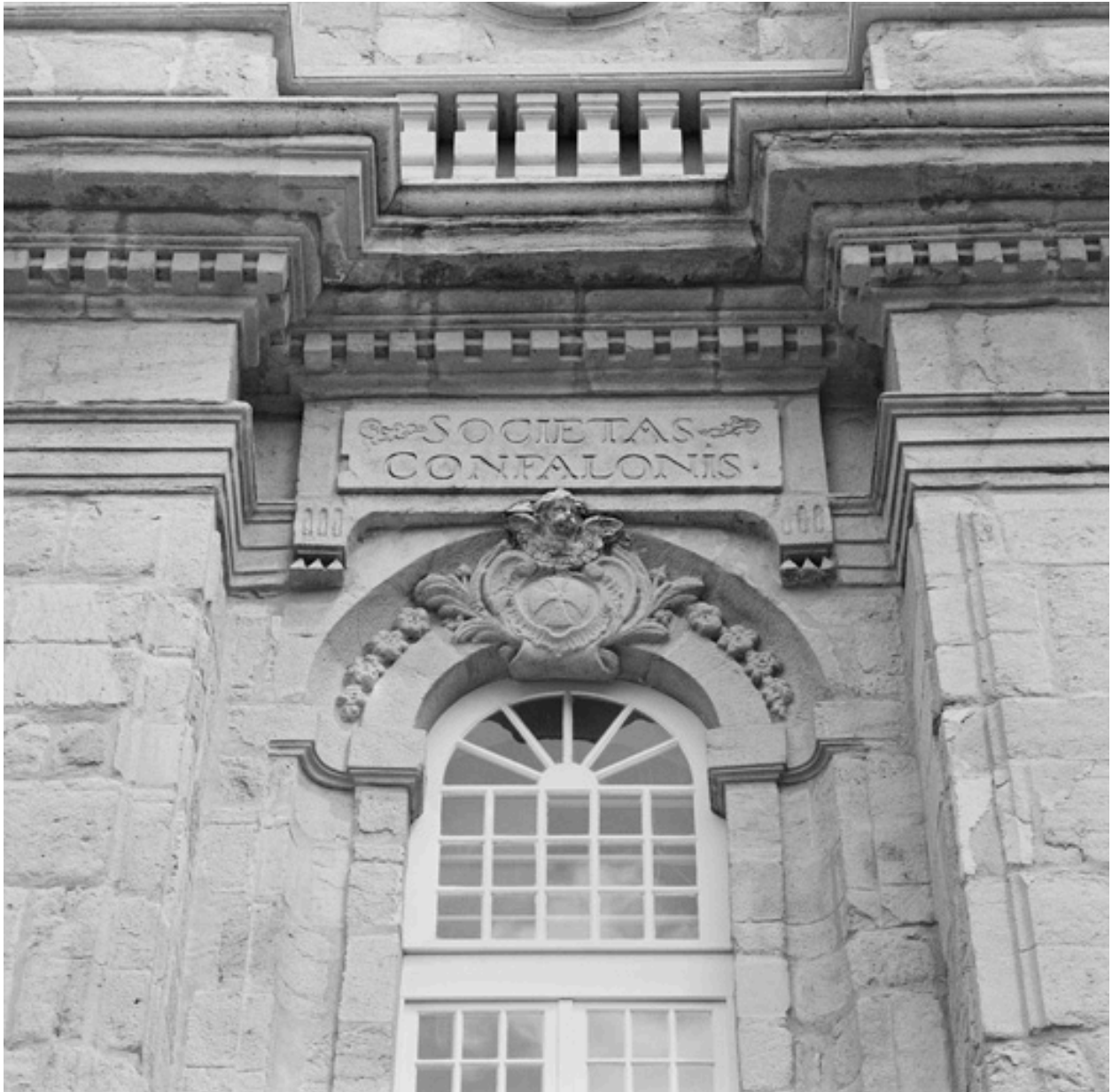
Baie axiale du 2e niveau, détail : titre et armoiries
