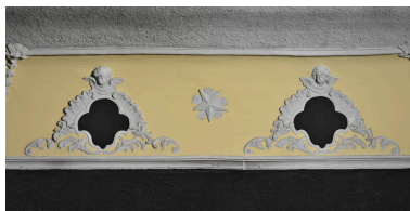
Corniche du plafond, abside, décor de stuc : étoile entre deux angelots.
