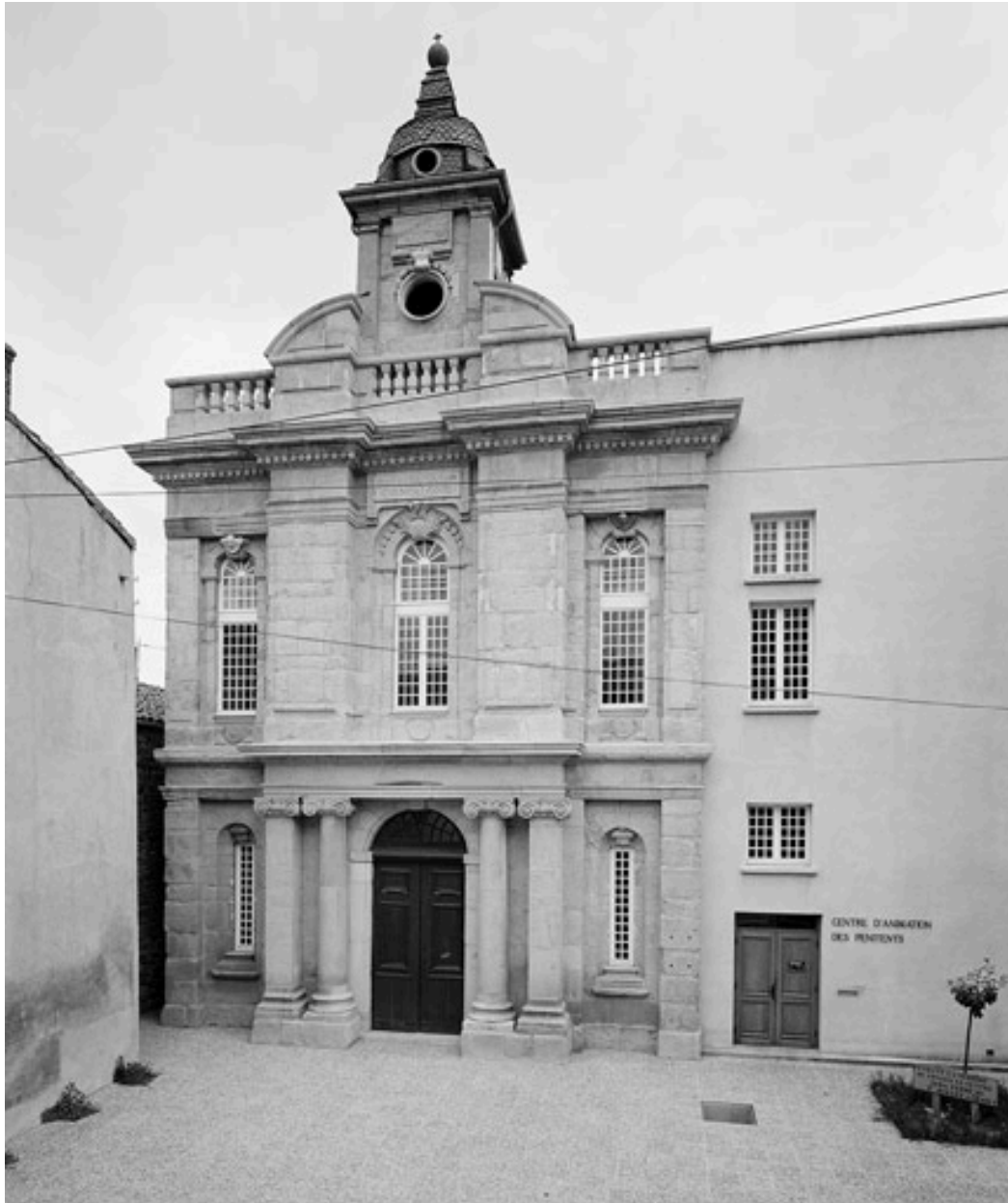
Façade, vue d'ensemble.
