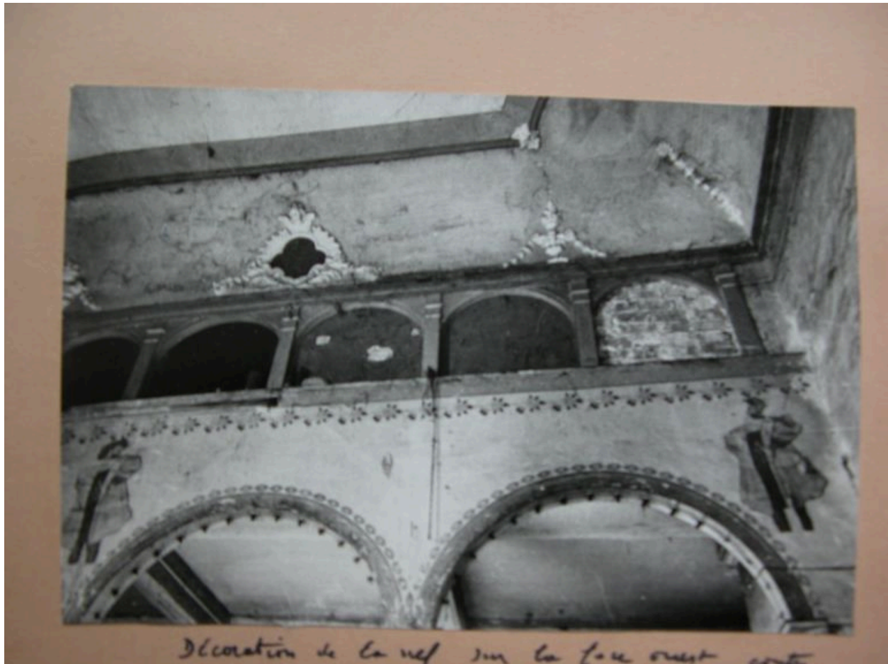
Décor du mur du fond en 1972, avant travaux. photographie argentique, 1972 AD Loire. 1111 VT 128
