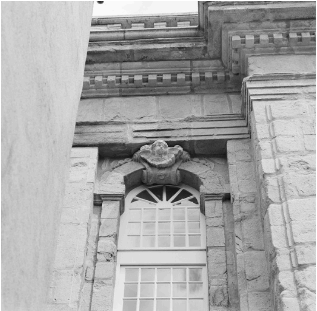
Façade, 2e niveau, baie latérale gauche, détail.
