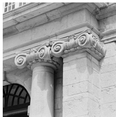
Portail, détail : chapiteaux et entablement Phot. Jean-Marie Refflé IVR82_19774200004X
