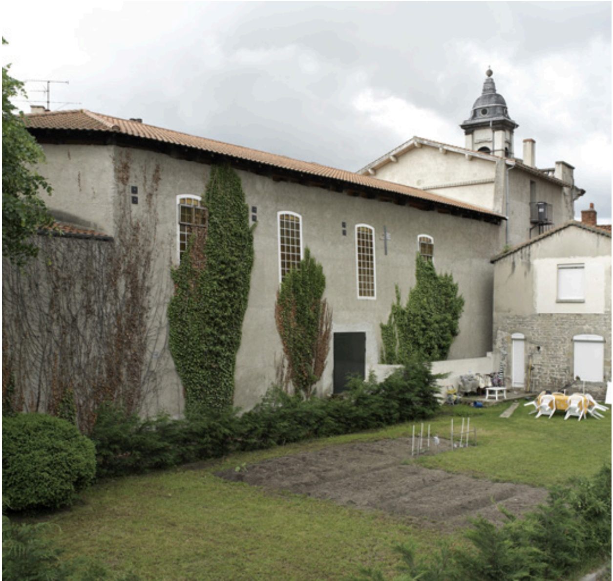
Vue de la chapelle depuis le nord-est.
