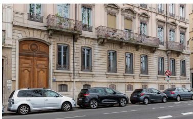
Le rez-de-chaussée Phot. Michel Pérès IVR84_20216900391NUCA
