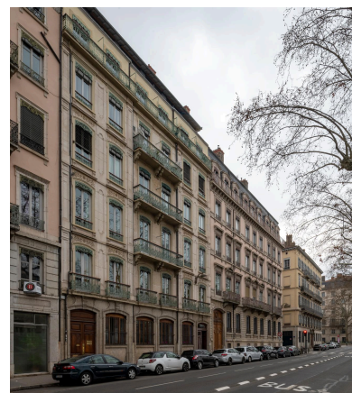
Vue de situation depuis le nord Phot. Michel Pérès IVR84_20216900388NUCA
