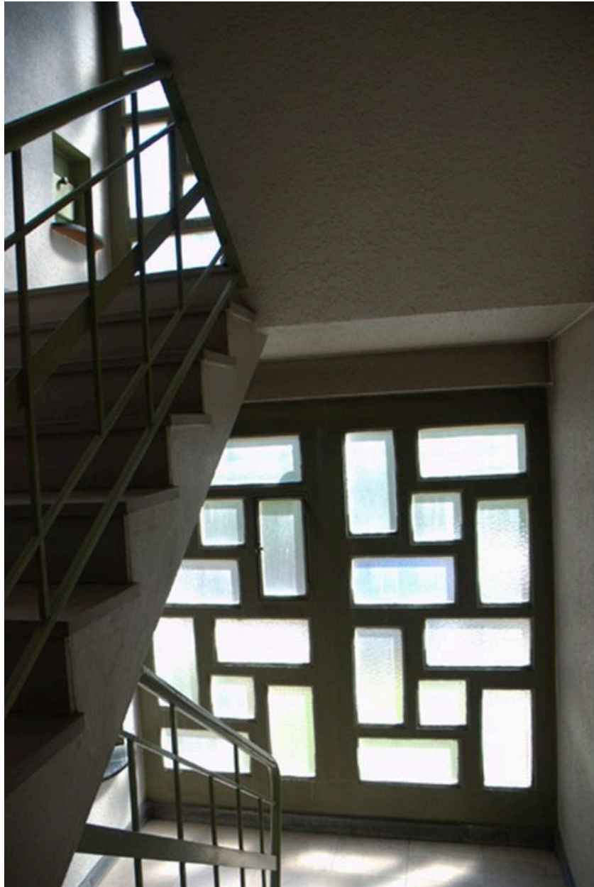
Une cage d'escalier éclairée par des panneaux de verres mécaniques
