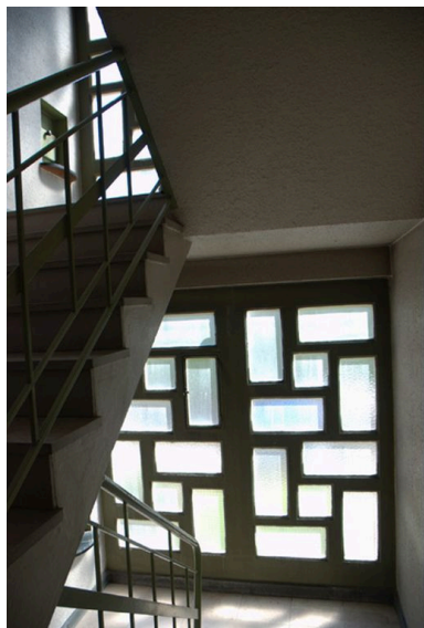
Une cage d'escalier éclairée par des panneaux de verres mécaniques Phot. Maryannick Chalabi IVR82_20086900866NUCA
