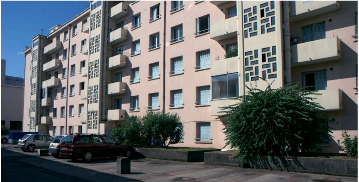
Elévation postérieure depuis le nord
