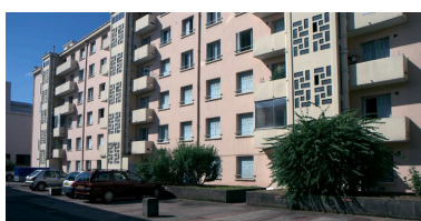
Élévation postérieure depuis le nord Phot. Maryannick Chalabi IVR82_20086900860NUCA
