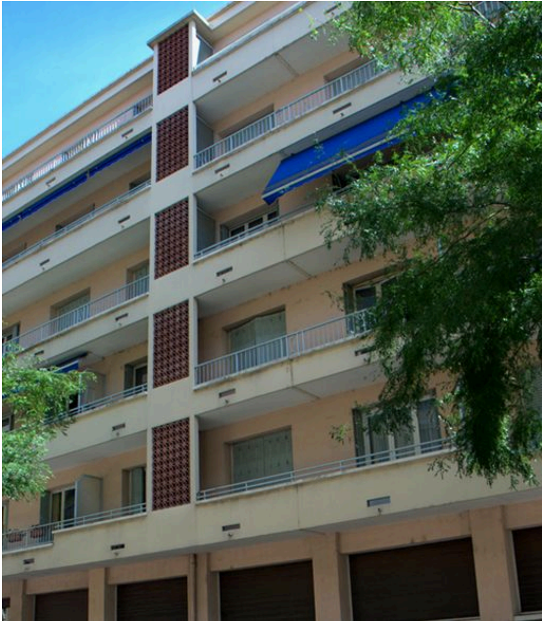
Travée de claustra sur la façade principale
