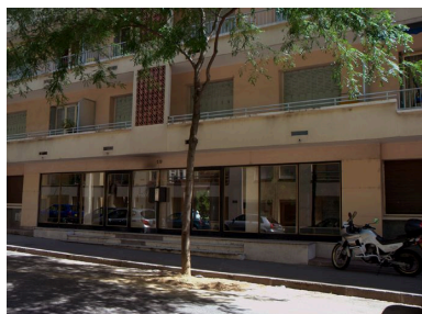
Vue de l'entrée Phot. Maryannick Chalabi IVR82_20086900858NUCA
