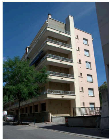
Élévation latérale droite Phot. Maryannick Chalabi IVR82_20086900861NUCA
