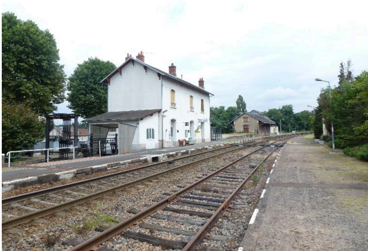
Gare de Vallon-en-Sully. (Photo chercheure).
