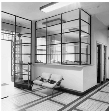
Sas d'accueil Phot. Didier Gourbin IVR82_20043800031X
