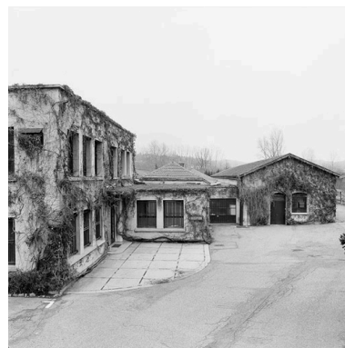
Vue d'ensemble, bâtiment administratif et ateliers Phot. Didier Gourbin IVR82_20043800001X
