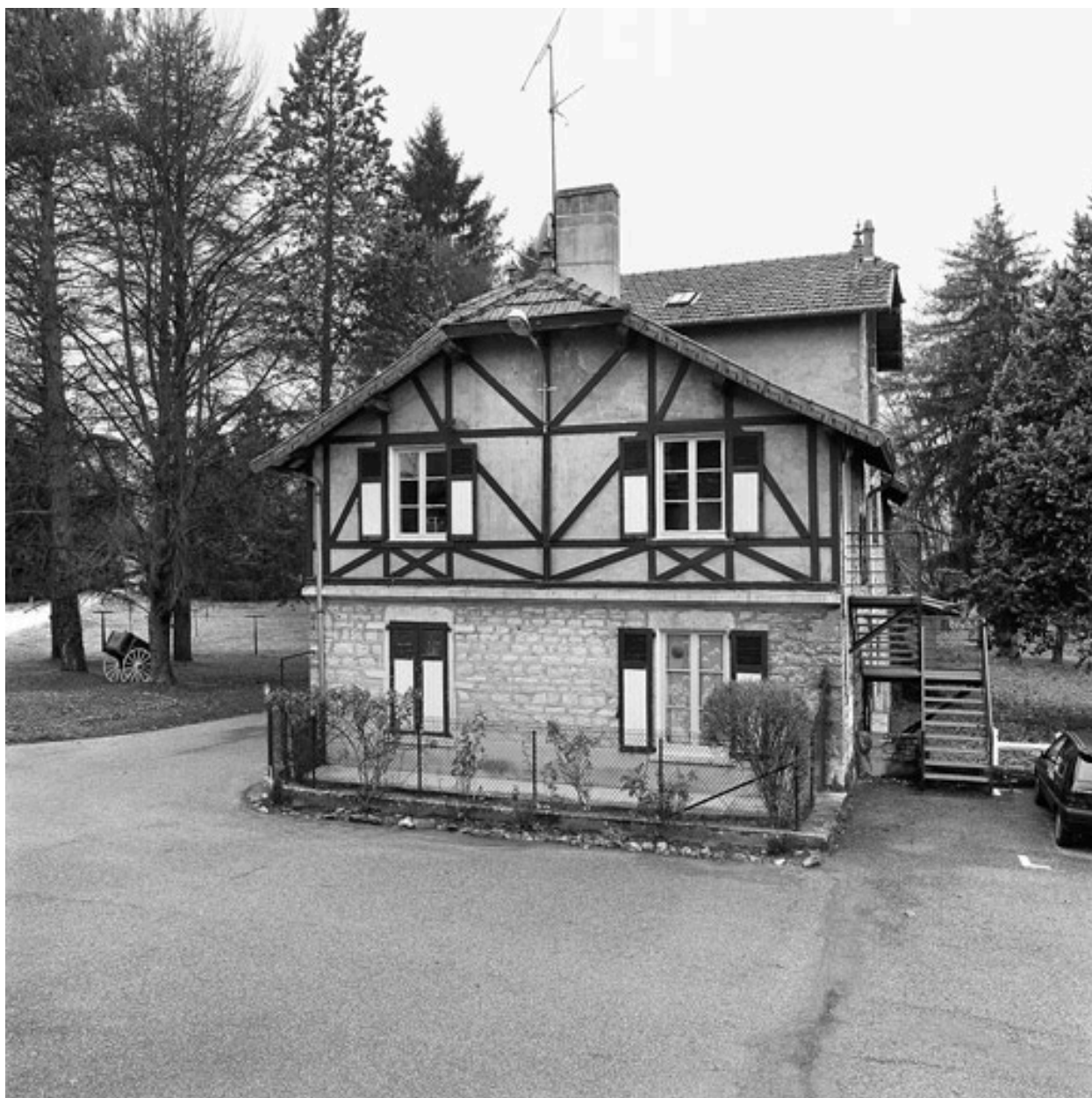
Pignon à colombages, maison du parc
