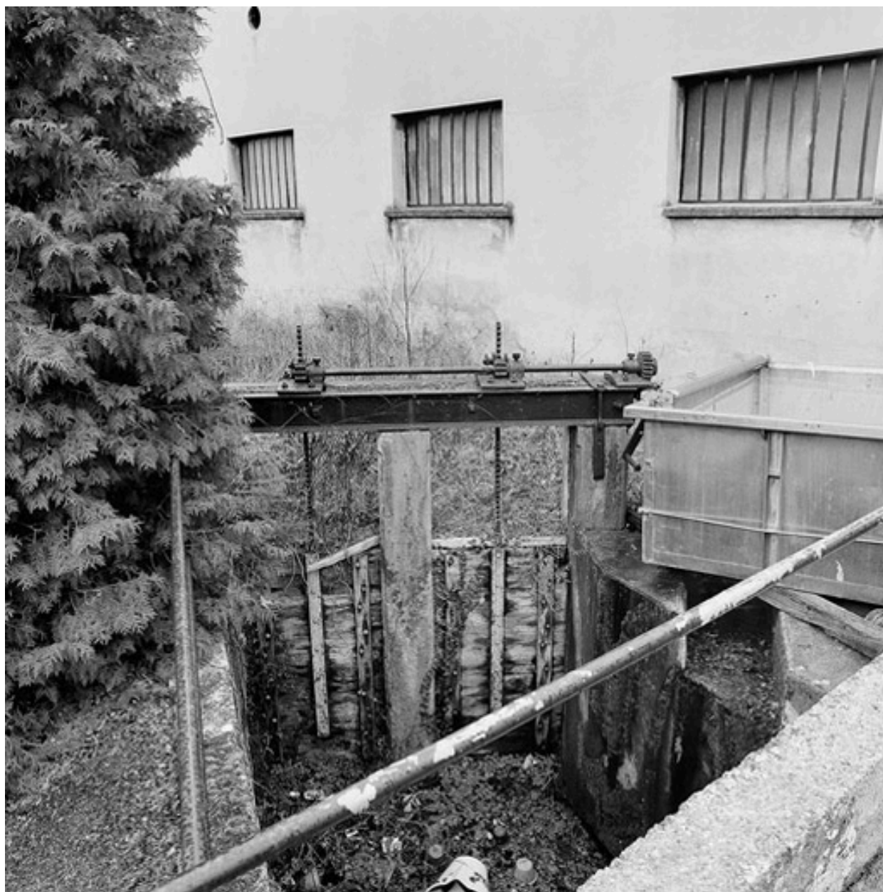
Détail bief (canal du mouturier)
