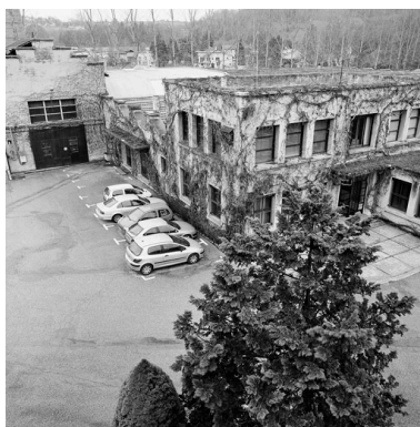
Vue d'ensemble bureaux-atelier Phot. Didier Gourbin IVR82_20043800051X
