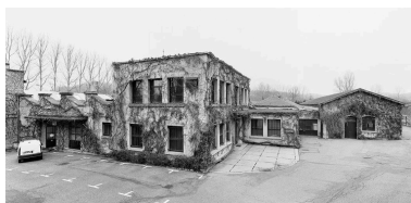
Vue générale nord Phot. Didier Gourbin IVR82_20043800100X
