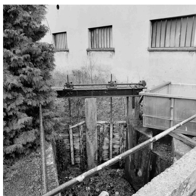
Détail bief (canal du mouturier) Phot. Didier Gourbin IVR82_20043800002X
