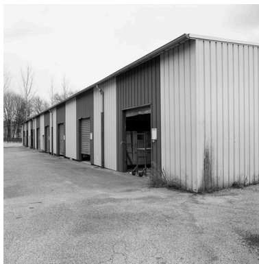
Entrepôt de stockage Phot. Didier Gourbin IVR82_20043800047X
