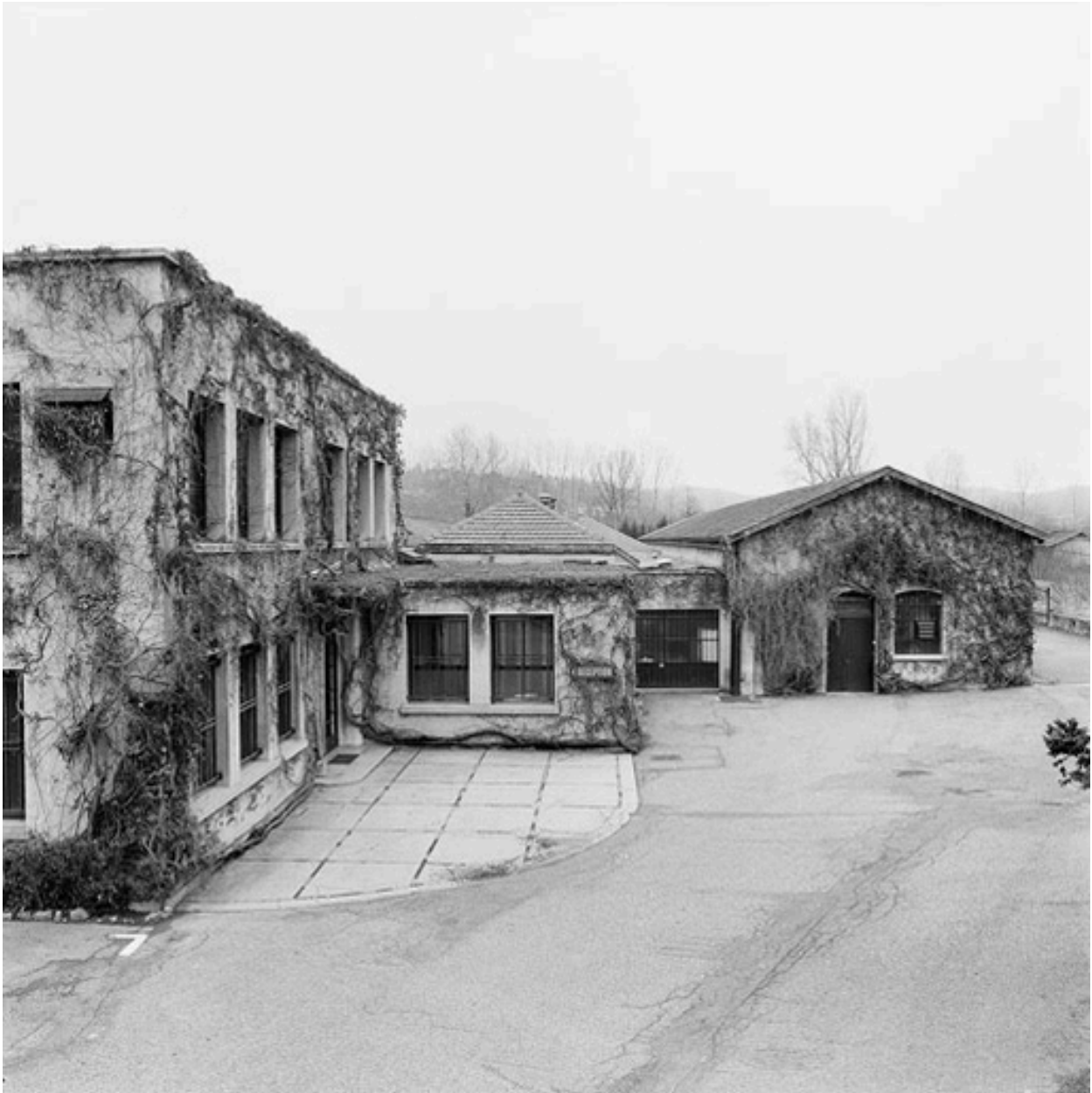
Vue d'ensemble, bâtiment administratif et ateliers
