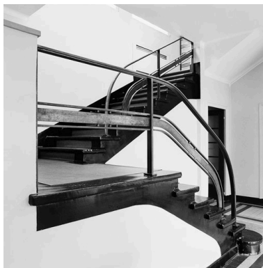
Escalier du bâtiment directorial Phot. Didier Gourbin IVR82_20043800027X
