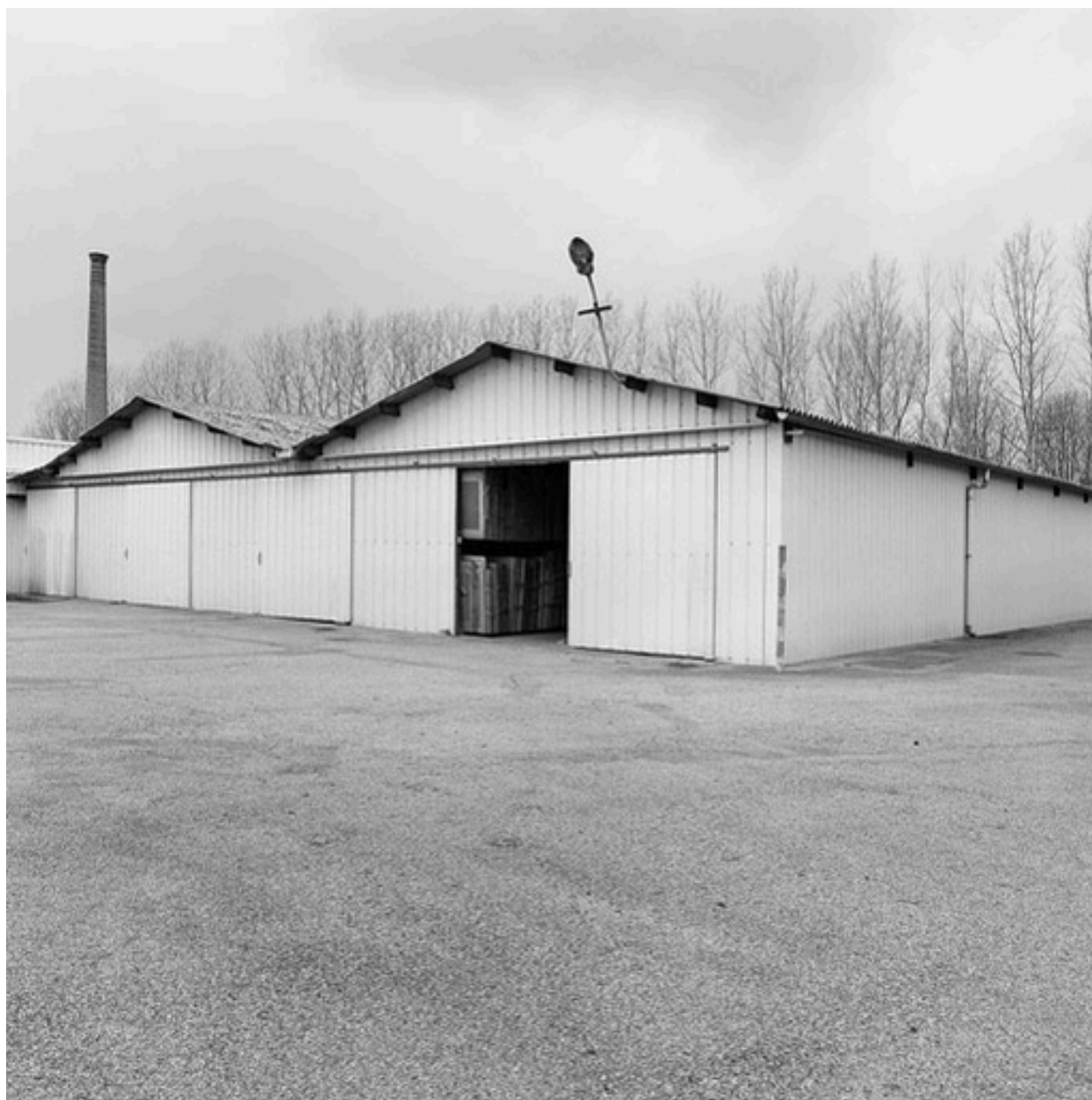
Entrepôt de stockage des cadres d'impression construit en 1990.
