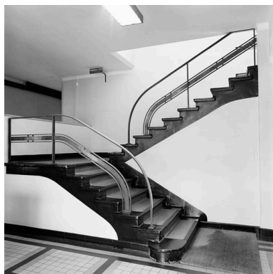
Vue sud de l'escalier du bâtiment directorial Phot. Didier Gourbin IVR82_20043800030X
