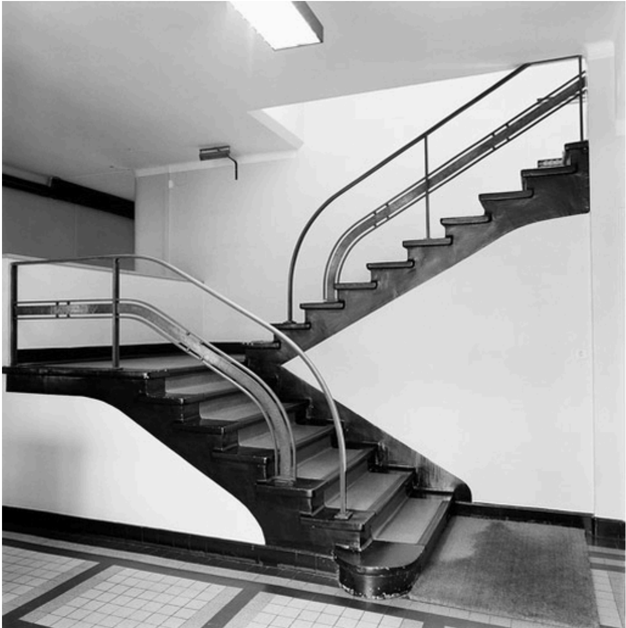
Vue sud de l'escalier du bâtiment directorial
