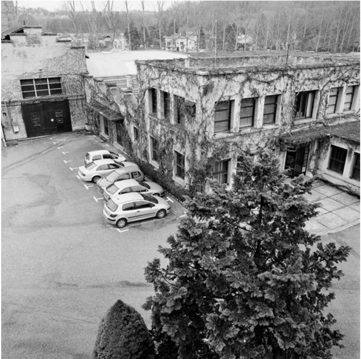
Vue d'ensemble bureaux-atelier
