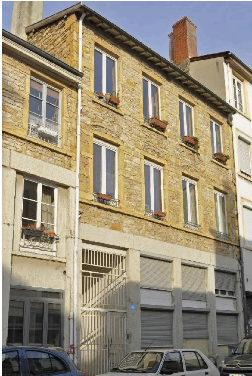
immeuble sur rue, élévation antérieure
