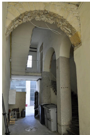
Immeuble sur rue, passage cocher et première volée d'escalier décalée Phot. Magali Delavenne IVR84_20166902220NUCA
