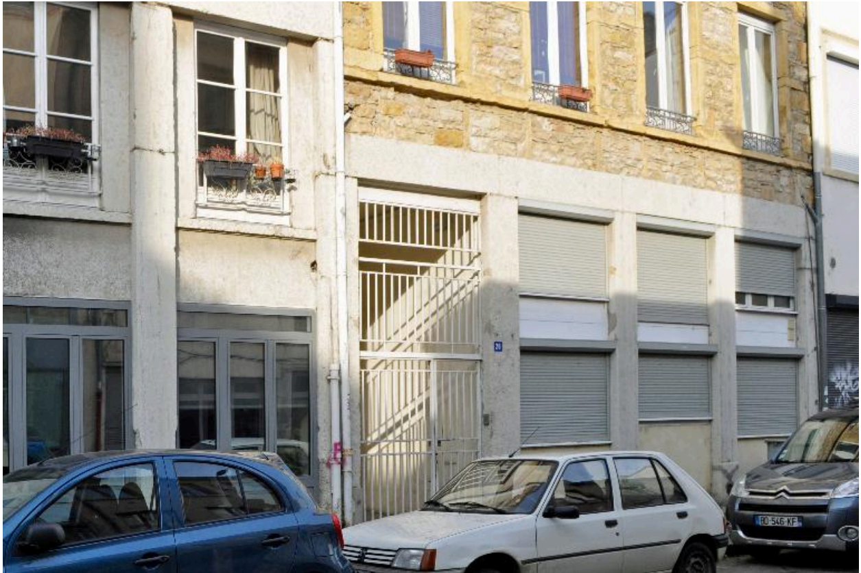
Immeuble sur rue, rez-de-chaussée
