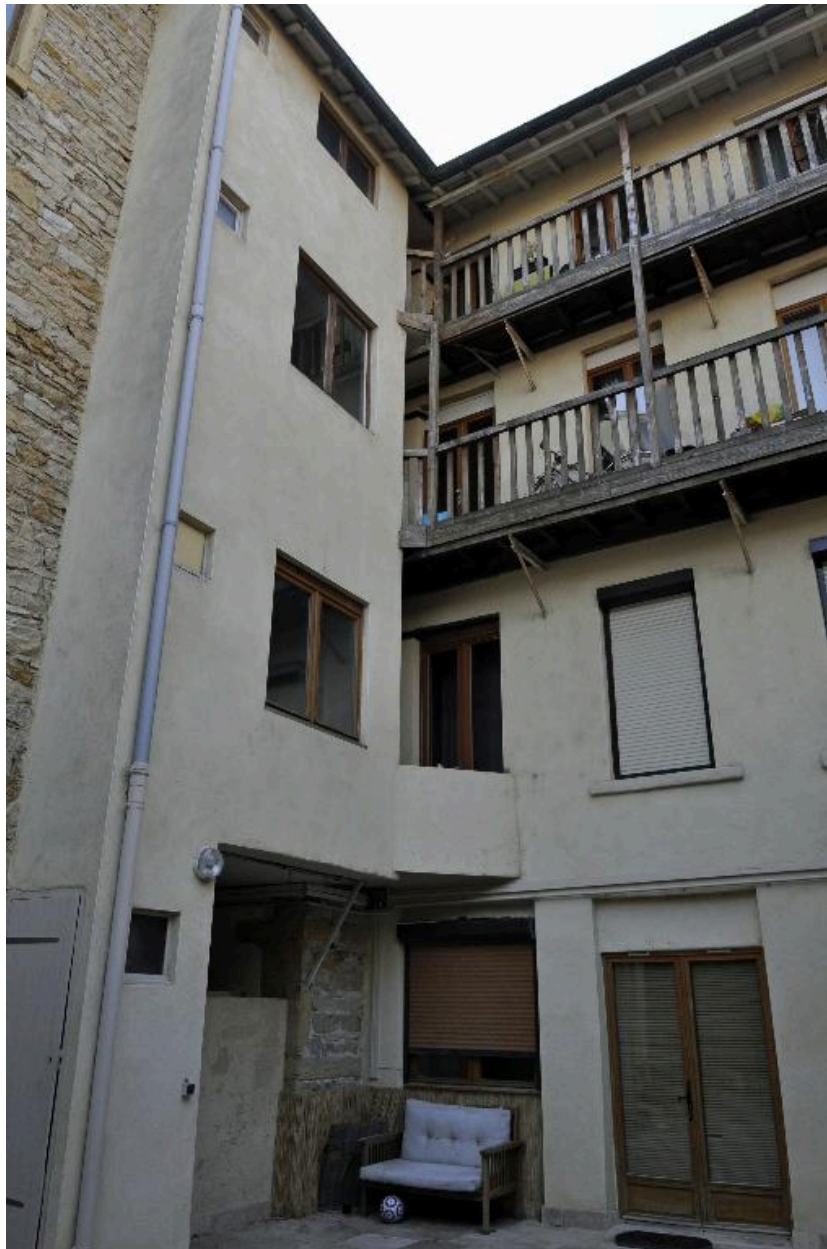
Cour : escalier et coursières en bois distribuant l'immeuble sur cour
