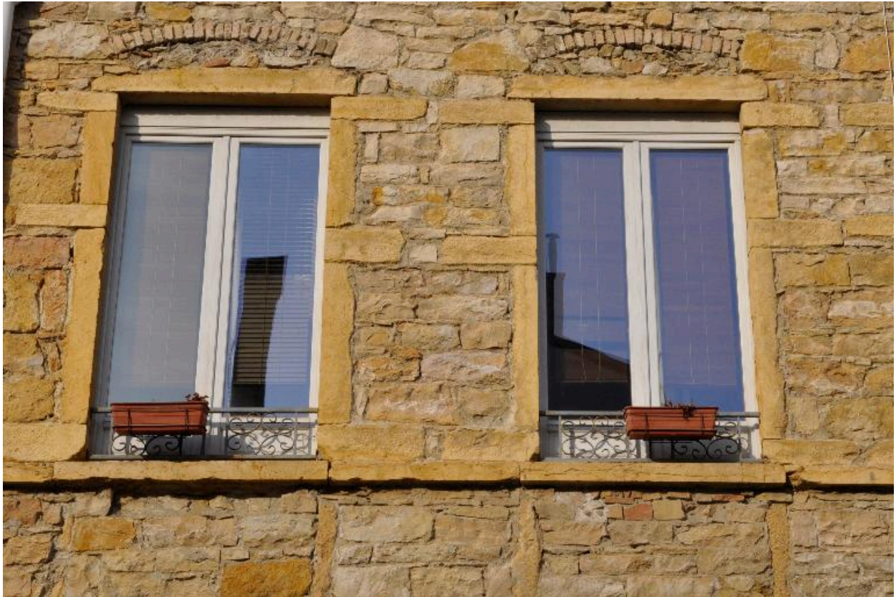
Immeuble sur rue, détail des fenêtres
