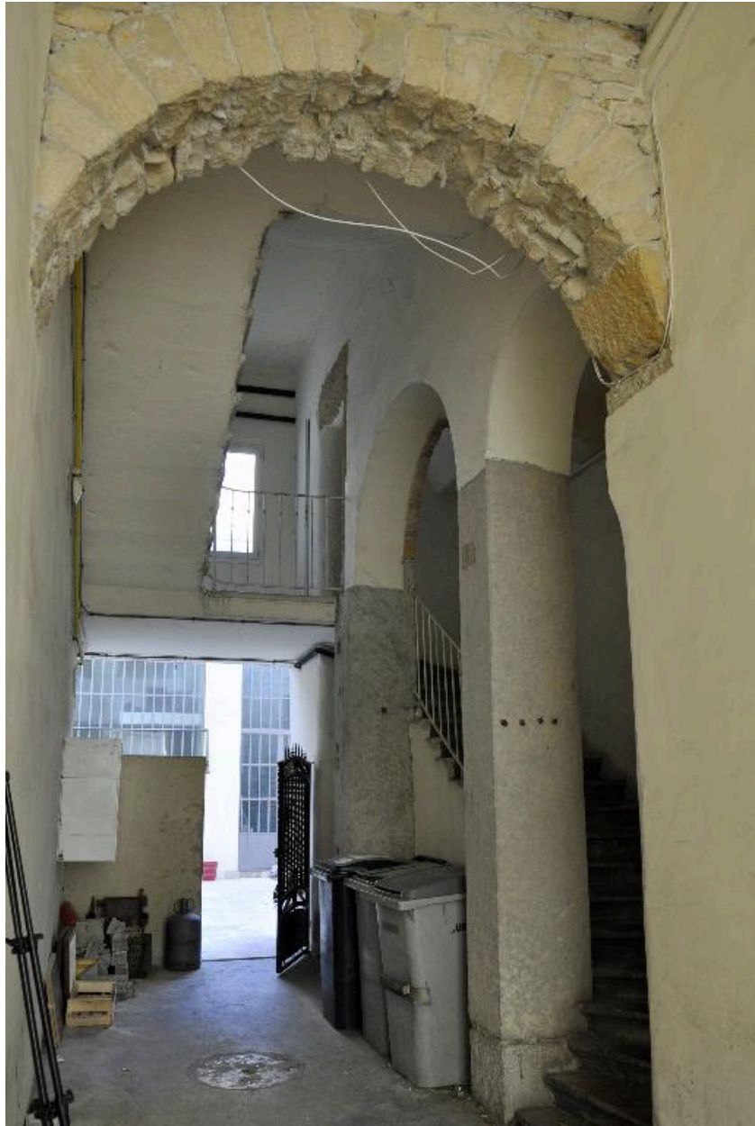
Immeuble sur rue, passage cocher et première volée d'escalier décalée
