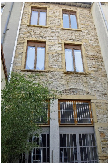
Immeuble sur rue, vue partielle de l'élévation postérieure Phot. Magali Delavenne IVR84_20166902218NUCA
