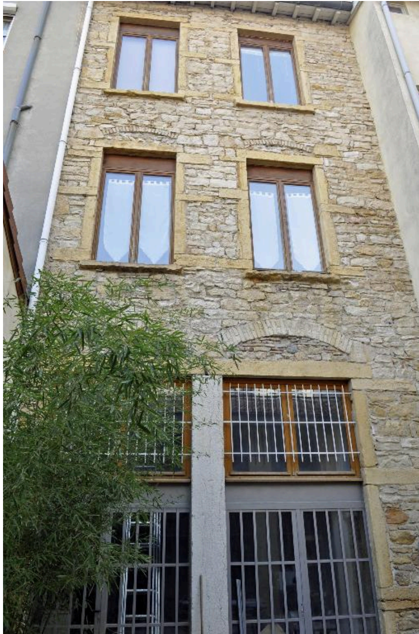
Immeuble sur rue, vue partielle de l'élévation postérieure
