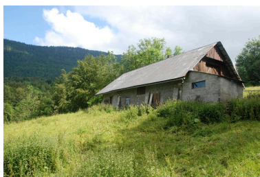
Vue arrière. Phot. Caroline Guibaud IVR84_20177301225NUCA
