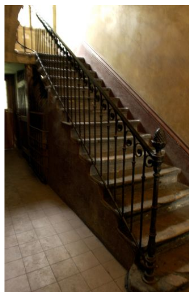
Vue de la montée d'escalier Phot. Maryannick Chalabi IVR82_20016900232NUCA
